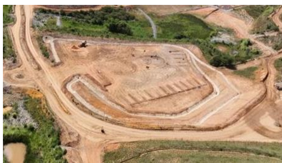
Figura 1 – Conclusão da descaracterização das estruturas ADP8 e AAS1
