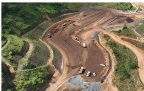
Figura 5 - Contrapilhamento O.E Dique Principal
