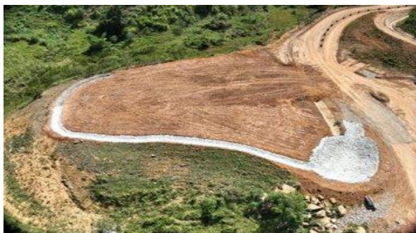
Figura 1 – Conclusão da descaracterização das estruturas ADP8 e AAS1
