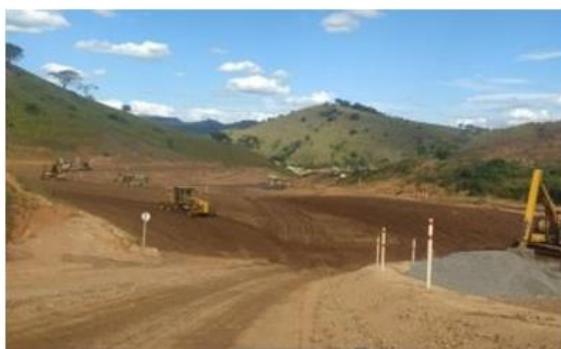
Figura 5 - Contrapilhamento O.E Dique Principal
