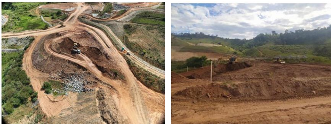
Figura 3 - Remoção de sedimentos da estrutura ASS4
