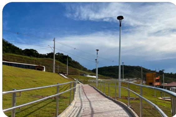
Foram feitas a drenagem, o talude e parte do calçamento. As obra das escadas que dão acesso à praça estão em andamento, assim como o concreto do piso onde serão instalados os brinquedos e o plantio de vegetação no talude. Quando todas essas obras terminarem, será feita a iluminação da praça.
