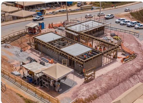
A fundação está concluída e o foco agora é na alvenaria e na preparação da estrutura para receber a laje de cobertura.
