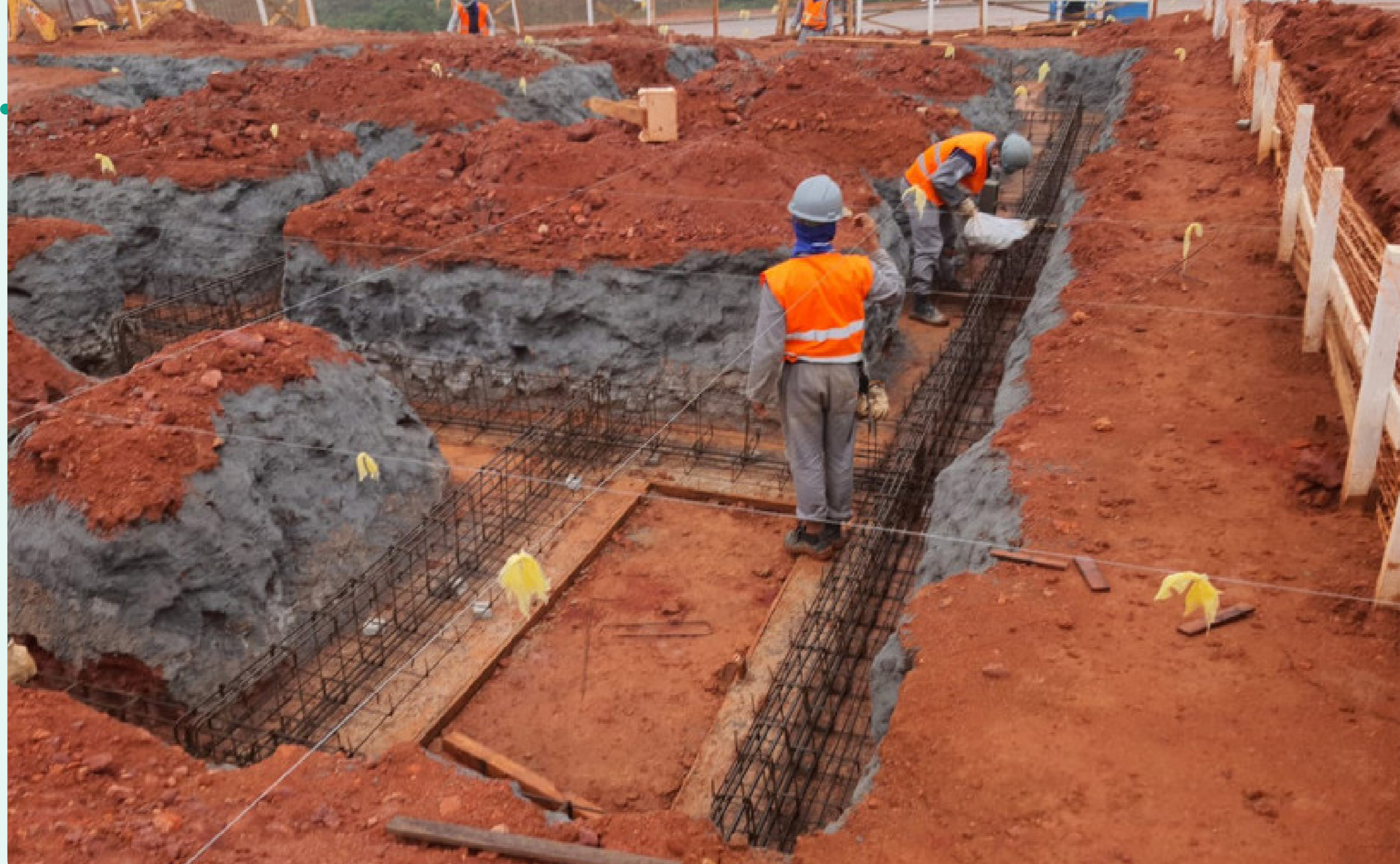
Início da fundação de outro imóvel
