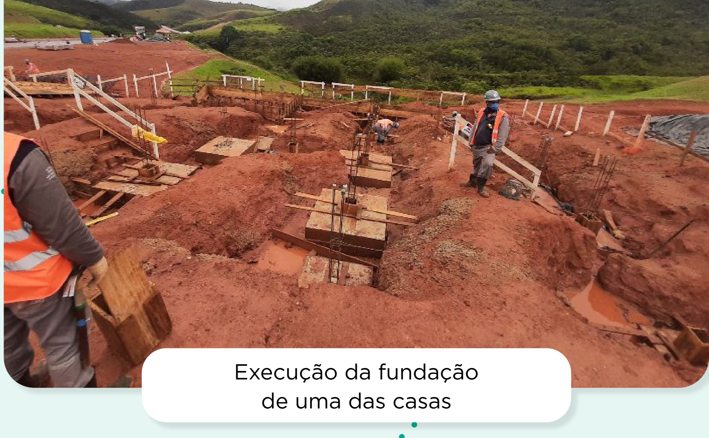
Execução da fundação de uma das casas
