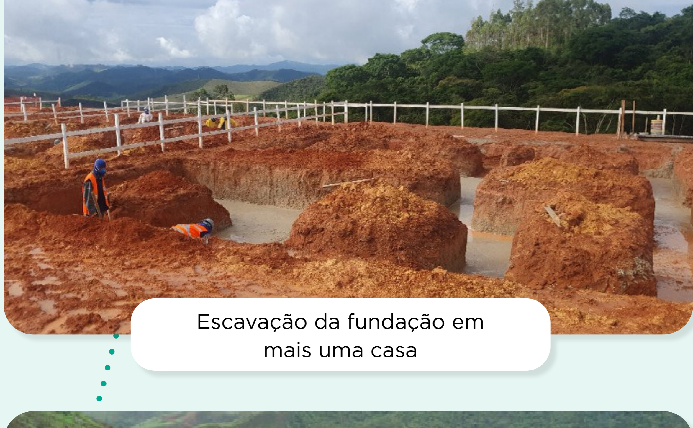
Escavação da fundação em mais uma casa
