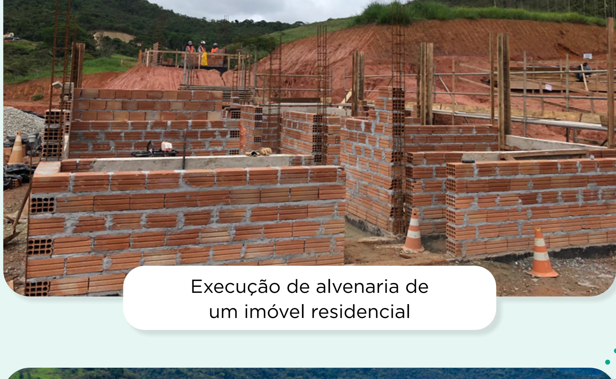
Execução de alvenaria de um imóvel residencial
