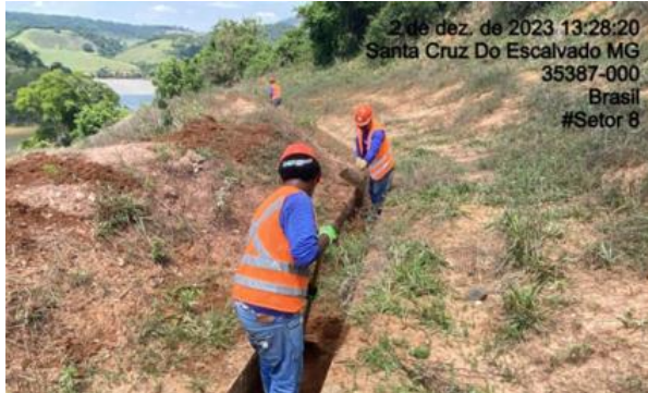
Figura 1 - Limpeza de canaleta setor 8 / Execução de leiras platô contrapilamento OE setor 11
