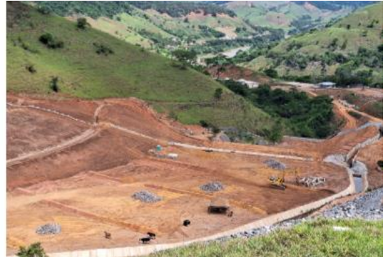
Figura 1 - Limpeza de canaleta setor 8 / Execução de leiras platô contrapilamento OE setor 11
