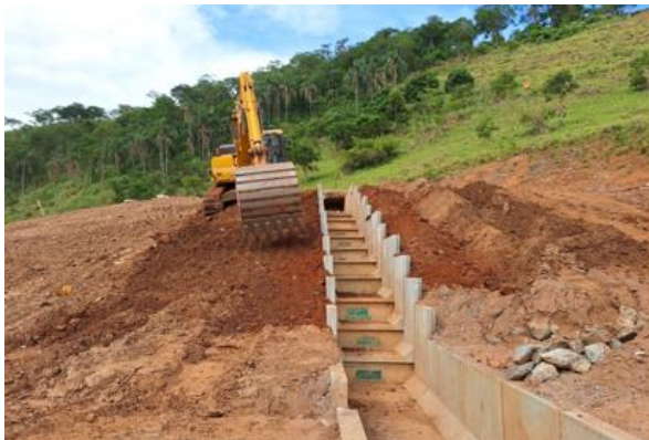
Figura 2 - Remoção de erosão bordas DAD OE / Limpeza SUMP bacia 4
