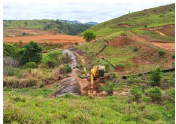
Figura 2 - Remoção de erosão bordas DAD OE / Limpeza SUMP bacia 4
