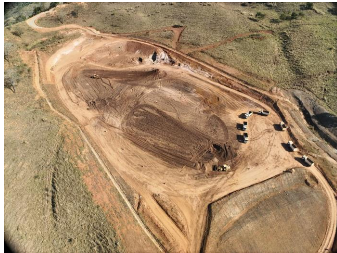
Figura 2 - Em andamento descaracterização das estruturas ADME-2
