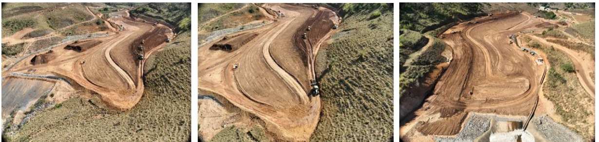
Figura 5 - Contrapilhamento O.E Dique Principal
