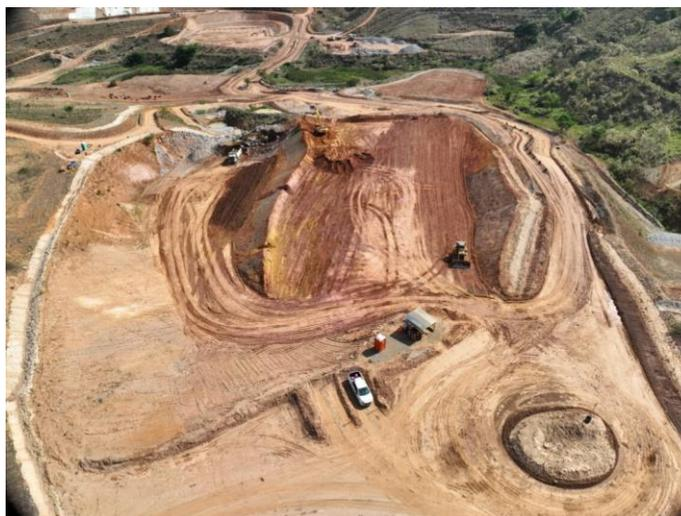
*Figura 1 – Descaracterização das estruturas ASS2 em fase final de acabamento*
