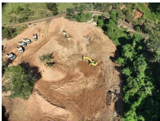
Figura 2 – Remoção de sedimentos setor 5
