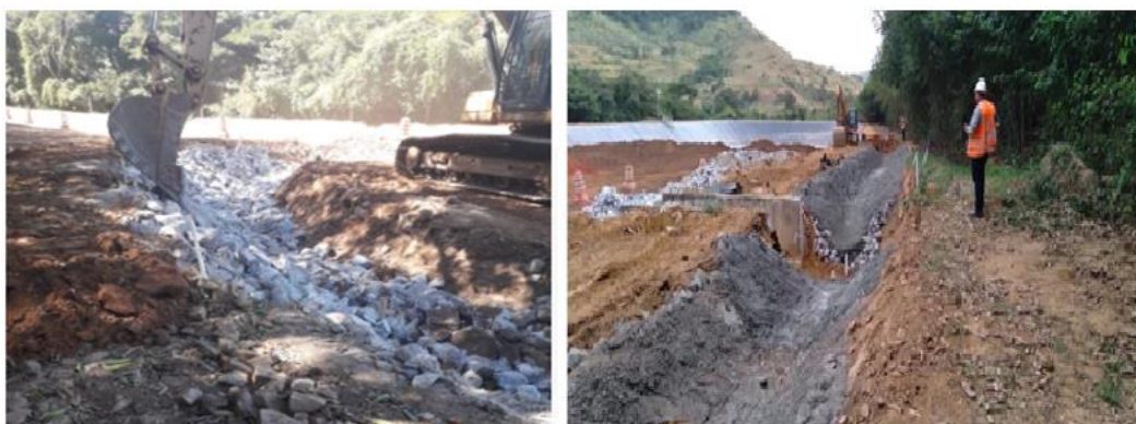
Figura 5 - Canal periférico – Bacia 1
