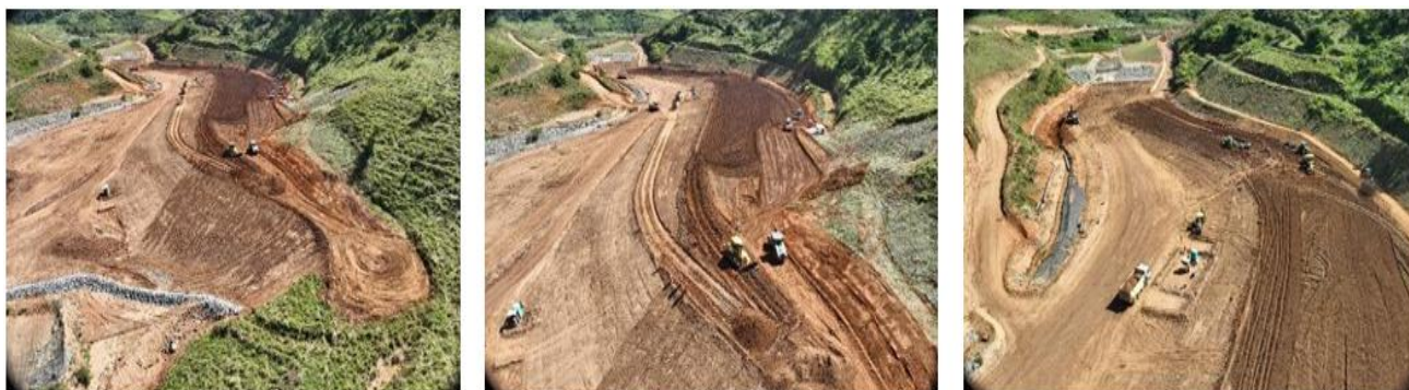
Figura 4 - Contrapilhamento O.E Dique Principal
