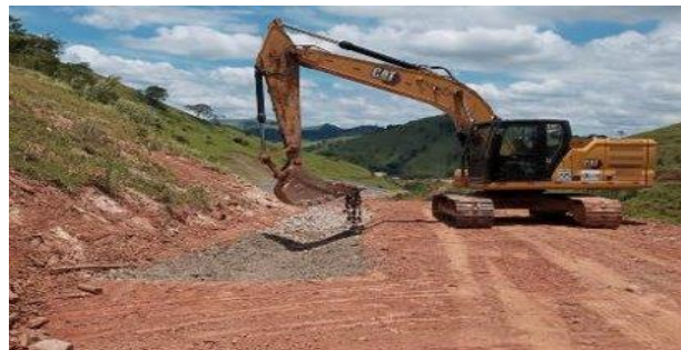
Figura 6 - Canal periférico (CP) - Berma de Equilíbrio
