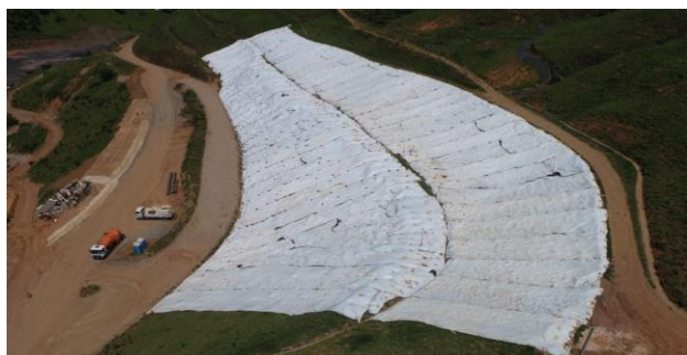
Figura 5 - Proteção superficial com manta - ADMEA
