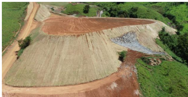
Figura 3 - Hidrossemeadura - Bacia 4
