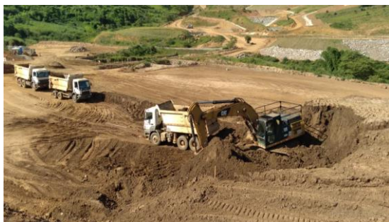
Figura 1 – Remoção de sedimentos da estrutura ADP1 / AAS1 para Bacia 2
