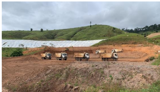
Figura 1 – Remoção de sedimentos da estrutura ADP1 / AAS1 para Bacia 2
