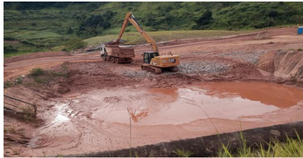
Figura 4 - Limpeza de Sump - Setor 11
