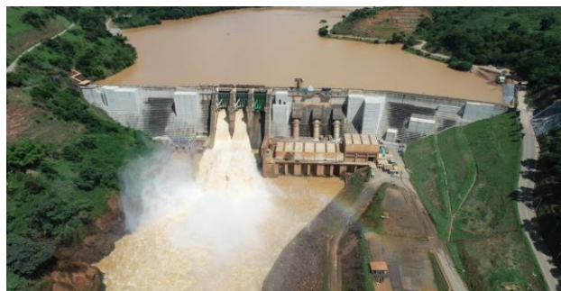
Figura 7 - Limpeza reservatório UHE
