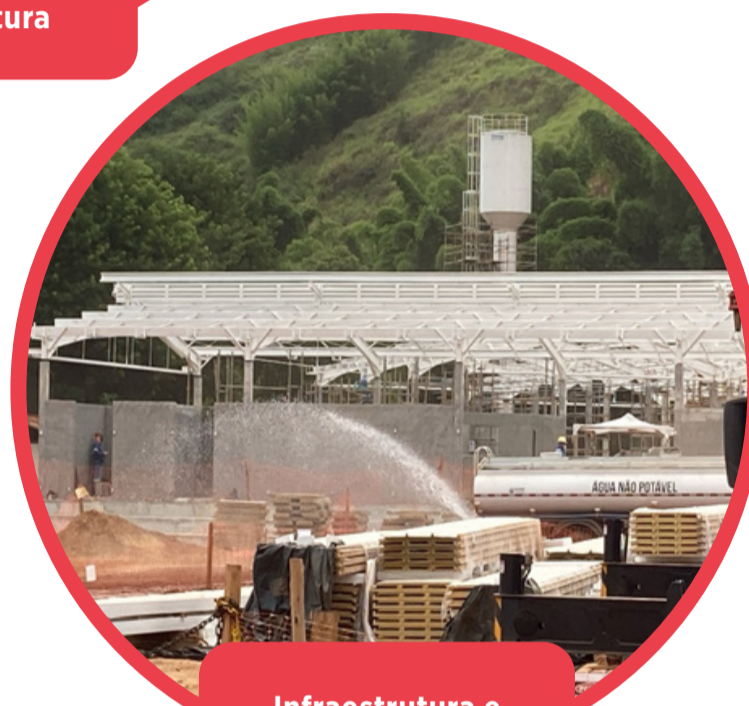
Infraestrutura e construção civil
