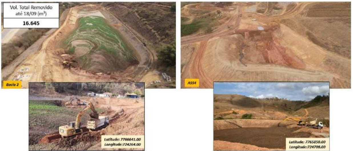
Figura 10 – Transbordo de sedimentos Bacia 2 para a Bacia 4
