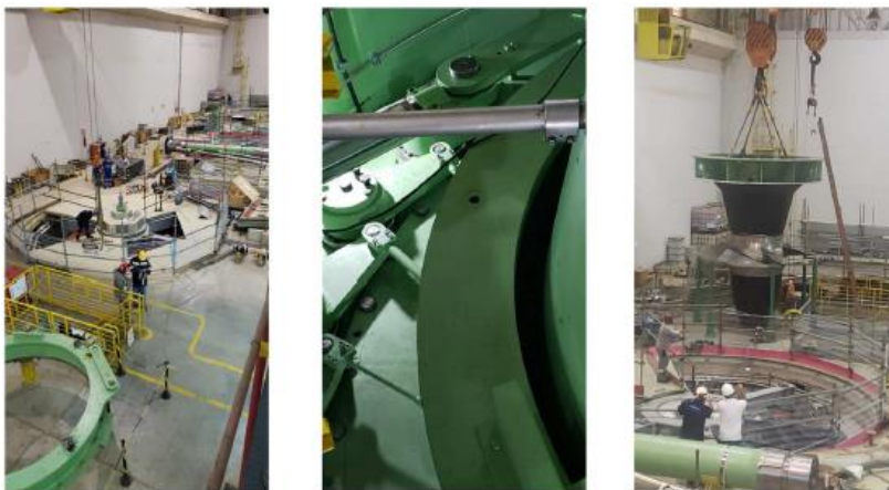
Figura 19 – Atividades na casa de força
