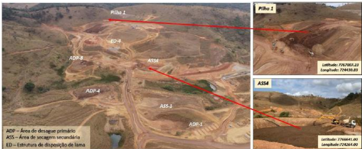
Figura 5 - Foto aérea das áreas de desaguamento primário e secundário do Setor 11
