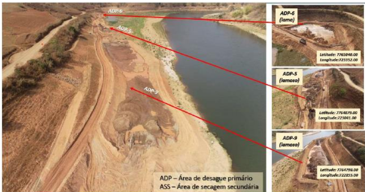
Figura 6 - Foto aérea das áreas de desaguamento primário do reservatório da UHE
