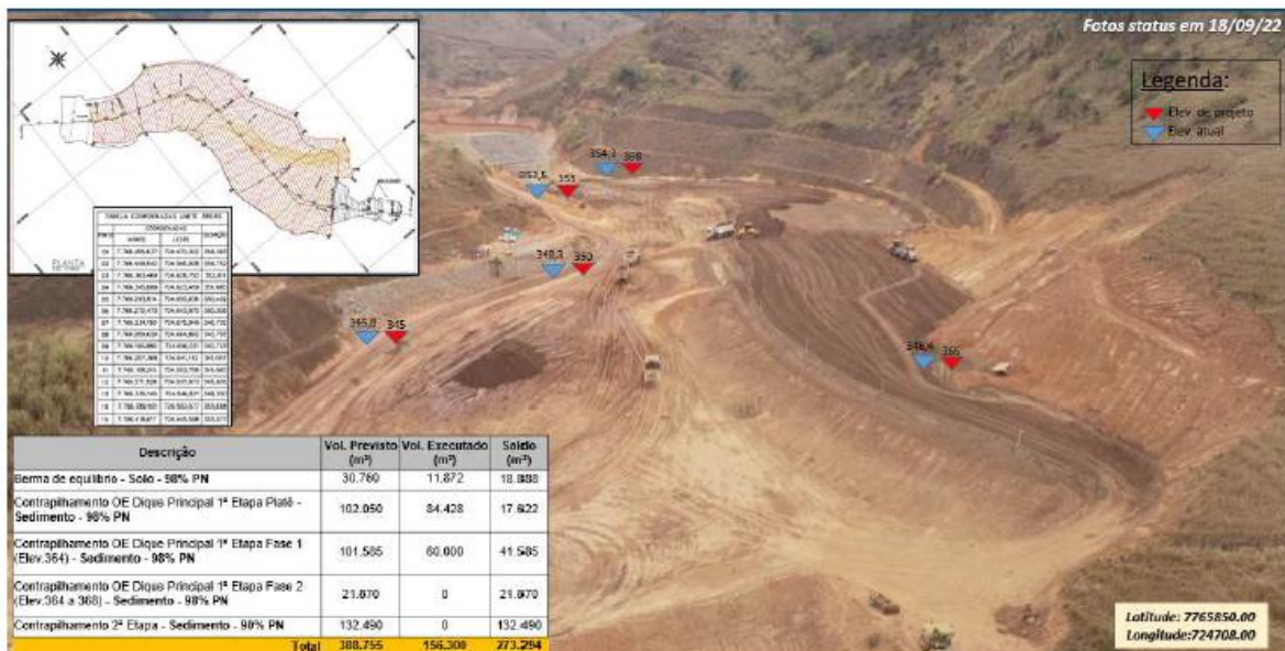
Figura 8 - Compactação de sedimentos O.E Dique Principal
