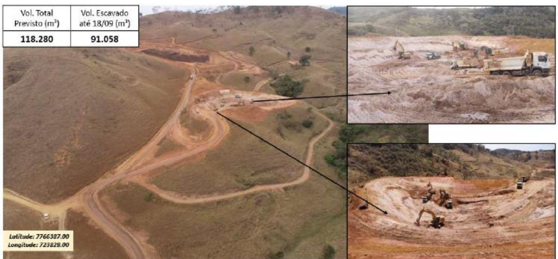
Figura 2 – Foto aérea Escavação bacia 4
