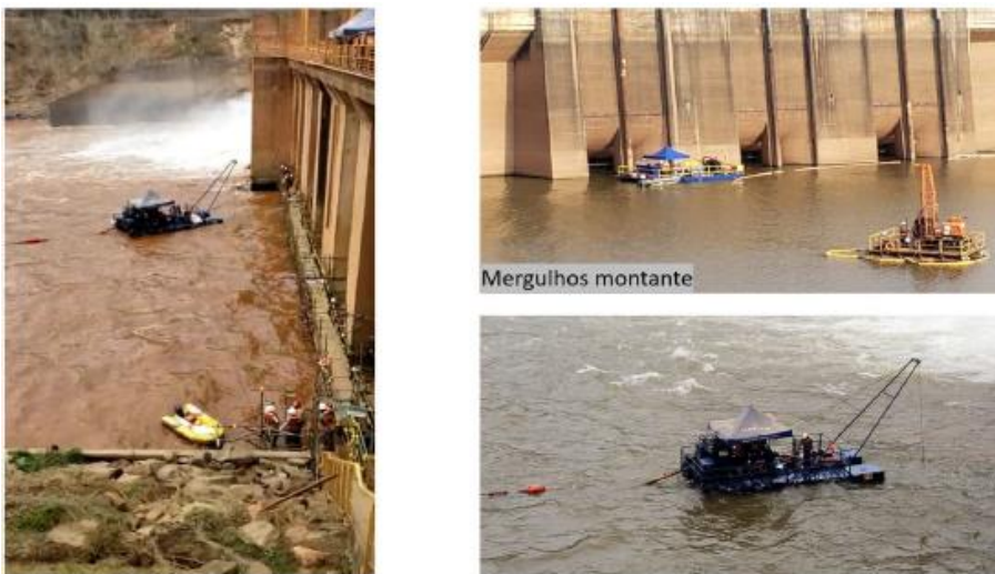
Figura 17 – Fotos da limpeza jusante e montante
