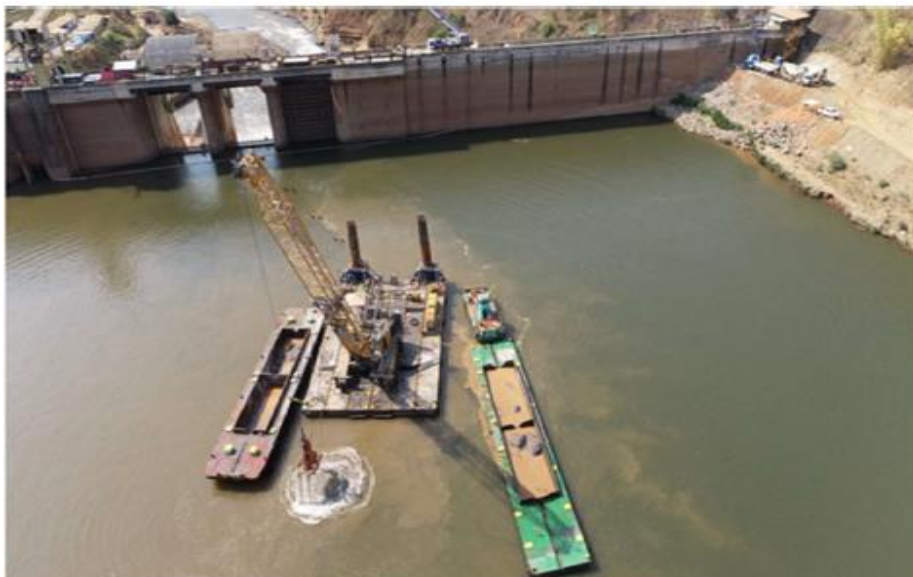
Figura 4 - Remoção de sedimentos dos conjuntos escavadeiras/balsa e do conjunto guindaste/ balsa
