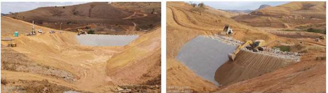
Figura 1 – Execução de estrutura de disposição – ED4
