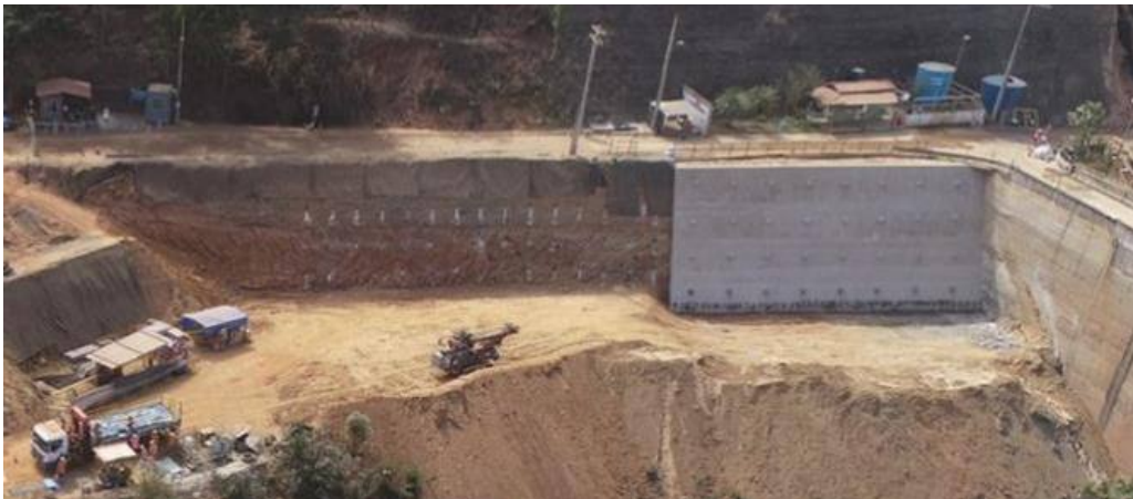
Figura 10 –Foto aérea 4ª etapa concluída
