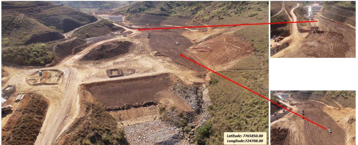
Figura 8 - Compactação de sedimentos O.E Dique Principal
