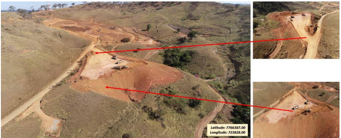
Figura 2 – Foto aérea Escavação bacia 4
