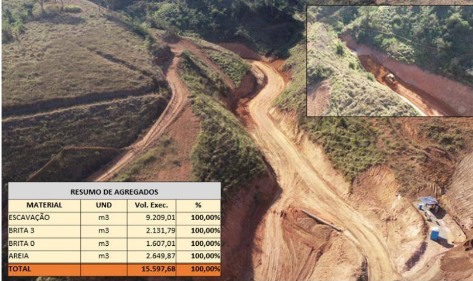
Figura 1 – Dreno DP1 (Setor 11) - Concluído
