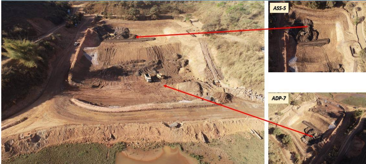
Figura 7 - Foto aérea das áreas de desaguamento localizadas no setor 1
