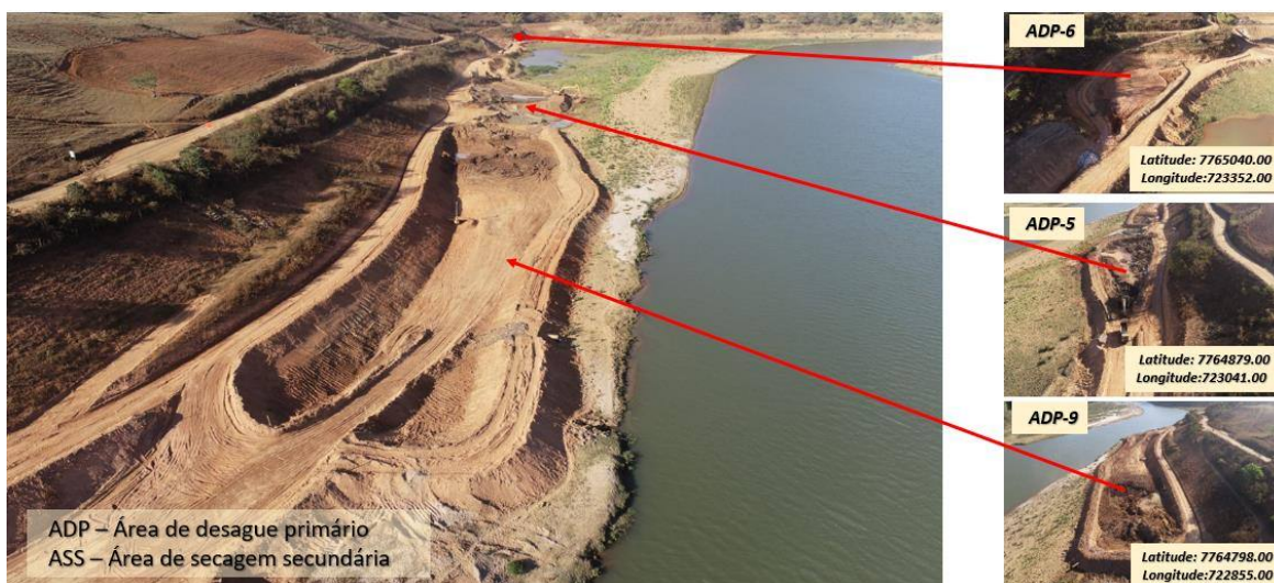
Figura 6 - Foto aérea das áreas de desaguamento primário do reservatório da UHE
