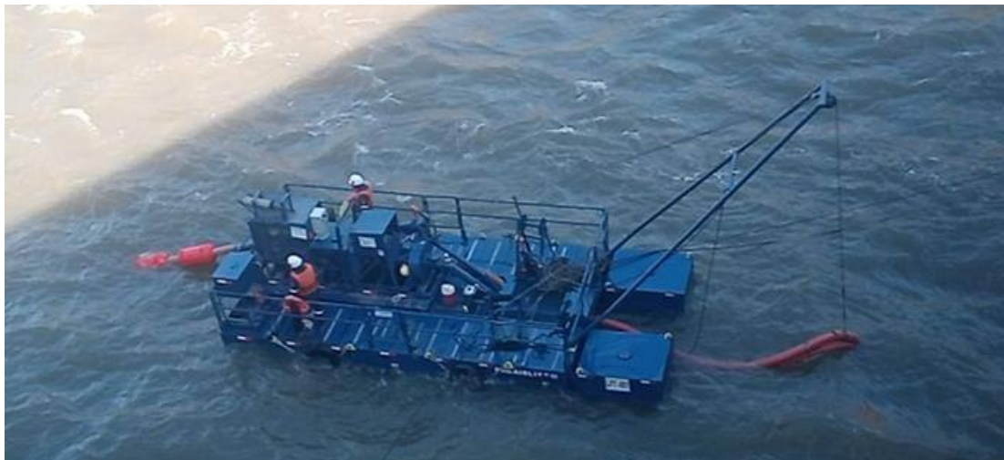
Figura 15 - Dragagem na faixa dos 10 metros da comporta de jusante
