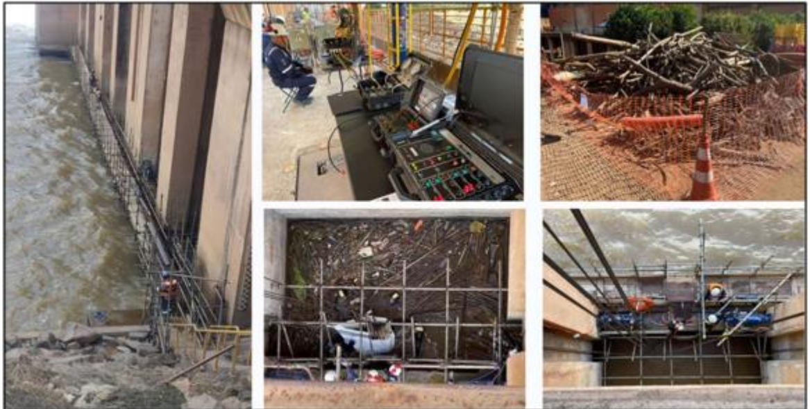
Figura 17 – Limpeza com mergulho da Ranhuras da saída d'água
