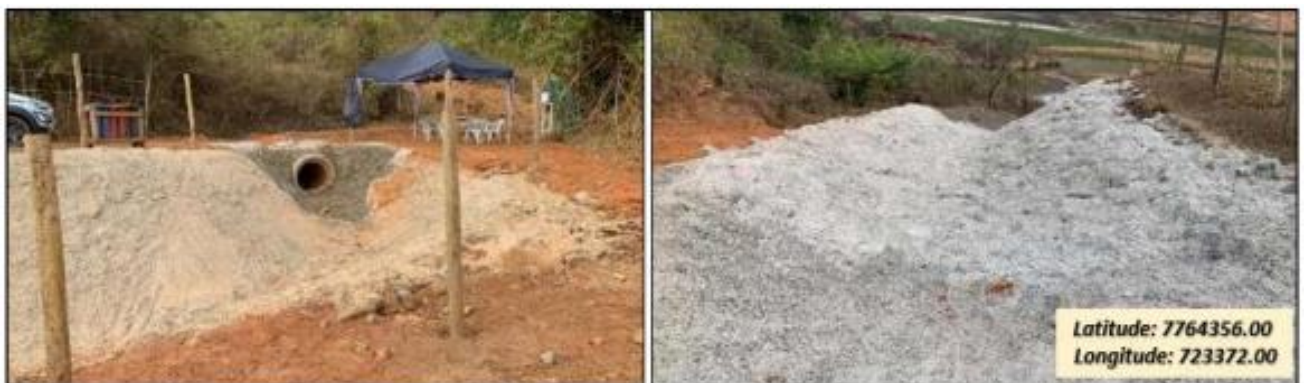
Figura 13 – Atividades de drenagem
