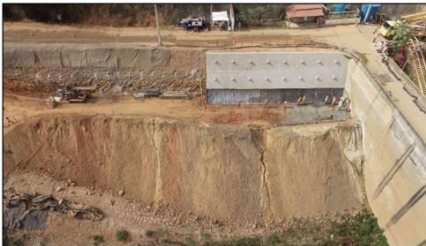
Figura 11 – Atividades de forma / armação e concretagem
