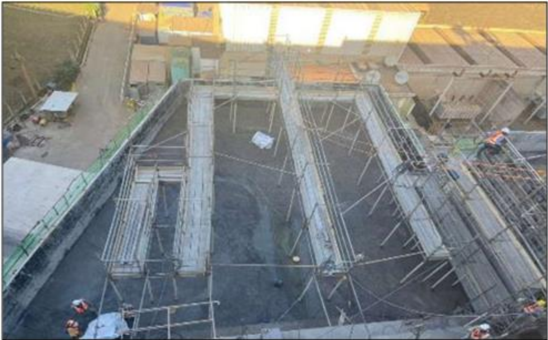
Figura 13 – Concretagem do bloco BME2
