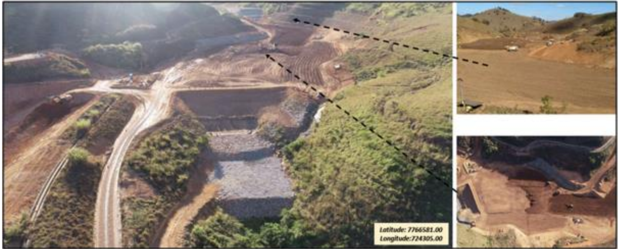
Figura 9 – Compactação de Sedimentos O.E Dique Principal
