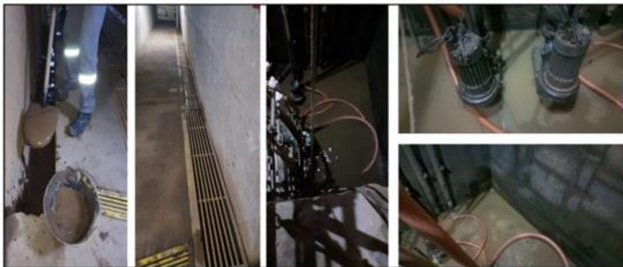
Figura 16 – Limpeza do poço de drenagem e canaletas
