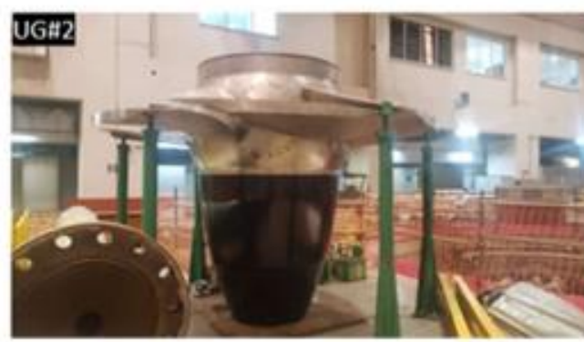
Figura 19 - Recuperação das Unidades de Geração - Rotor Kaplan
