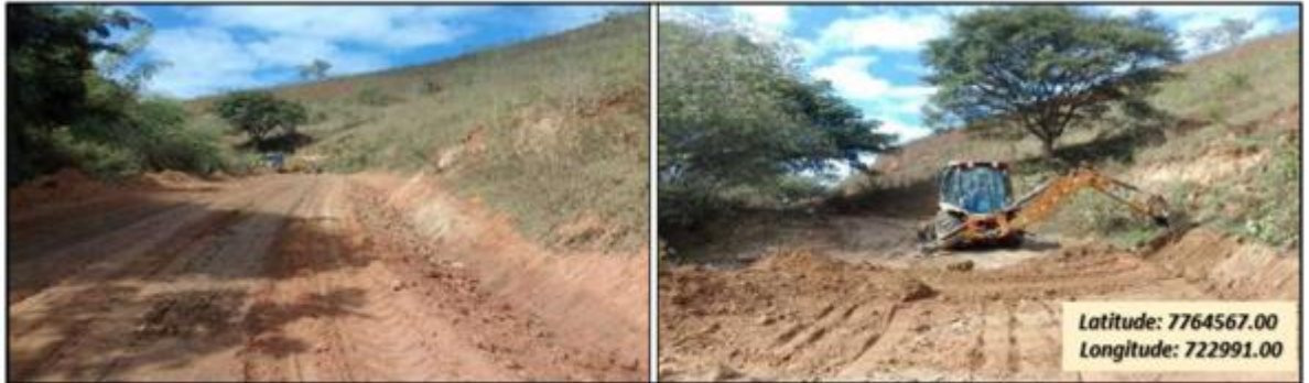
Figura 12 – Drenagem e preparo
