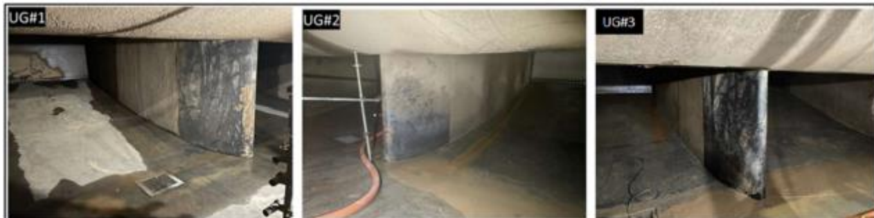
Figura 15 – Conclusão da Limpeza túneis Esquero e Direito – UG1, UG2 e UG3
