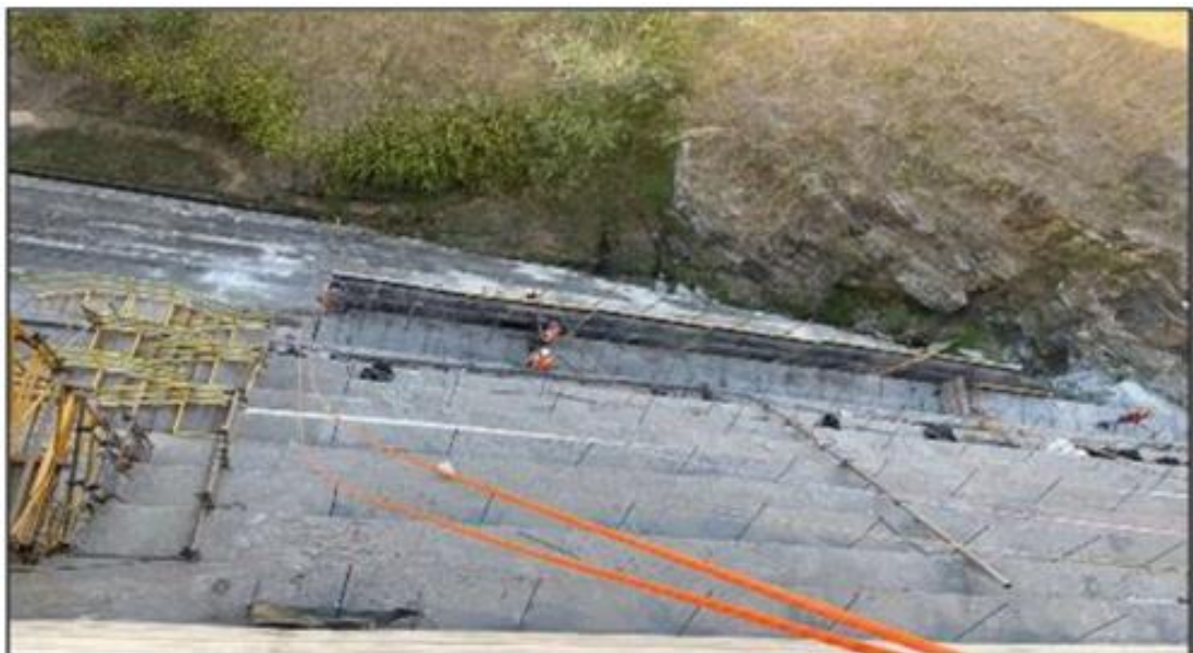
Figura 14 - Montagem forma bloco BMD3
