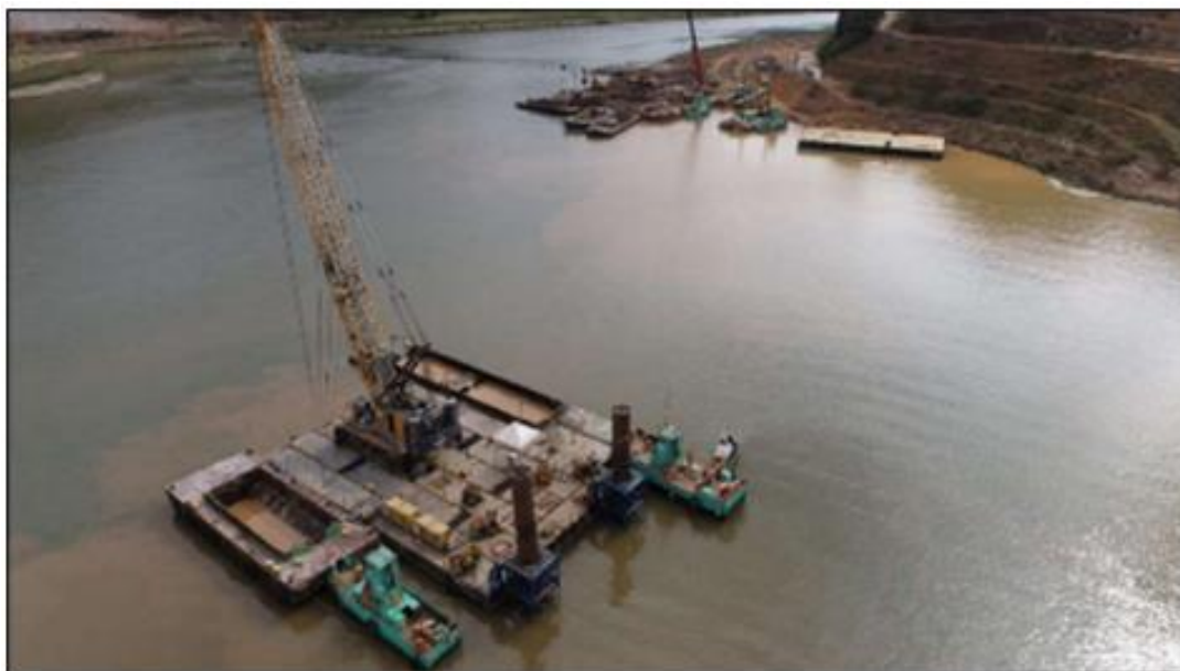
Figura 4 - Remoção de sedimentos dos conjuntos escavadeiras/ balsa e do conjunto guindaste/ balsa
