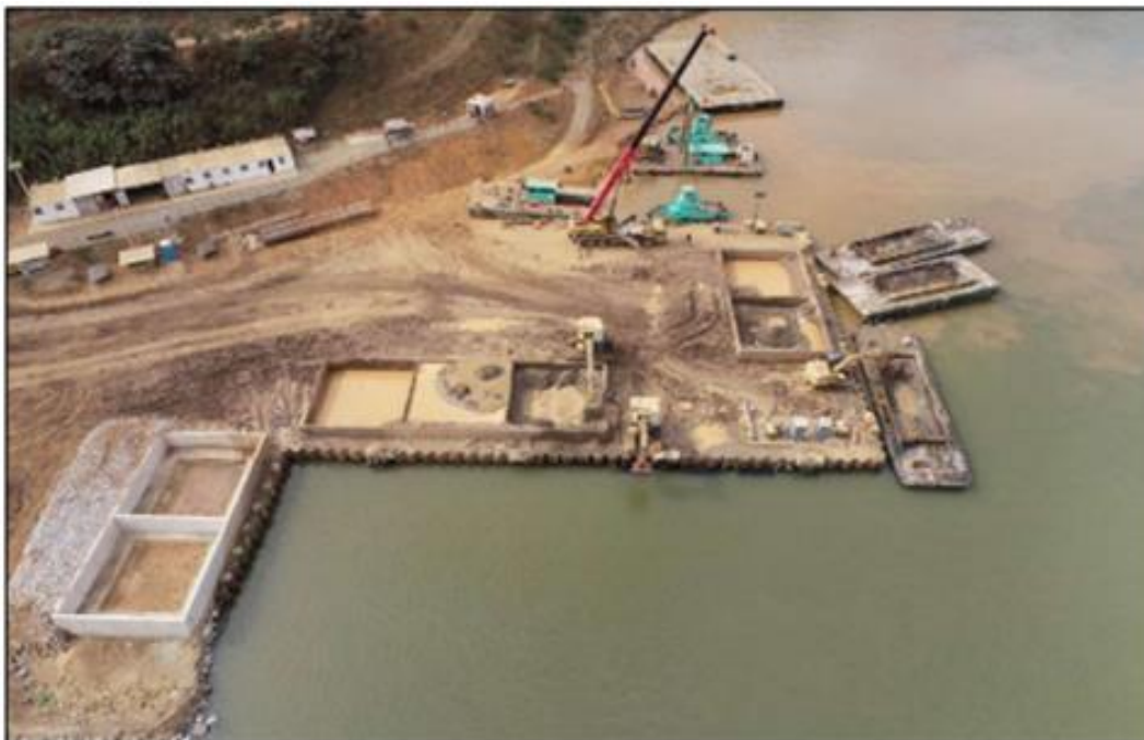
Figura 3 – Ciclo de Atividades de descarga nas baias localizadas no Ponto de Apoio
