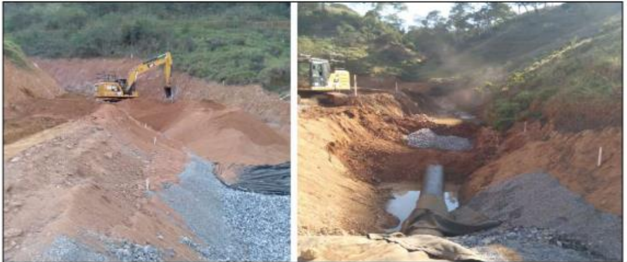
Figura 8 – Dreno DP1 (setor 11)
