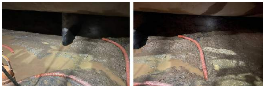
Figura 16 - Limpeza túneis Esquerdo e Direito – UG1
