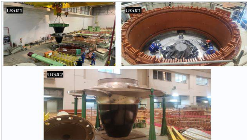
Figura 19 - Recuperação das Unidades de Geração - Rotor Kaplan
