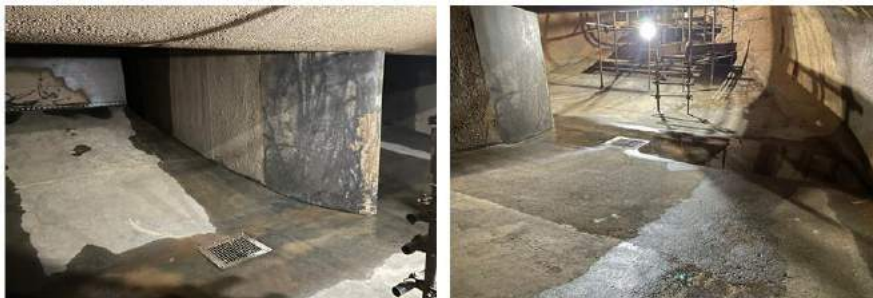
Figura 15 - Limpeza túneis Esquerdo e Direito – UG1
