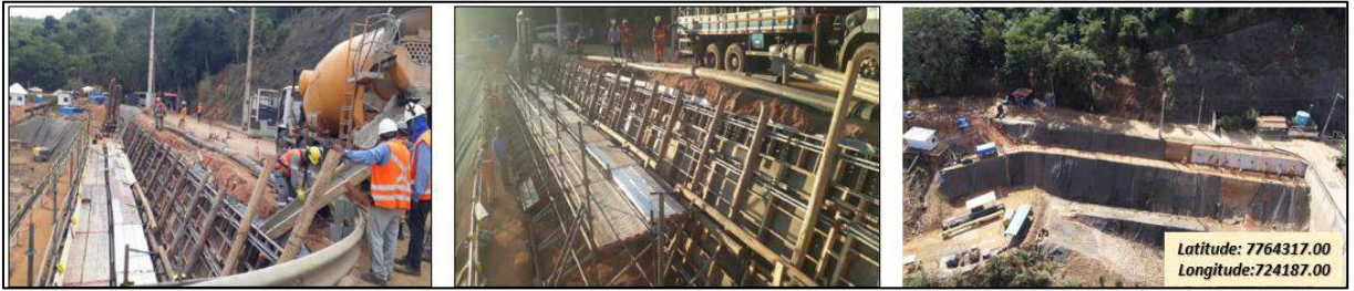
Figura 10 – Atividades de forma / armação e concretagem
