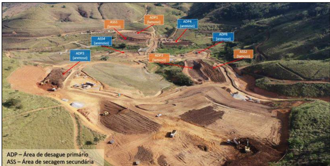
Figura 6 - Foto aérea das área de desaguamento primário e secundário do Setor 11
