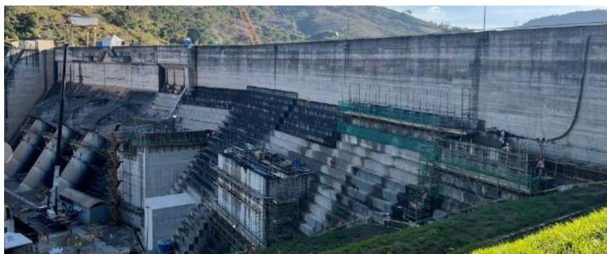
Figura 14 - Montagem forma bloco BME5 e BMF6
