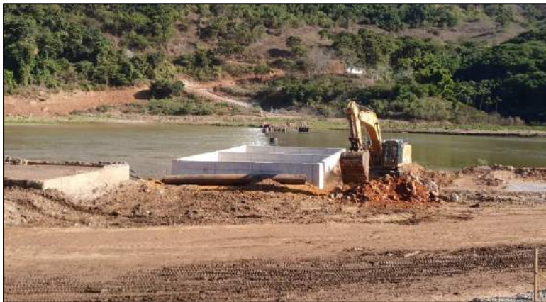
Figura 1 – Conclusão da baia nº 3
