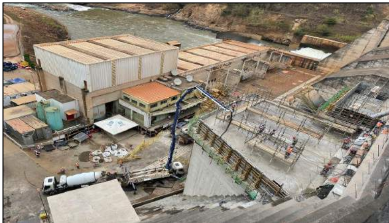
Figura 13 – Montagem forma bloco BME5
