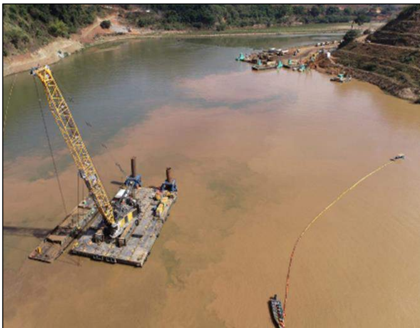
Figura 4 - Remoção de sedimentos dos conjuntos escavadeiras/ balsa e do conjunto guindaste/ balsa
