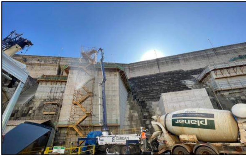
Figura 12 – Concretagem do bloco BME2
