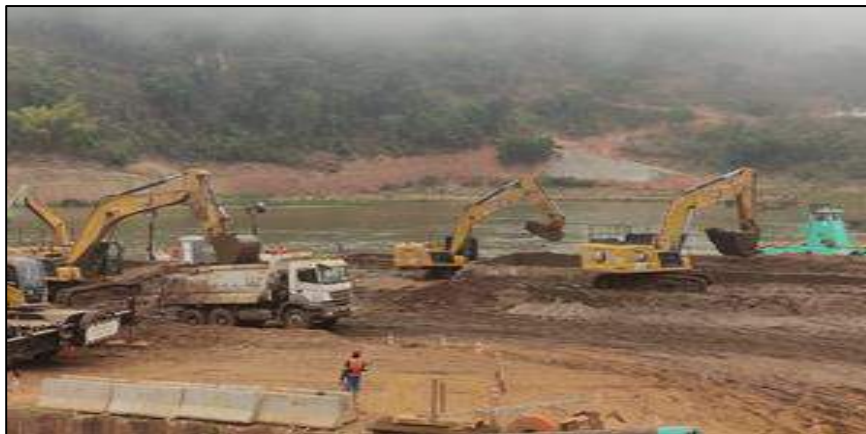
Figura 5 – Transbordo baias para caminhões caçambas
