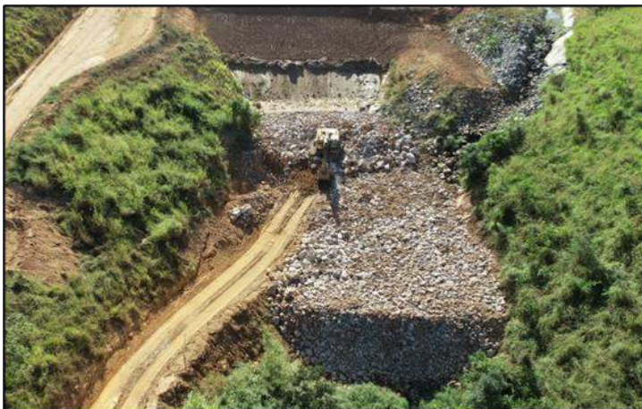
Figura 2 – Execução de Berma de equilíbrio
