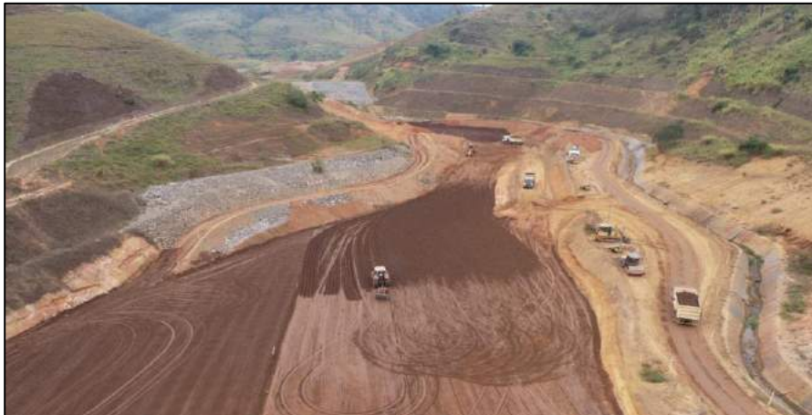
Figura 8 - Compactação de Sedimentos O.E Dique Principal
