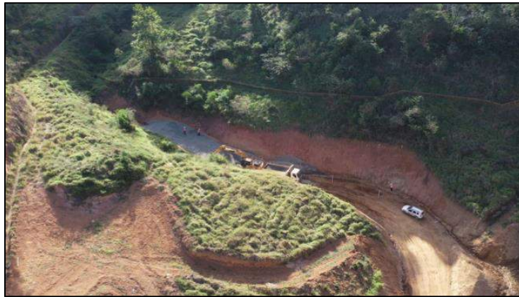
Figura 7 - Dreno DP1 (Setor 11)
