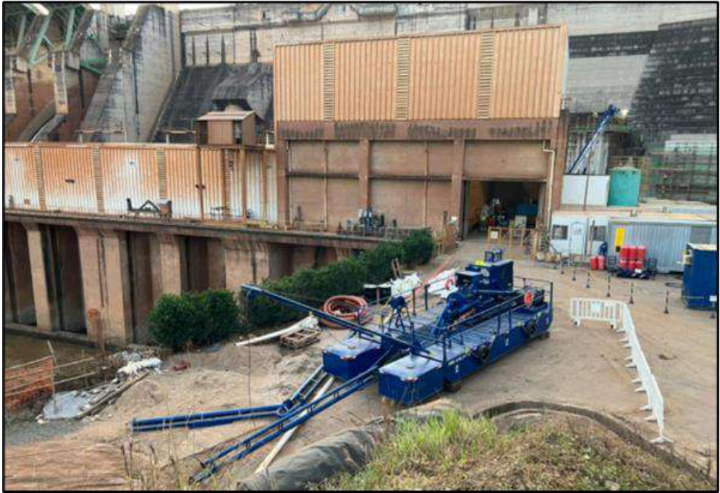
Figura 20 - Mobilização conjunto draga/ balsa
