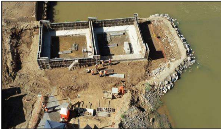
Figura 1 – Execução de forma das paredes da baia nº 3
