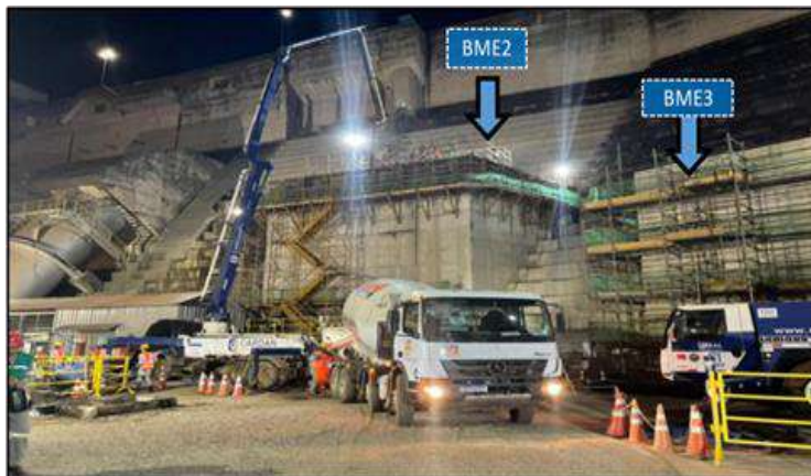
Figura 12 – Concretagem do bloco BME2
