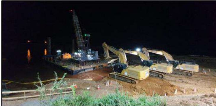
Figura 5 – Lançamento do conjunto balsa / guindaste no reservatório UHE
