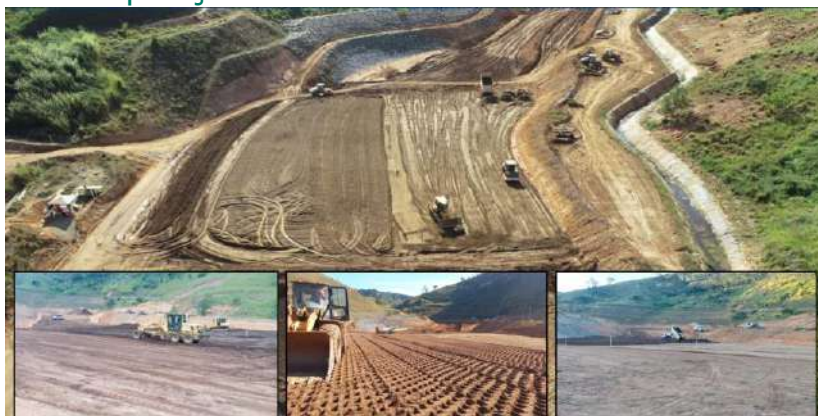
Figura 8 - Compactação de Sedimentos O.E Dique Principal
