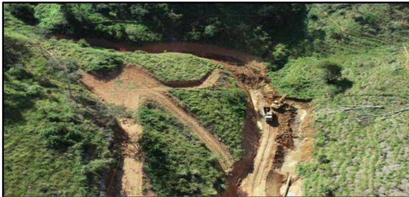
Figura 7 - Dreno DP1 (Setor 11)
