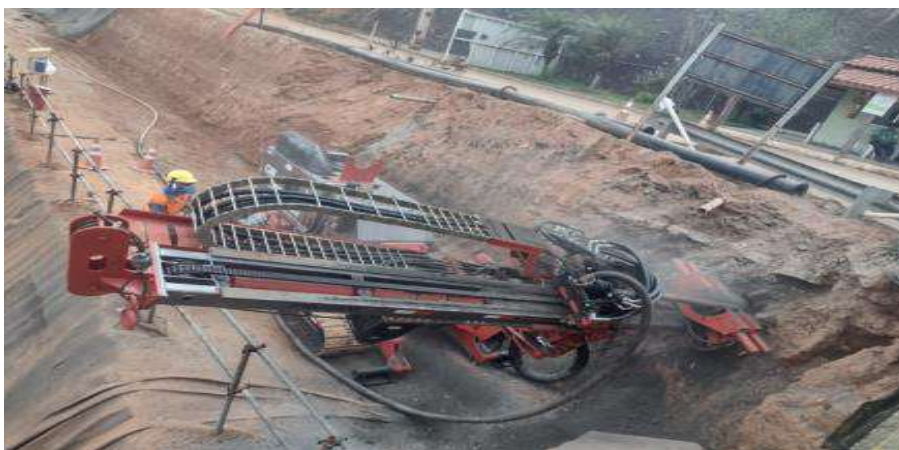
Figura 11 - Perfuração terreno natural
