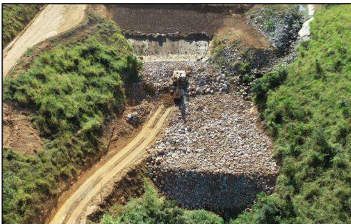
Figura 2 – Execução de Berma de equilíbrio
