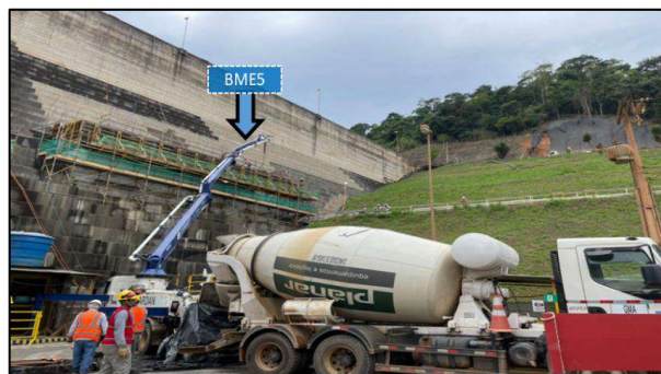
Figura 13 – Montagem forma bloco BME5
