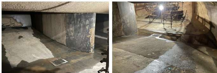
Figura 15 - Limpeza túneis Esquerdo e Direito – UG1
