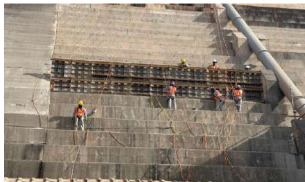
Figura 14 - Montagem forma bloco BME1
