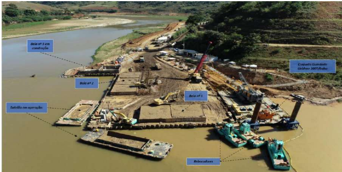
Figura 3 – Ciclo de Atividades de descarga nas baias localizadas no Ponto de Apoio
