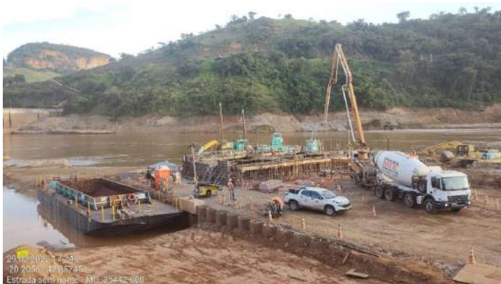
Figura 1 – Concretagem da baía nº 2
