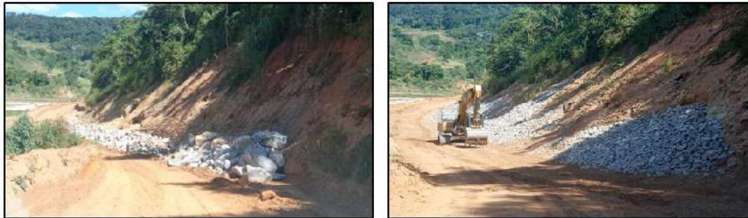
Figura 13 – Atividade de enrocamento nos pontos da margem esquerda em execução
