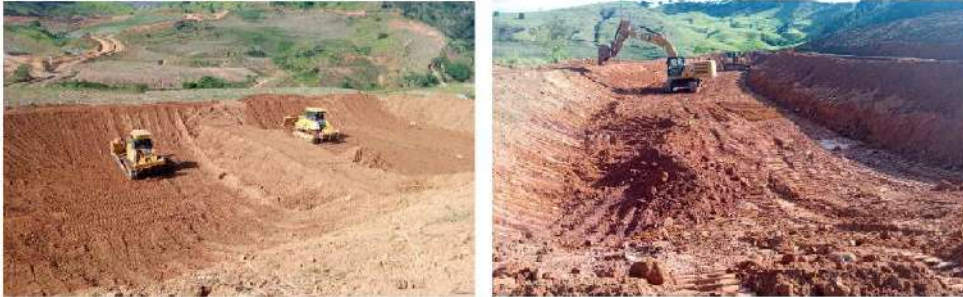
Figura 9 – Construção áreas de desaguamento primário 1 e 2 - Setor 11
