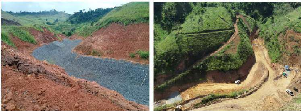
Figura 10 - Dreno DP1 (Setor 11)
