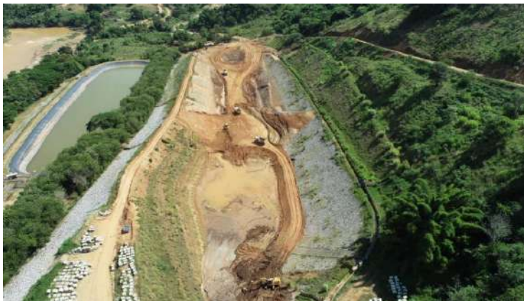
Figura 2 - Remoção de sedimentos da bacia 2A e do Septo removido entre bacia 2A e 2B
