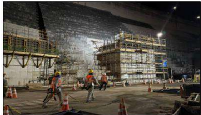
Figura 17 - Concretagem dos blocos BME3 e BME4
