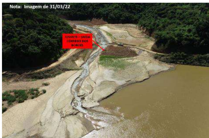
Figura 21 – Jusante Setor 4 – Saída
