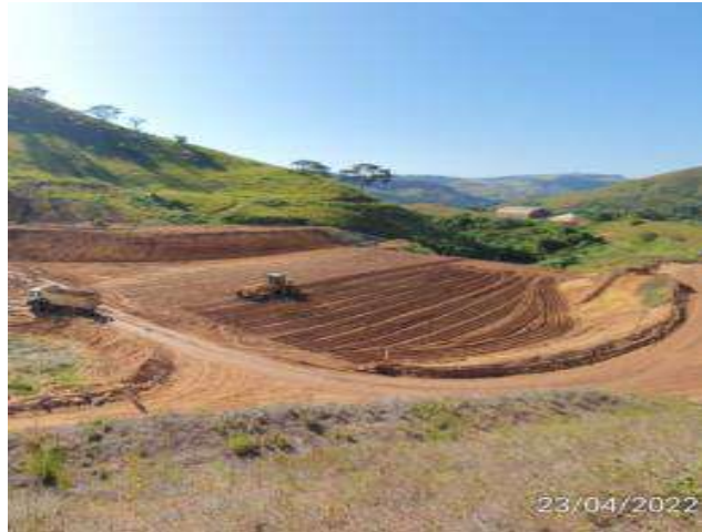
Figura 11 - Dreno DP1 (Setor 11)
