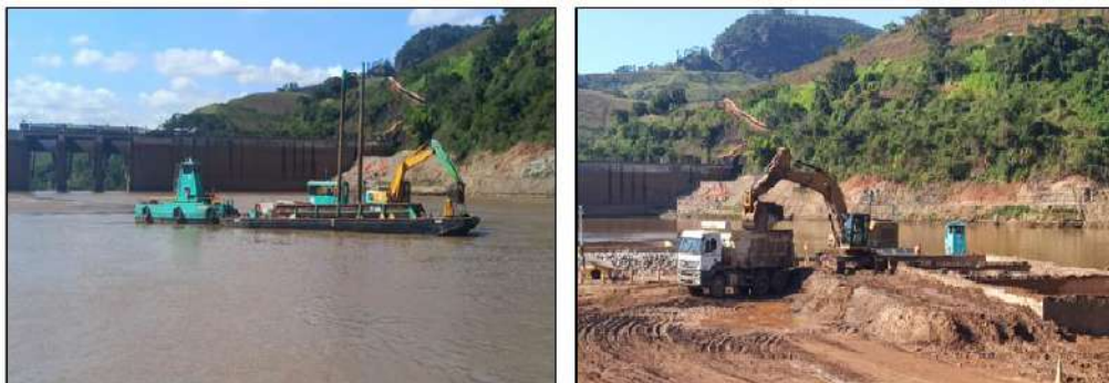
Figura 4 - Remoção de sedimentos – Turno diurno
