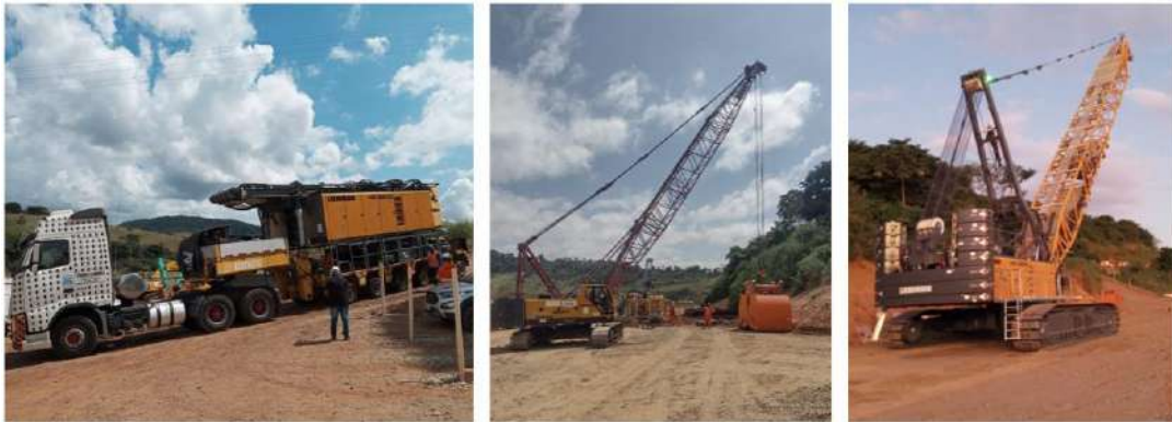
Figura 6 - Montagem Guindaste Liebherr HS8220HD
