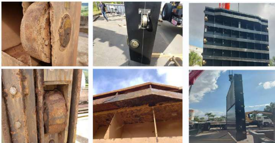
Figura 16 - Recuperação das Comportas da Tomada d'água
