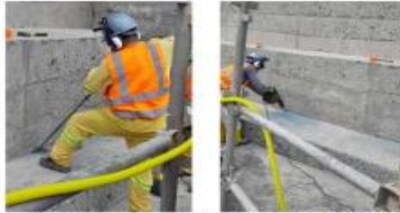
Figura 11 - Execução de pontos de ancoragem e hidrojateamento
