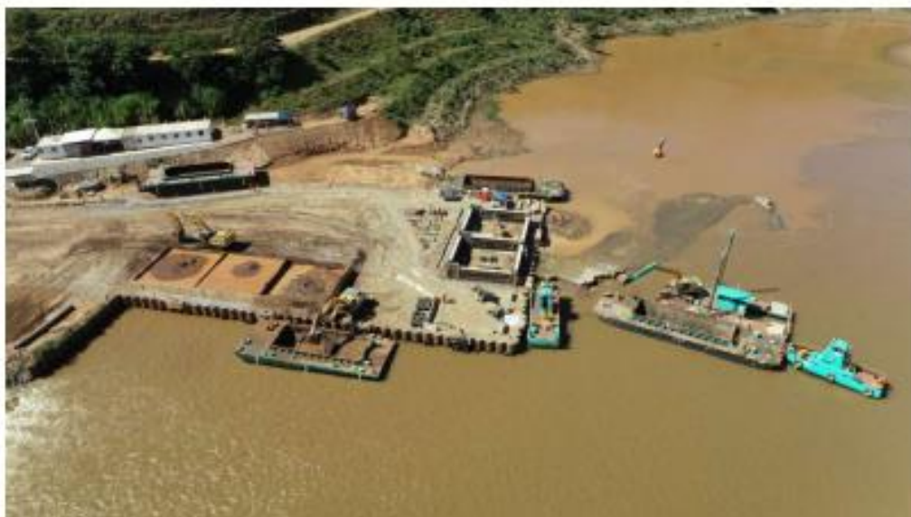
Figura 4 - Imagem aérea da atividade de remoção de sedimentos
