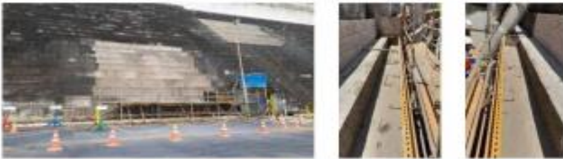
Figura 12 - Concretagem 1ª Camada BME3 / BME2
