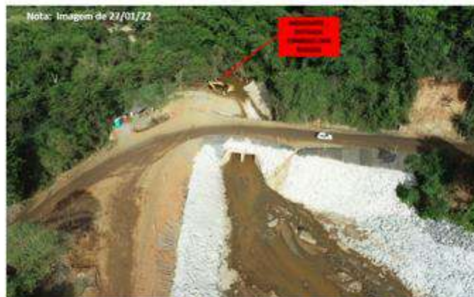
Figura 18 – Montante Setor 4 – Entrada
