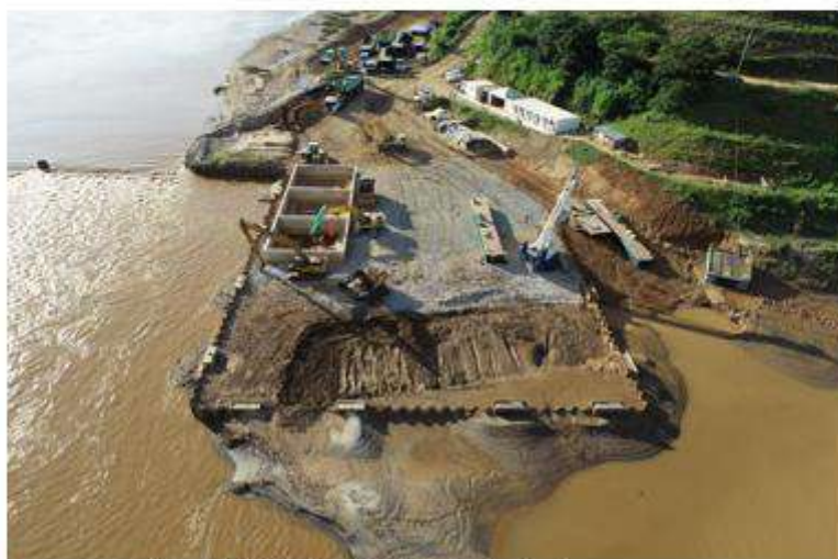
Figura 3 - Vista aérea Ponto de Apoio
