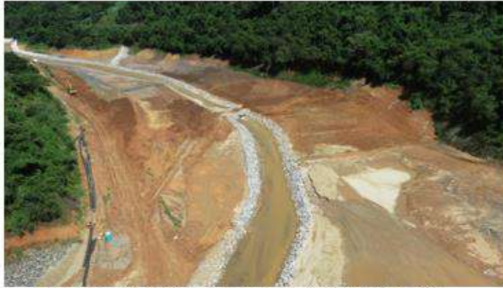
Figura 12- Vista Canal de drenagem à jusante do dique
