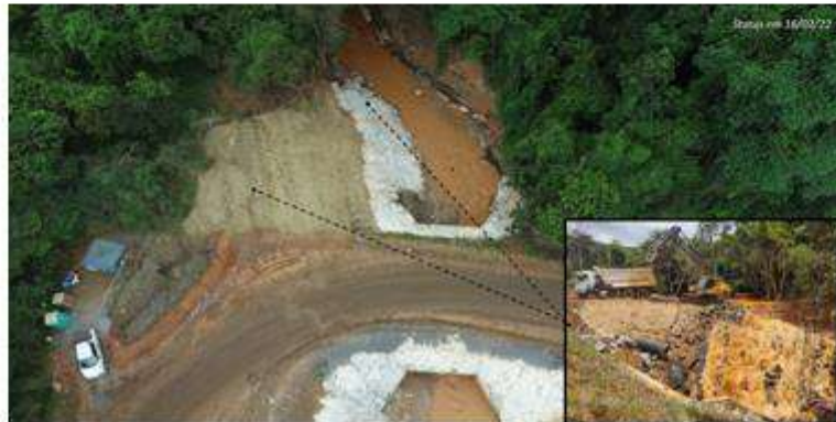
Figura 1 -Remoção da ensecadeira à montante do córrego dos Borges
