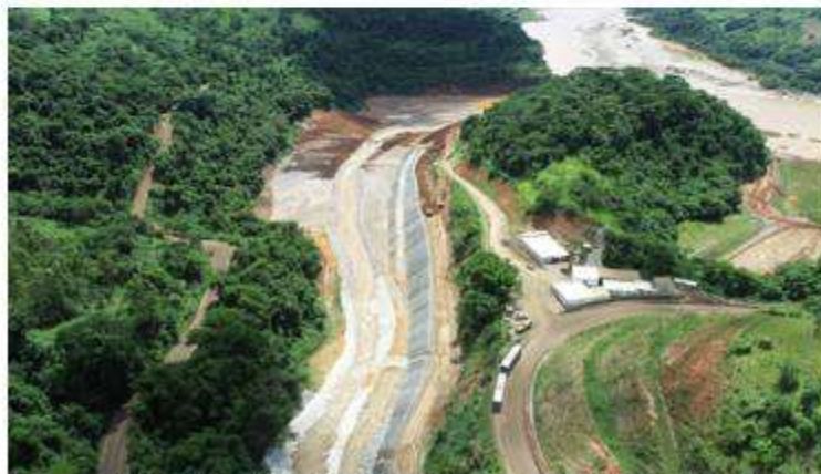
Figura 13 - Vista Canal de drenagem à montante do dique
