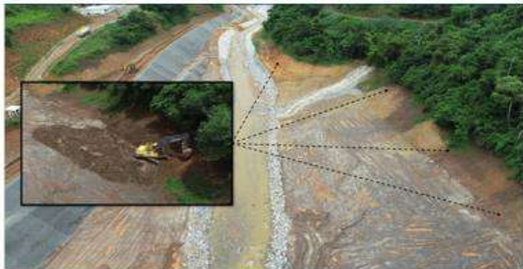
Figura 2 - Regularização das ombreiras
