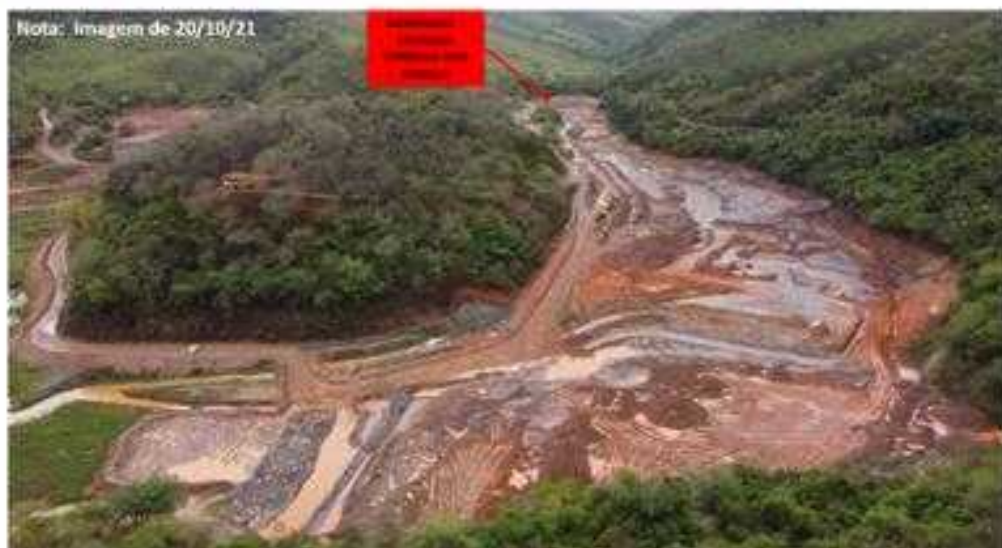
Figura 26 – Montante Barramento Setor 4 - Entrada
