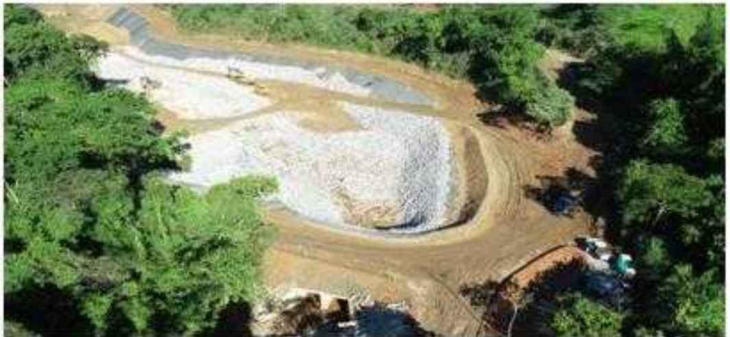
Figura 2 - Vista a montante do Dique Setor 4
