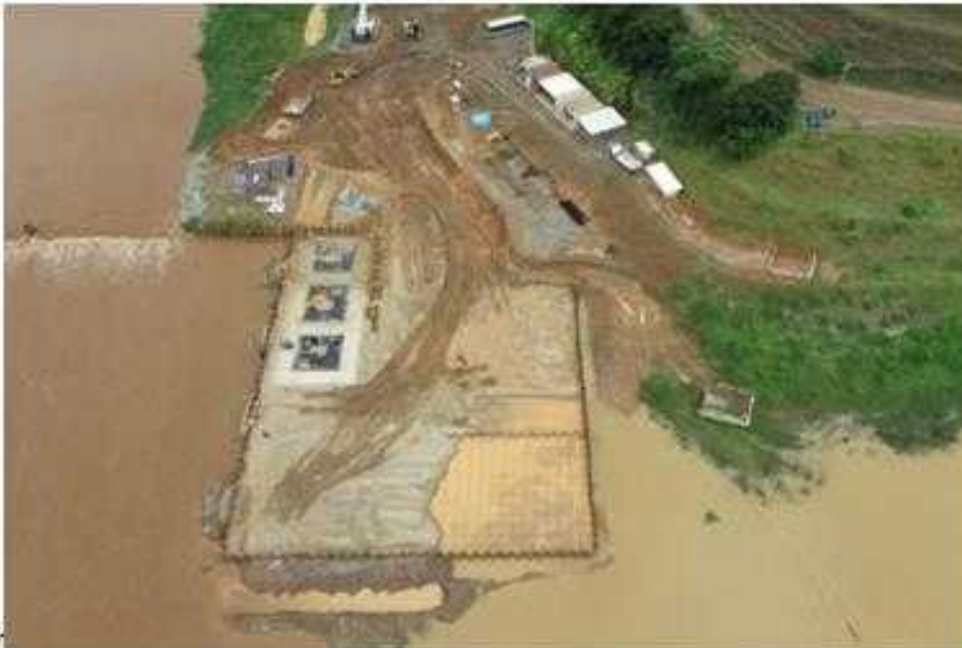
Figura 10 - Vista aérea Ponto de Apoio
