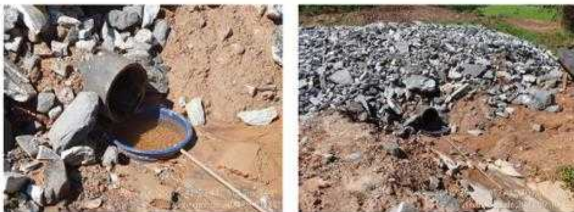
Figura 31 - Implantação de caixa de armazenamento de efluentes
