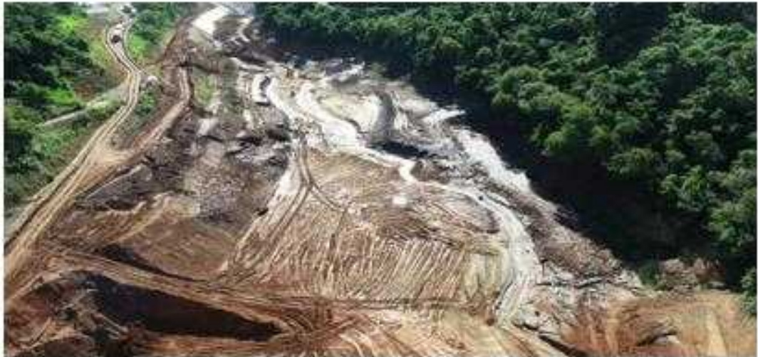
Figura 1- Vista à jusante do Dique Setor 4
