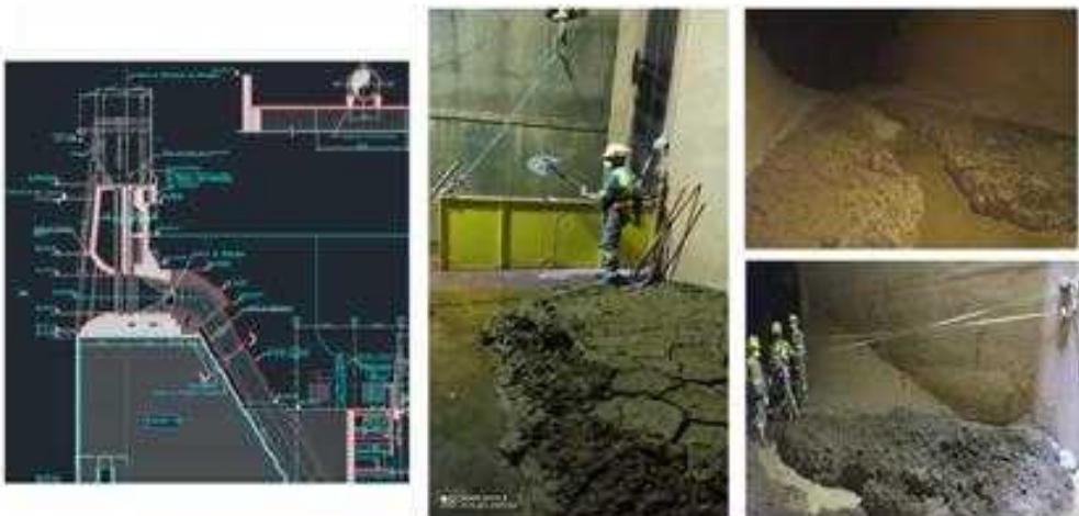
Figura 20 - Limpeza Entre a Comporta e a Descida do Conduto
