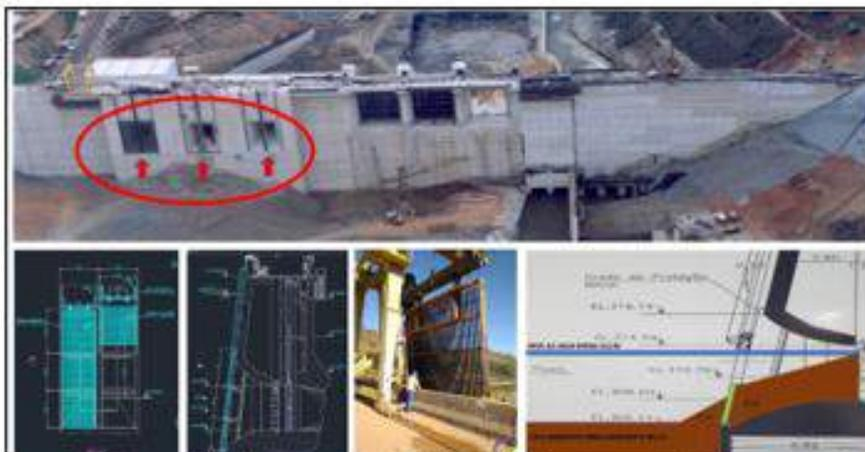
Figura 12 - Limpeza do vão da tomada d'água para retirada das grades
