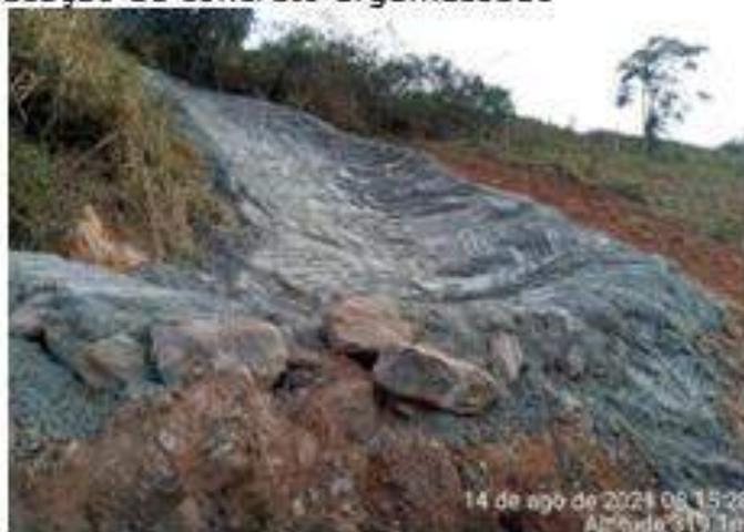
Figura 10 – Concreto argamassado ponto 42
