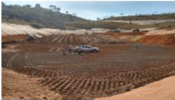
Figura 7 - Liberação de camada de compactação
