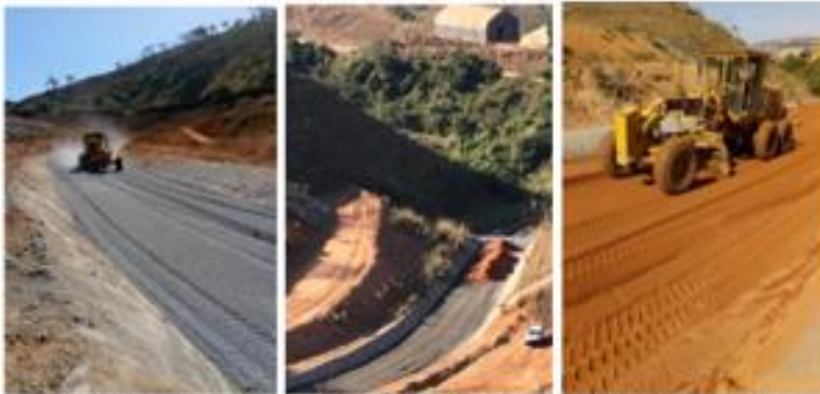
Figura 8 - Sequência executiva do dreno no canal extravasador
