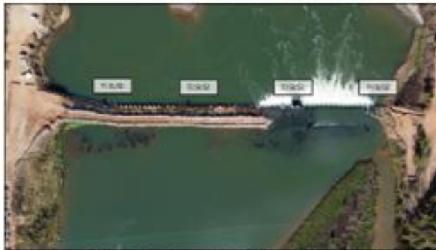
Figura 11 - Tilt meters instalados (Barramento A)
