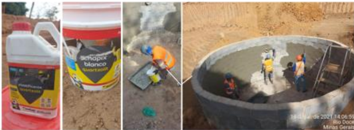
Figura 21 - Impermeabilização da baía da caixa de efluentes
