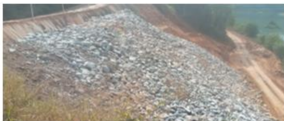
Figura 9 - Enrocamento de talude dos pontos 144/55
