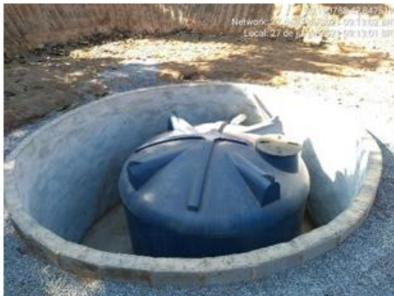
Figura 22 - Conclusão da realocação da caixa de efluentes
