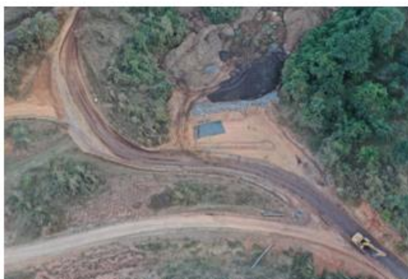
Figura 20 - Melhoria realizada: fechamento da leira, direcionamento do greide do terreno e instalação de tubulação para direcionamento de eventual efluente na saída
