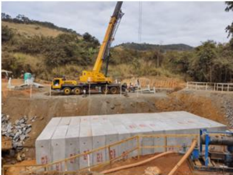
Figura 1 - Colocação de aduelas Bueiro dos Borges
