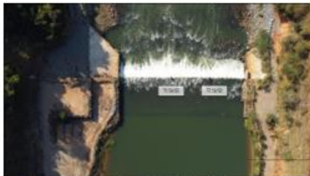
Figura 13 - Tilt meters instalados (Barramento C)
