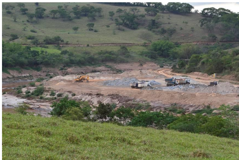
Figura 34 Operação de retirada de rejeitos acumulados no reservatório de Candonga
