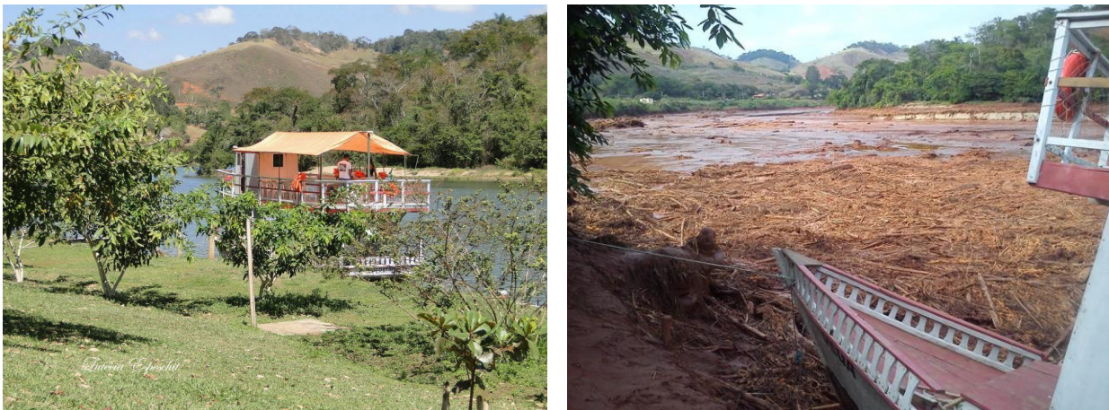
Figura 33 Impactos sobre a Chalana do reservatório da UHE Risoleta Neves.
