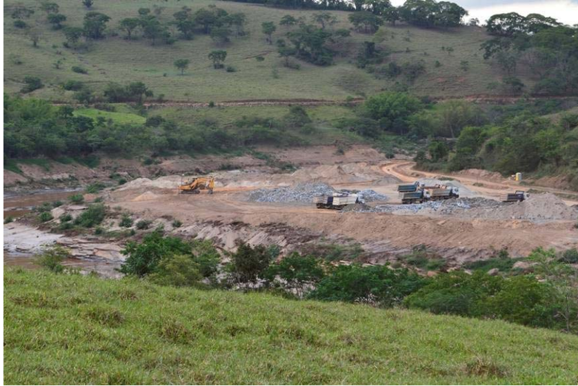
Figura 37 Operação de retirada de rejeitos acumulados no reservatório de Candonga
