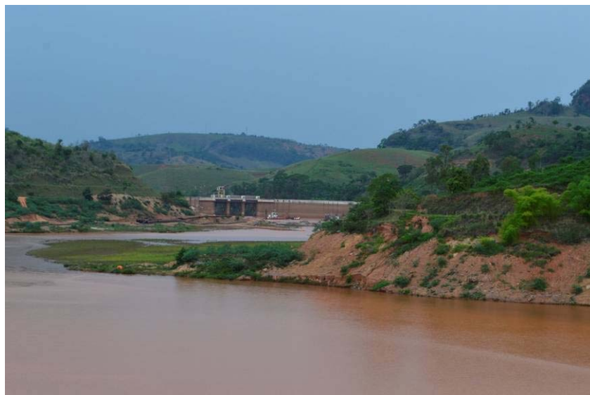
Figura 25 Retirada dos rejeitos depositados ao pé do eixo do Barramento da Hidrelétrica Risoleta Neves
