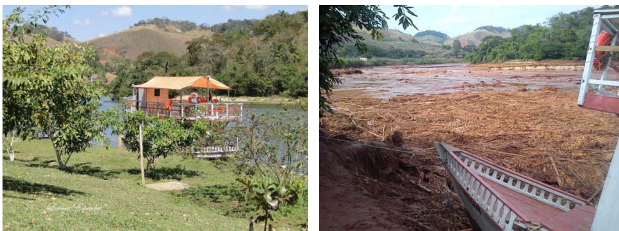
Figura 36 Impactos sobre a Chalana do reservatório da UHE Risoleta Neves.
