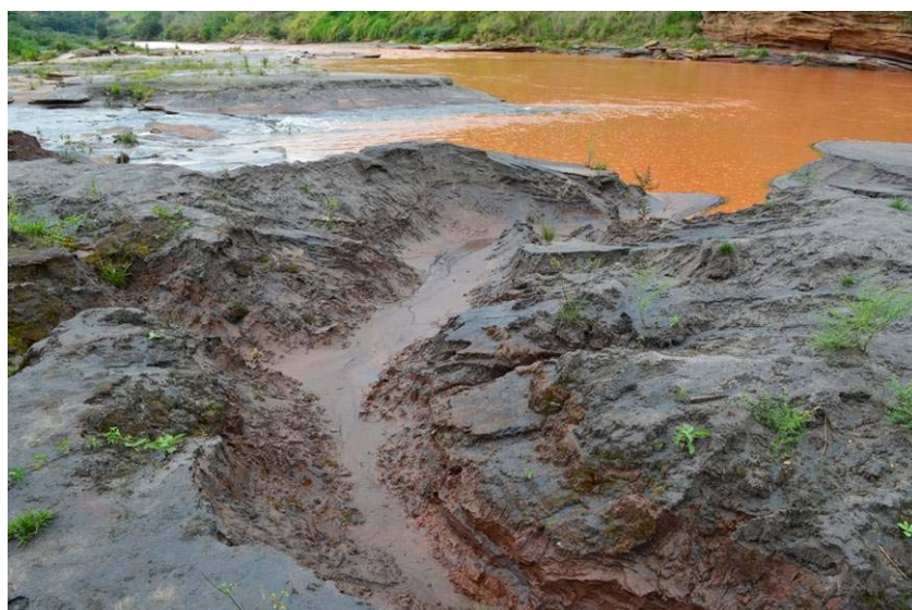
Figura 26 Acúmulo de rejeito na margem e no substrato da calha do rio Doce
