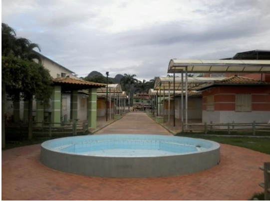
Centro de Recreação de Pingo D'Água
