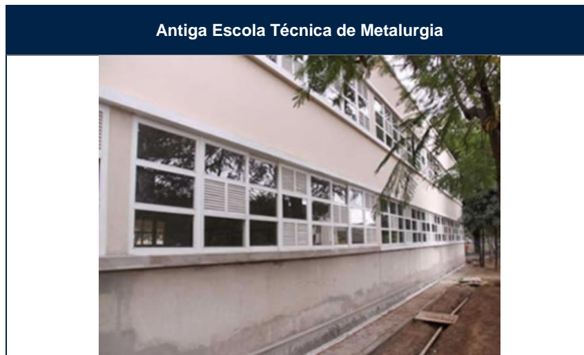
Figura 12 Antiga Escola Técnica de Metalurgia
