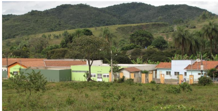
Figura 12 Complexo Escola-Auditório-Posto de Saúde de Bento Rodrigues
