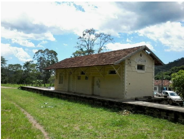
Estação ferroviária de Furquim
