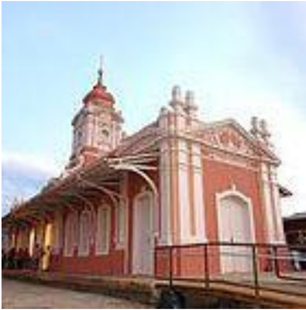
Estação Ferroviária de Mariana Decreto nº 3.485/2005
