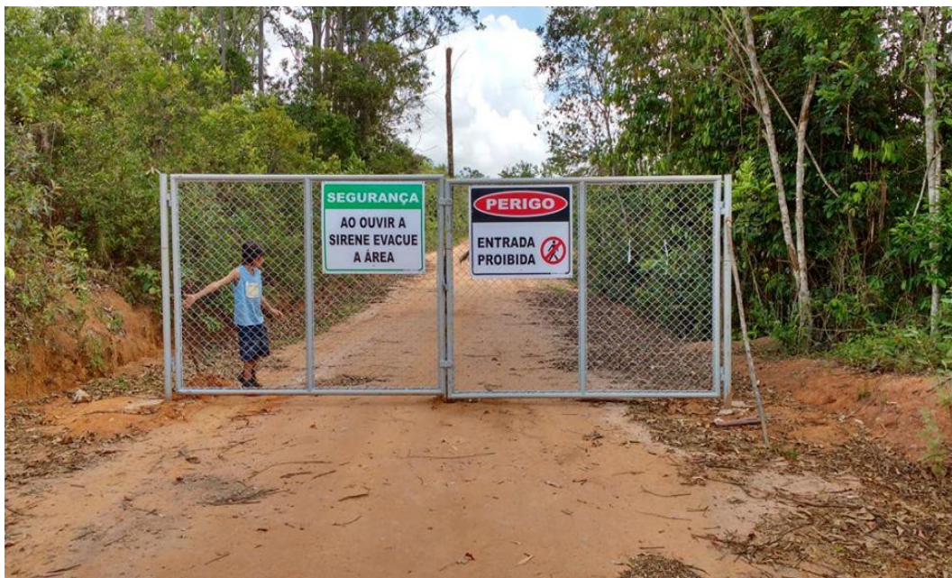
Figura 33 Portão de impedimento de acesso à Bento Rodrigues.
