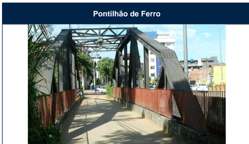
Figura 8 Pontilhão de Ferro
