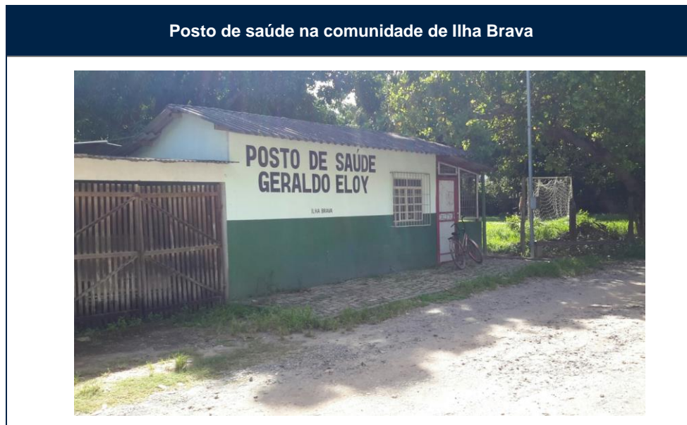
Figura 29 Posto de saúde na comunidade de Ilha Brava
