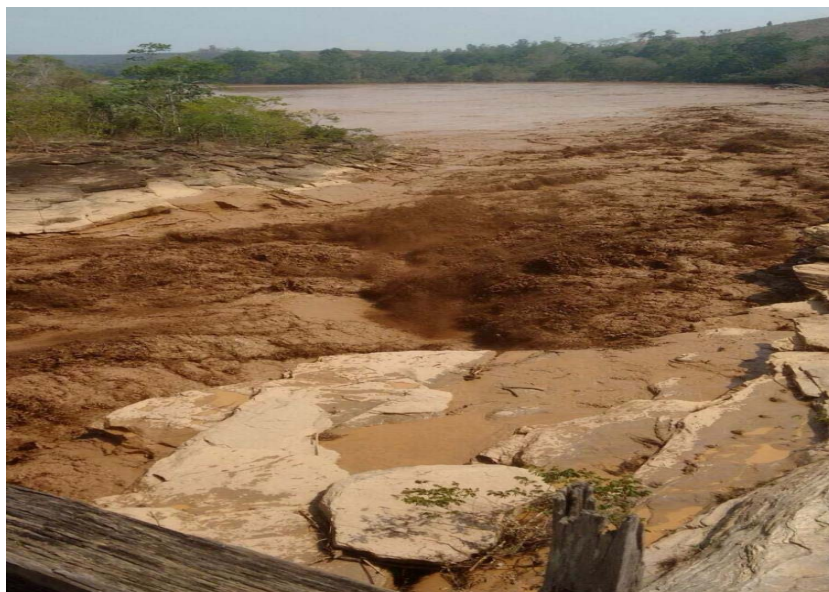
Figura 25 Ponte metálica sobre o rio Doce, na divisa dos municípios de Santana do Paraíso e Caratinga
