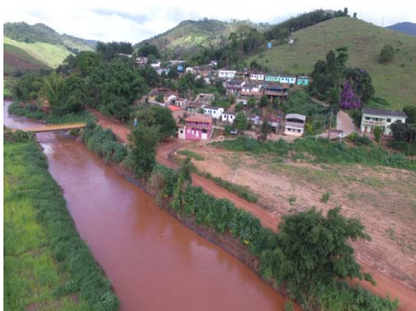
Figura 27 Comunidade de Gesteira a direita e ponte de ligação a comunidade sobre o rio Gualaxo.
