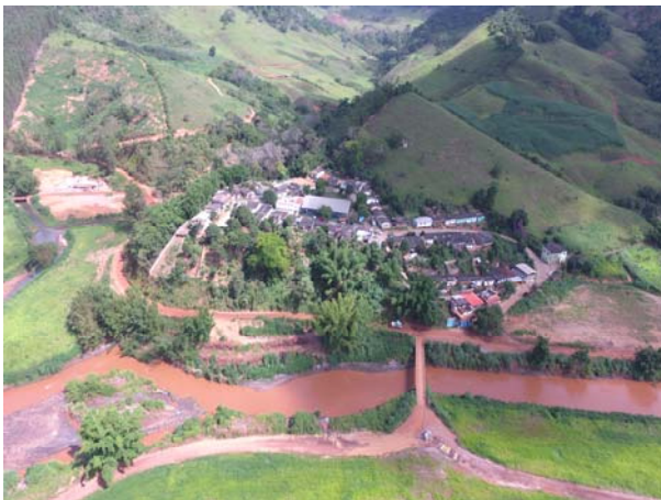
Figura 29 Vista panorâmica aérea de Gesteira com visada frontal da ponte sobre o rio.
