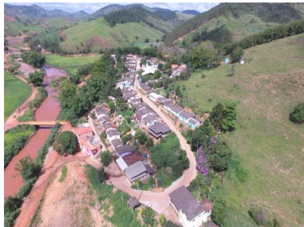
Figura 30 Vista panorâmica aérea de Gesteira com visada lateral da ponte sobre o rio.
