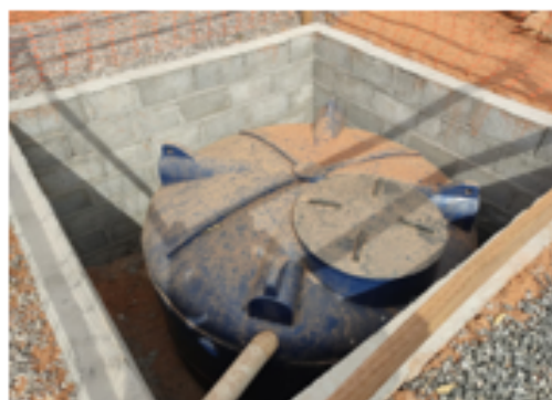
Implantação de Caixa de Efluentes com Baia de Contenção – limpeza com Caminhão Limpa-Fossa com frequência semanal
