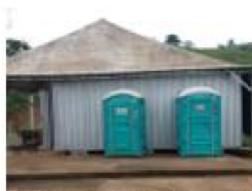
Utilização temporária de banheiros hidráulicos
