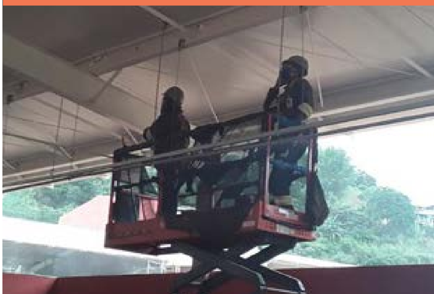
Instalação de luminárias do estábulo
