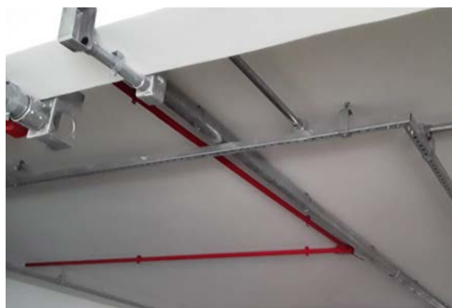
Instalação da rede elétrica no edifício sede
