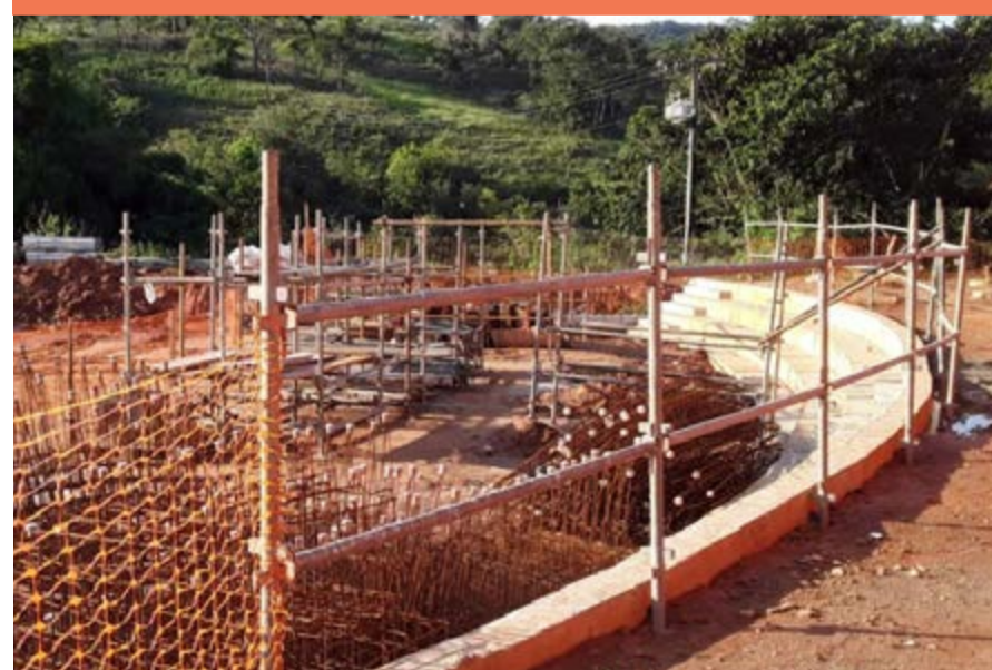
Construção de superestrutura (armação e forma) da área externa
