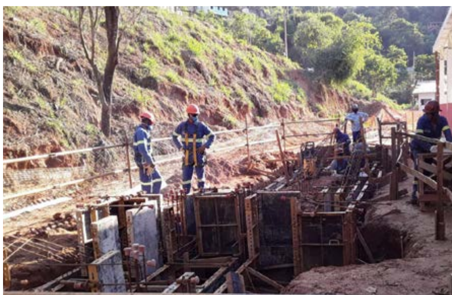
Construção de superestrutura (armação e forma) do curral
