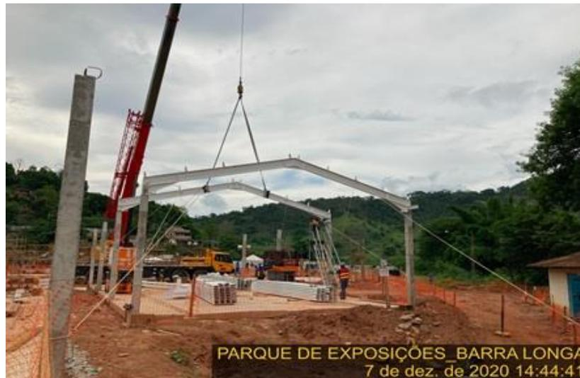
**Foto relacionada à:** Consorcio Reassentamento Paracatu – Obras do Parque – Montagem De Estruturas Metálicas Da Cobertura - Dezembro/2020
