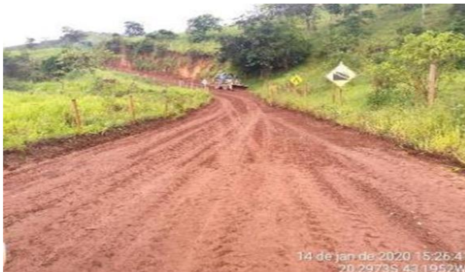
Foto relacionada à: Manutenção de acessos não pavimentados (Trecho Paracatu x Ponte do Bucão) - janeiro/2020.
