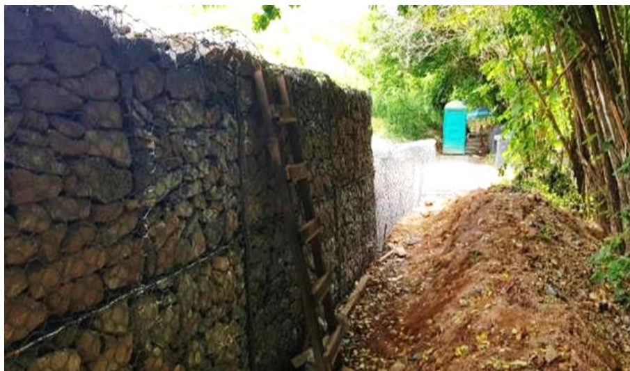
Foto relacionada à: Execução de gabião na bacia 2B - janeiro/2020.
