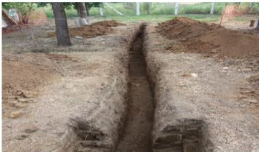
Foto relacionada à: escavação para lançamento da adutora que interliga o poço à ETA de Pedra Corrida, distrito de Periquito/MG – janeiro/2020.
