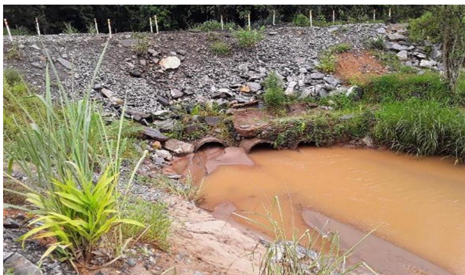
Foto relacionada à: Limpeza do bueiro à jusante no setor 04 - janeiro/2020.
