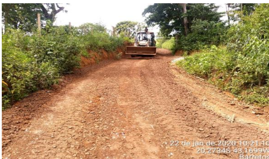
Foto relacionada à: Manutenção de acessos não pavimentados (Acesso principal de Barretos) - janeiro/2020.
