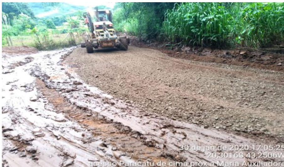
Foto relacionada à: Manutenção de acessos não pavimentados (Trecho Paracatu de Cima - Margem Direita) - janeiro/2020.
