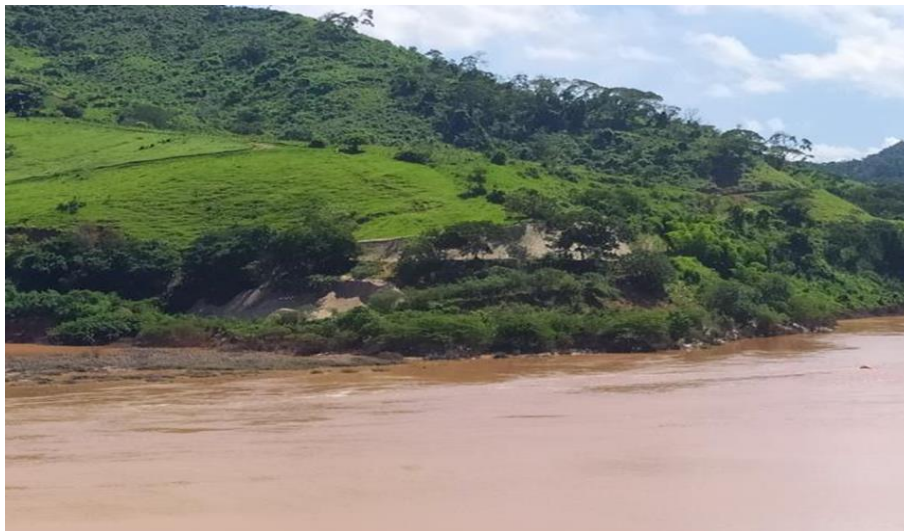
Foto relacionada à: Execução de bioengenharia nos pontos 156 e 157 - janeiro/2020.
