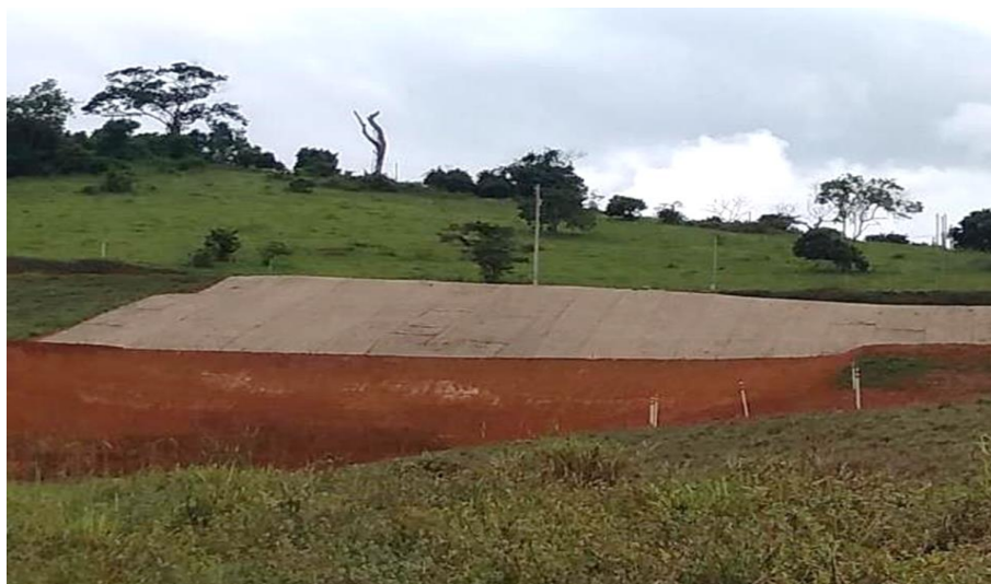
Foto relacionada à: Execução de bioengenharia no setor 08 - janeiro/2020.
