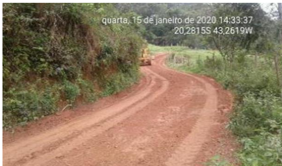
Foto relacionada à: Manutenção de acessos não pavimentados (Trecho Monsenhor Horta x Paracatu de Cima) – janeiro/2020.
