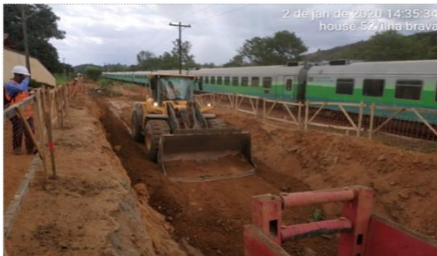
Foto relacionada à: escavação da vala no trecho ferroviário da adutora de Governador Valadares/MG – janeiro/2020.
