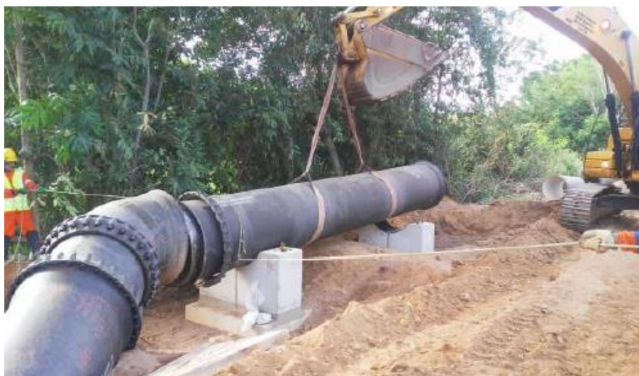
Foto relacionada ao: lançamento da tubulação aérea da adutora de Governador Valadares/MG – janeiro/2020.
