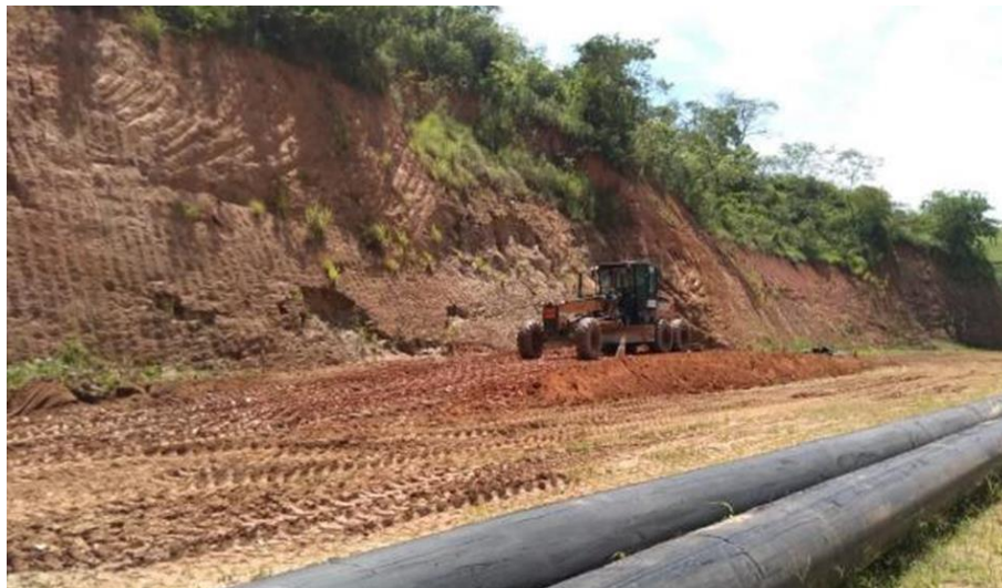
Foto relacionada à: Execução de aterro compactado no ponto 116 - janeiro/2020.
