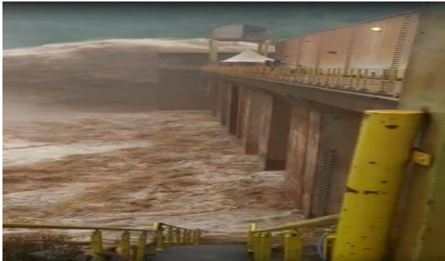
Foto relacionada à: Visão à jusante da UHE após período de chuvas – janeiro/2020.
