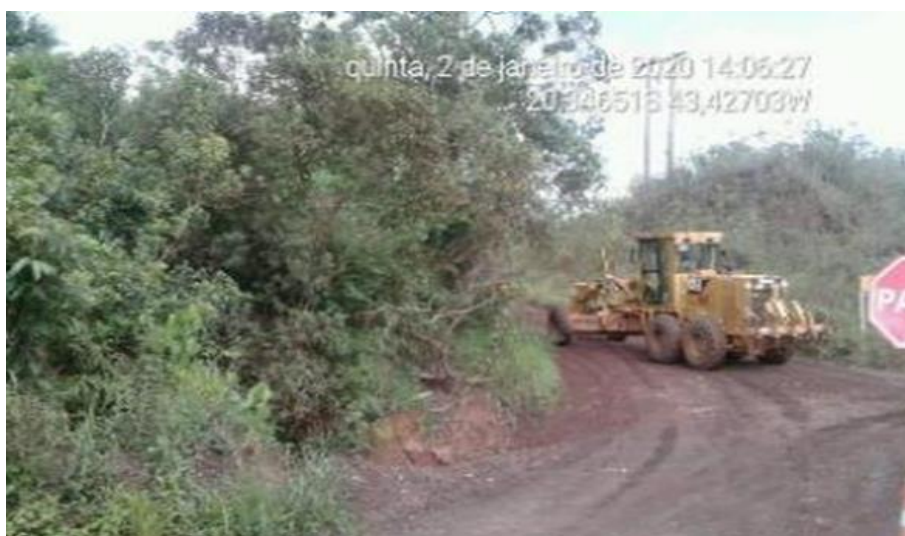
Foto relacionada à: Manutenção de acessos não pavimentados (Trecho Camargos x Mina del Rey) - janeiro/2020.
