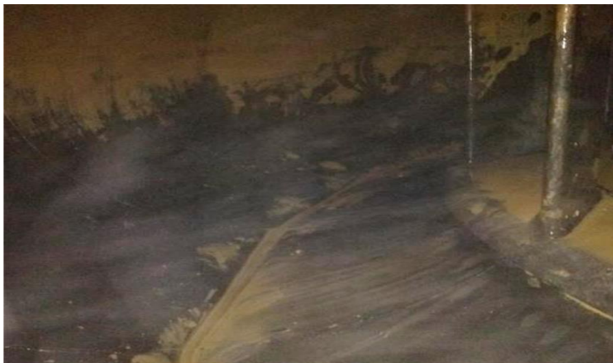
Foto relacionada à: Conclusão da dragagem da caixa espiral da unidade geradora UG1 – janeiro/2020.
