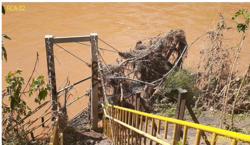
**Observação:** Após forte incidência de chuvas na região no dia 24/01/20 a estrutura onde fica a sonda encontra-se totalmente retorcida e impossibilitada de manutenção, porém transmitindo dados normalmente. Apresentou falhas na transmissão de dados de condutividade, precipitação, nível de água e turbidez no dia 11/02 às 21:00h e condutividade, precipitação, nível de água no dia 14/02 04:00h, devido a falhas na transmissão dos dados.
