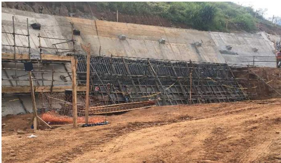
**Foto relacionada à:** Forma, armação e concreto no ponto 115 - junho/2019.
