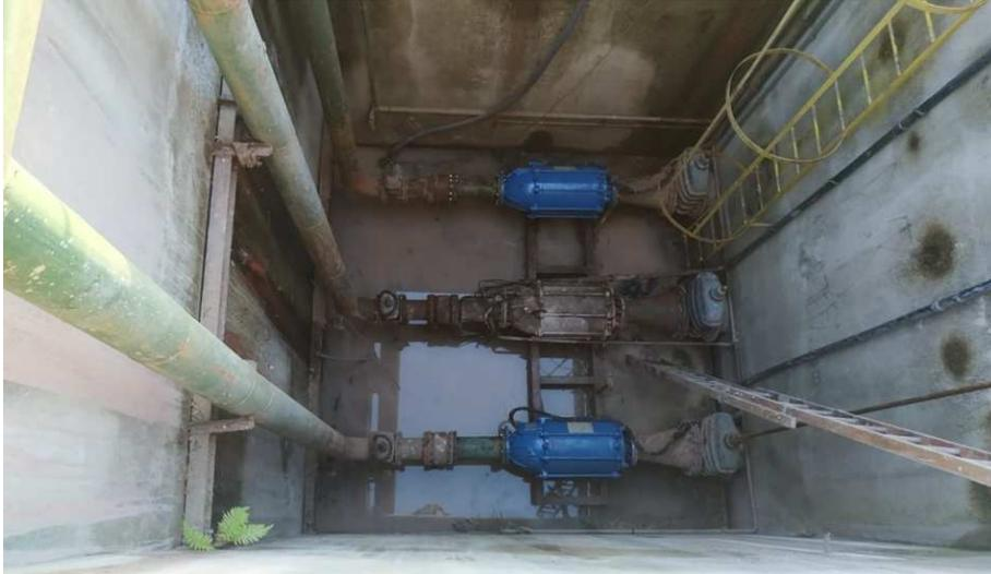
**Foto relacionada à:** Manutenção e instalação de duas bombas para captação no Rio Pequeno no SAAE de Linhares/ES – outubro/2019.
