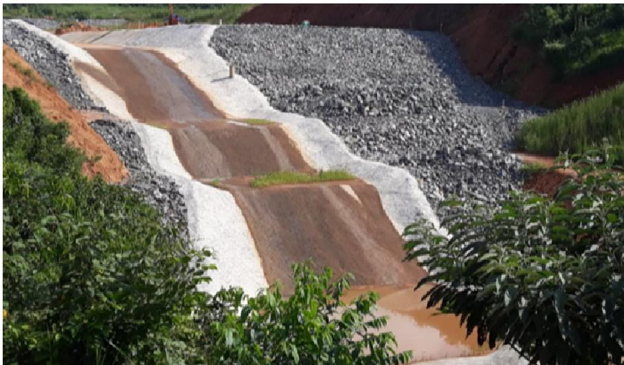
**Foto relacionada à:** Limpeza do canal extravasor provisório no setor 11 - maio/2019.
