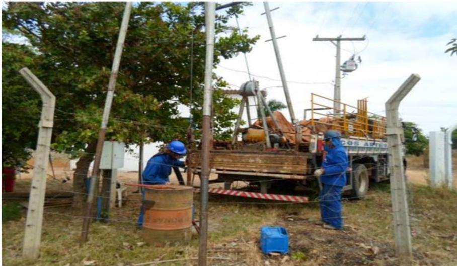
**Foto relacionada à:** Recuperação e perfilagem no poço tubular existente em São Vitor, distrito de Governador Valadares/MG – janeiro/2019
