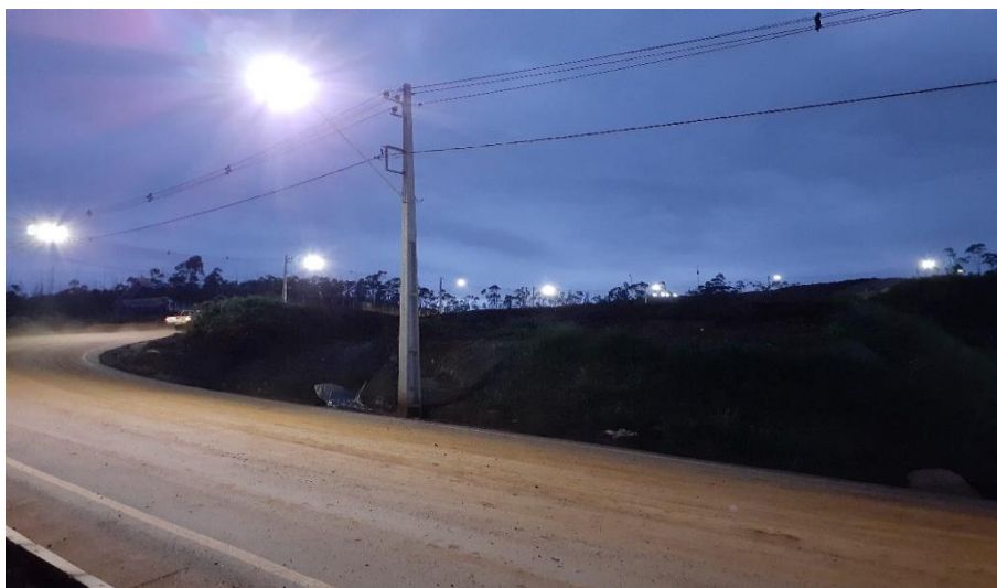
Foto relacionada à: Conclusão da rede elétrica do Acesso - novembro/2019.
