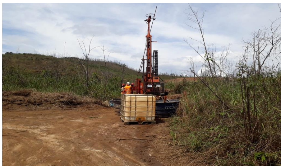
Foto relacionada à: Realização Sondagens ETE - novembro/2019.
