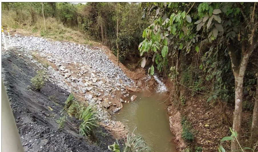
Foto relacionada ao: Enrocamento e limpeza a montante no Córrego dos Borges - novembro/2019.
