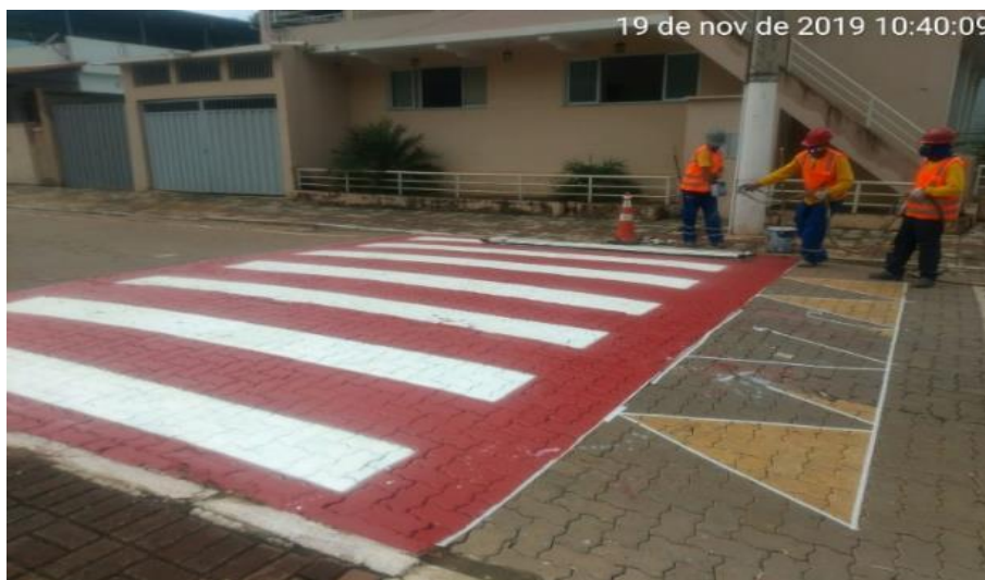
Foto relacionada à: Execução de sinalização horizontal (Barra Longa) - novembro/2019.
