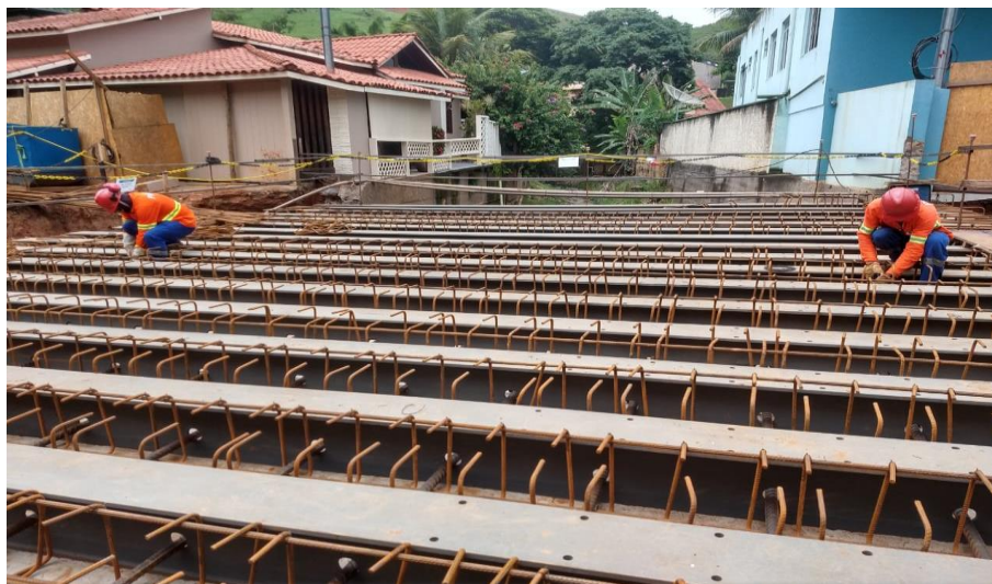
Foto relacionada à: Armação da ponte em Rio Doce/MG - novembro/2019.
