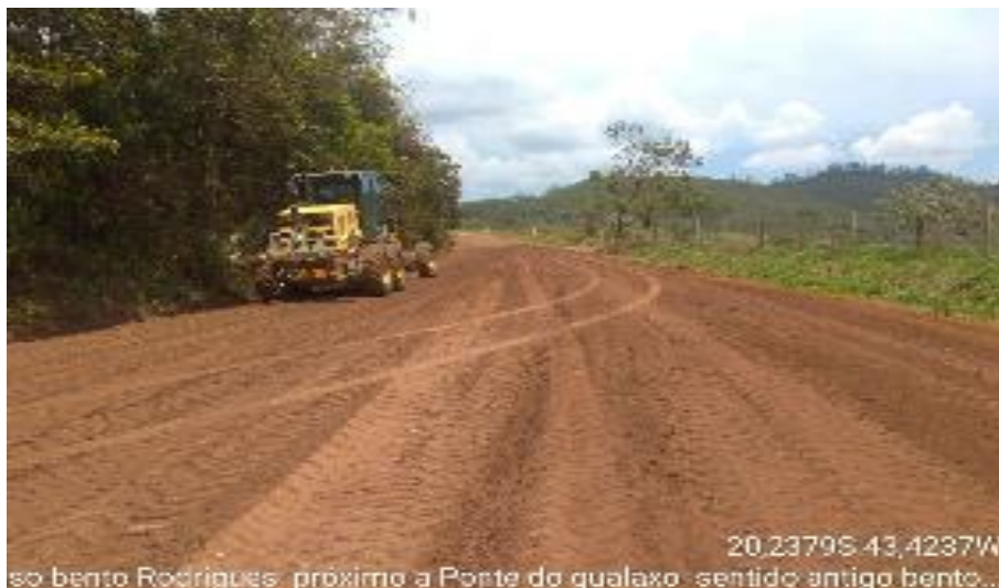
Foto relacionada à: Manutenção de acessos não pavimentados (Trecho Mariana x Bento Velho) – novembro/2019.
