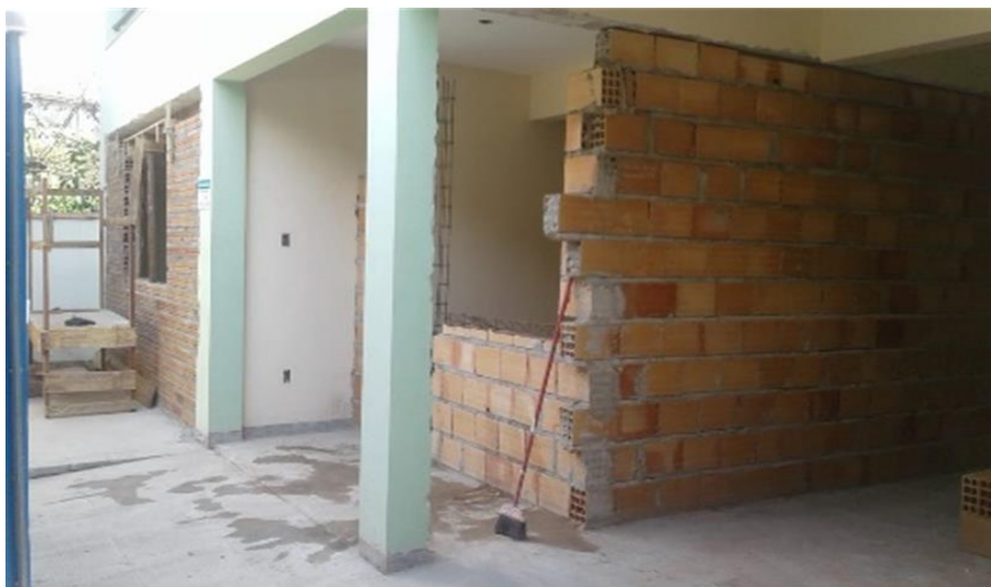
Foto relacionada ao: Início da reforma para MCM – novembro/2019.
