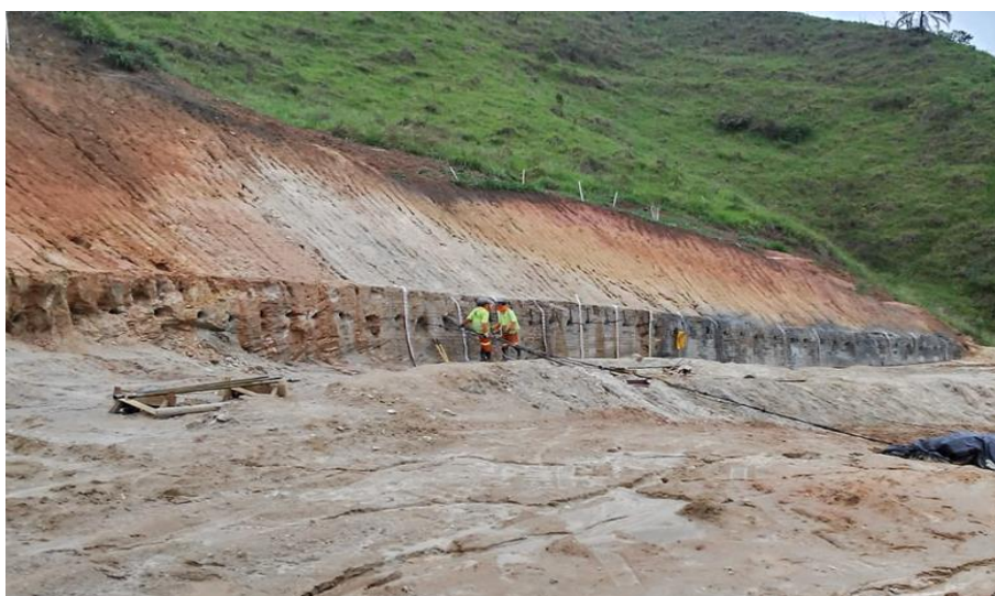
Foto relacionada ao: Solo Grampeado (Trecho A) - novembro/2019.
