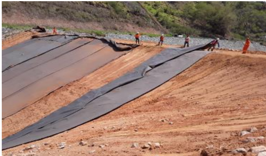
Foto relacionada à: Aplicação de manta geotêxtil na bacia 2A – novembro/2019.
