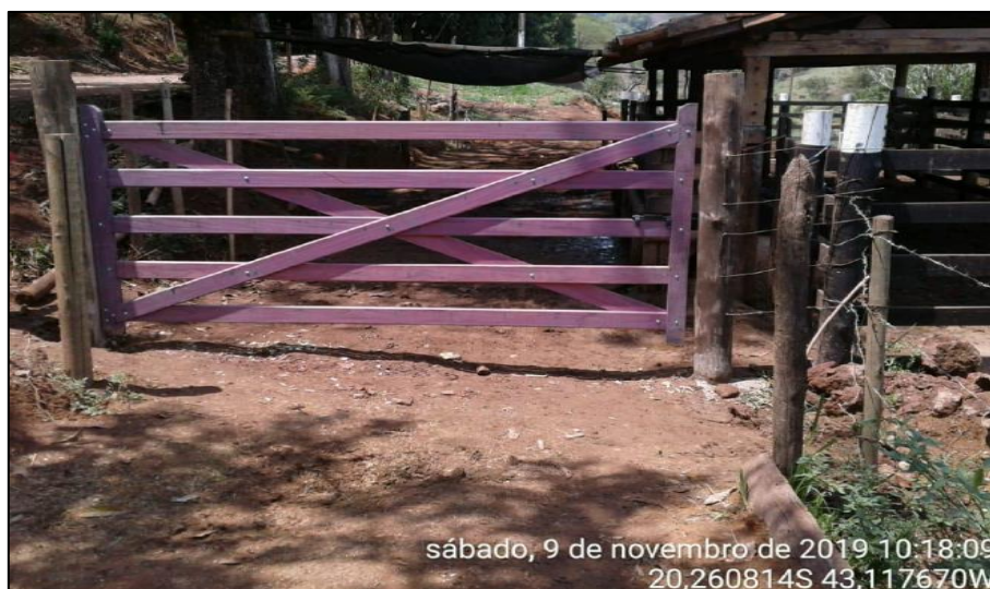
Foto relacionada à: Reconstrução de estruturas de apoio em Barra Longa - novembro/2019.
