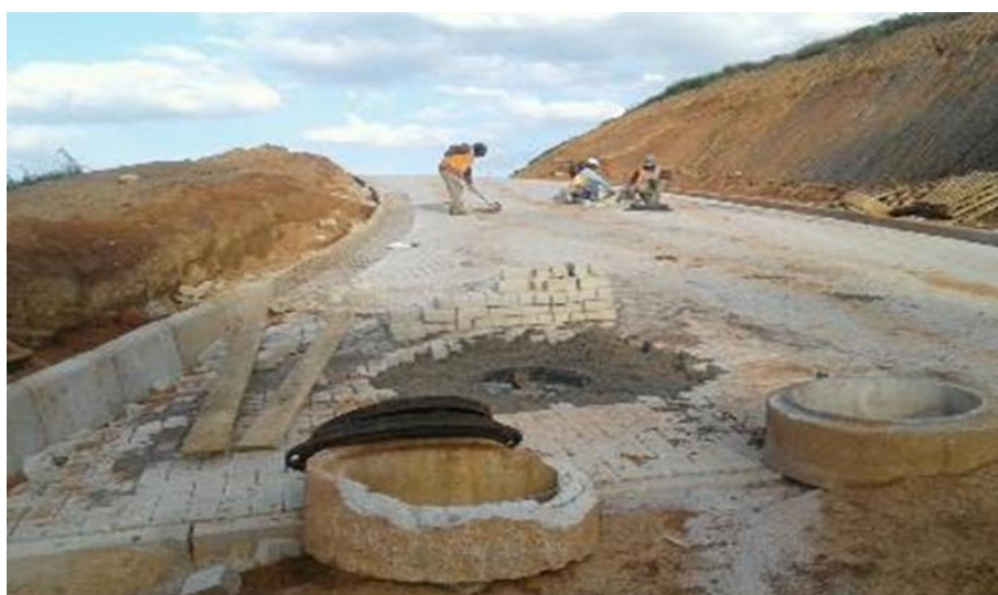
Foto relacionada ao: Assentamento de piso intertravado (Rua Carlos Pinto) - novembro/2019.
