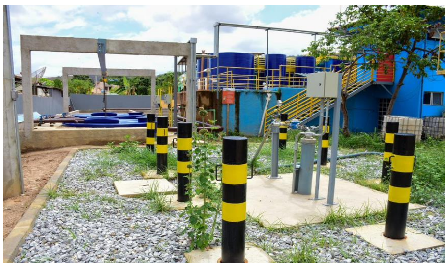
Foto relacionada aos: poços e nova ETA de Galileia/MG – novembro/2019.
