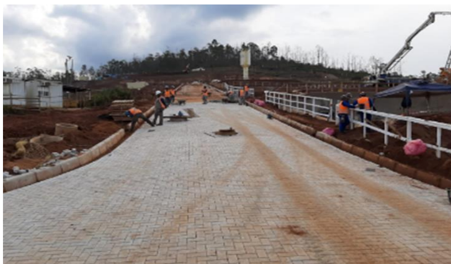
Foto relacionada à: Execução de Piso Intertravado (R. Nova 2) - novembro/2019.
