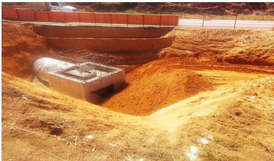
Foto relacionada à: obra no Tunnel Liner da adutora do rio Corrente Grande, em Governador Valadares/MG – novembro/2019.
