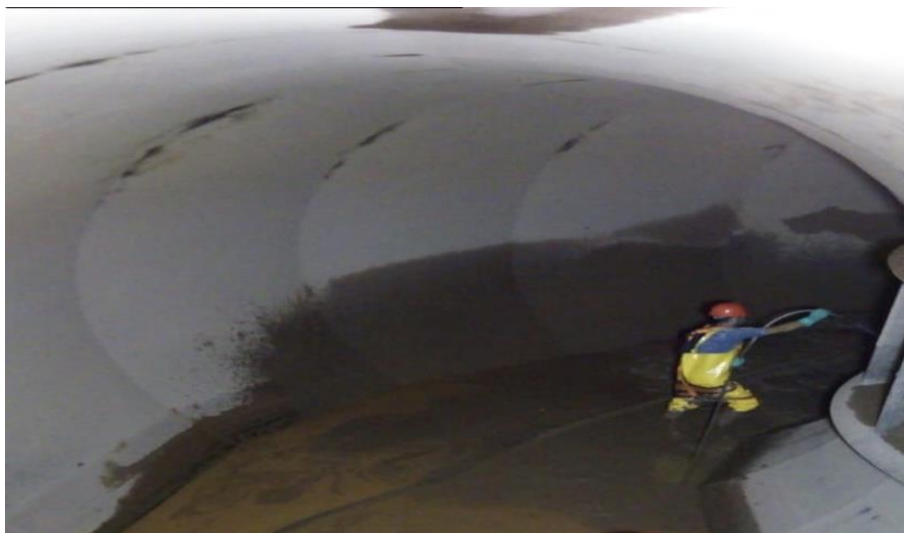
Foto relacionada à: Limpeza caixa espiral da unidade geradora – UG3 – novembro/2019.
