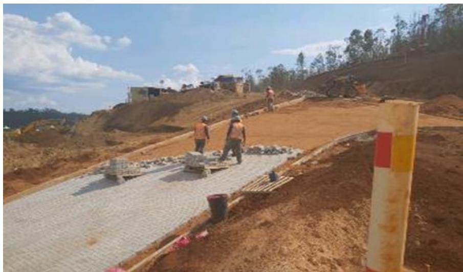
Foto relacionada à: Execução de Piso Intertravado (R. Nova 5) - novembro/2019.
