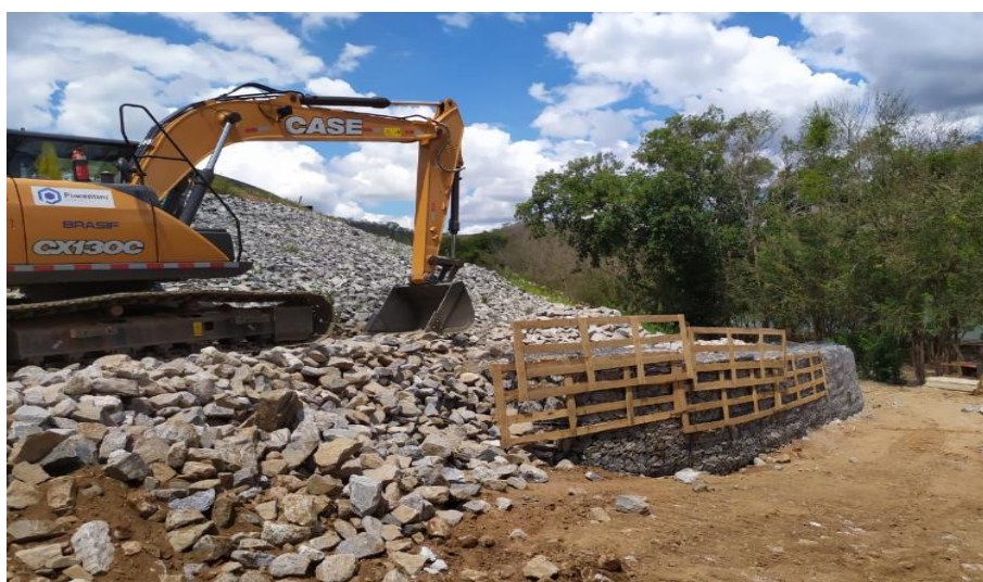
Foto relacionada à: Execução de muro gabião na Bacia 2 - novembro/2019.
