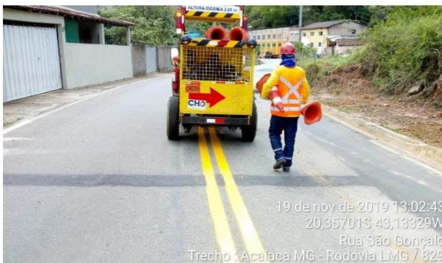
Foto relacionada à: Execução de sinalização horizontal (Acaiaca) - novembro/2019.
