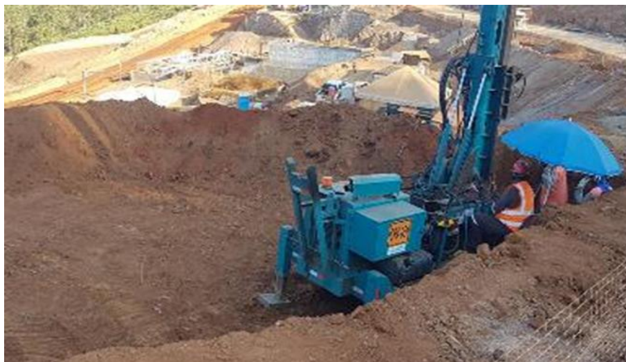
Foto relacionada à: Execução de Fundação ID 49 - novembro/2019.
