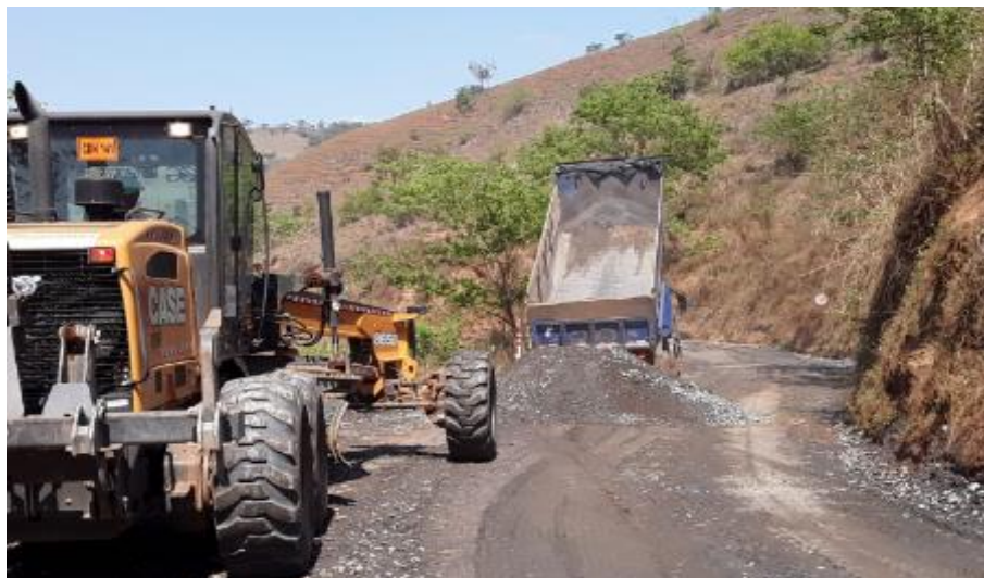
Foto relacionada às: Manutenções de acessos no Setor 11 – novembro/2019.
