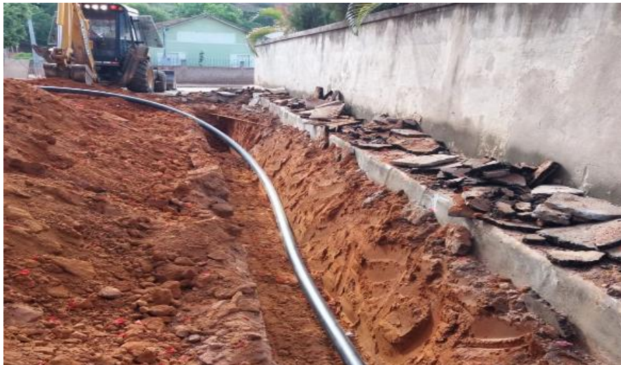
Foto relacionada à: escavação da vala da adutora de interligação do poço em Pedra Corrida, distrito de Periquito/MG – novembro/2019.
