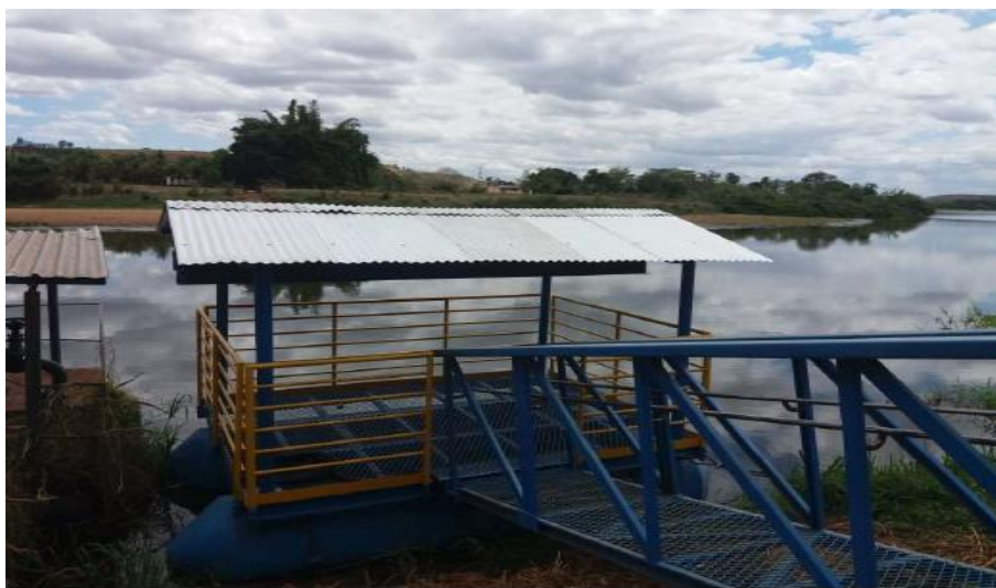
Foto relacionada à: nova balsa da captação no rio Doce da ETA de São Vitor, distrito de Governador Valadares/MG – novembro/2019.
