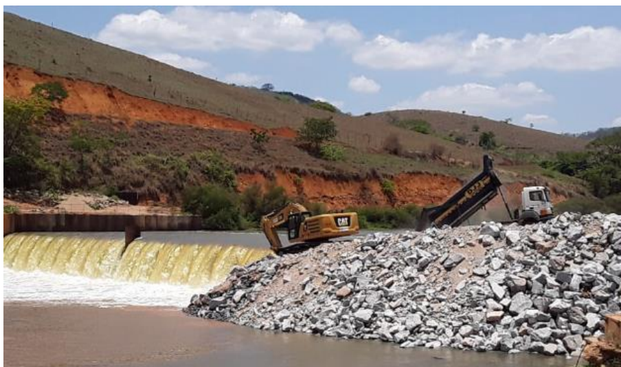
Foto relacionada ao: Enrocamento a jusante no barramento C – novembro/2019.
