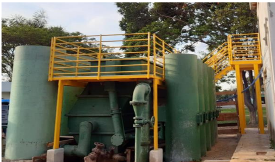
Foto relacionada às: obras de melhoria na ETA de Pedra Corrida, distrito de Periquito/MG – novembro/2019.
