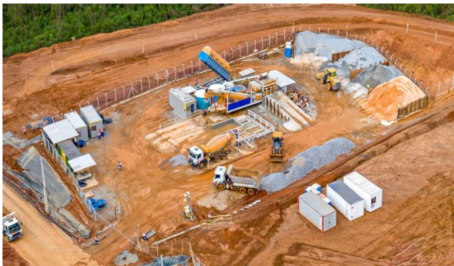
Foto relacionada à: Operação da central de concreto – novembro/2019.
