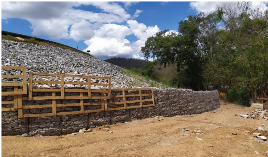
Foto relacionada à: Execução de muro gabião na bacia 2 – novembro/2019.
