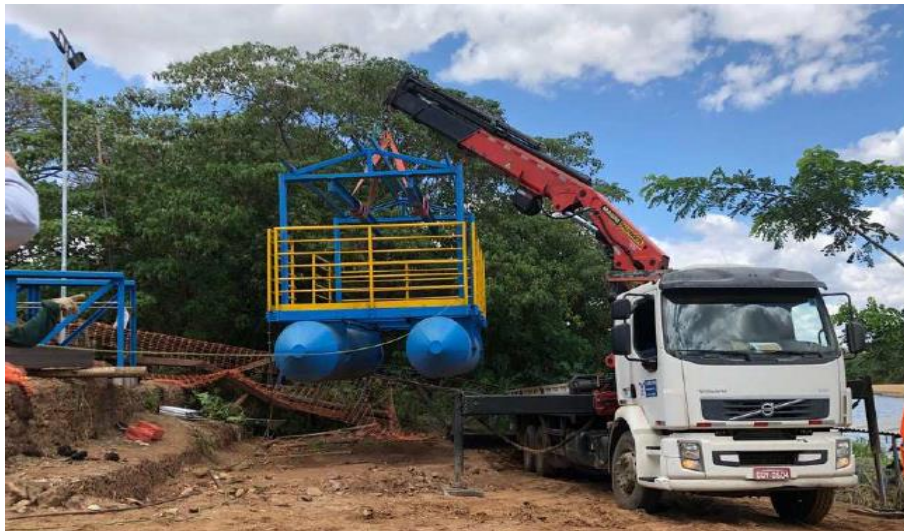
Foto relacionada à: instalação da balsa da captação no rio Doce da ETA de São Vitor, distrito de Governador Valadares/MG – novembro/2019.
