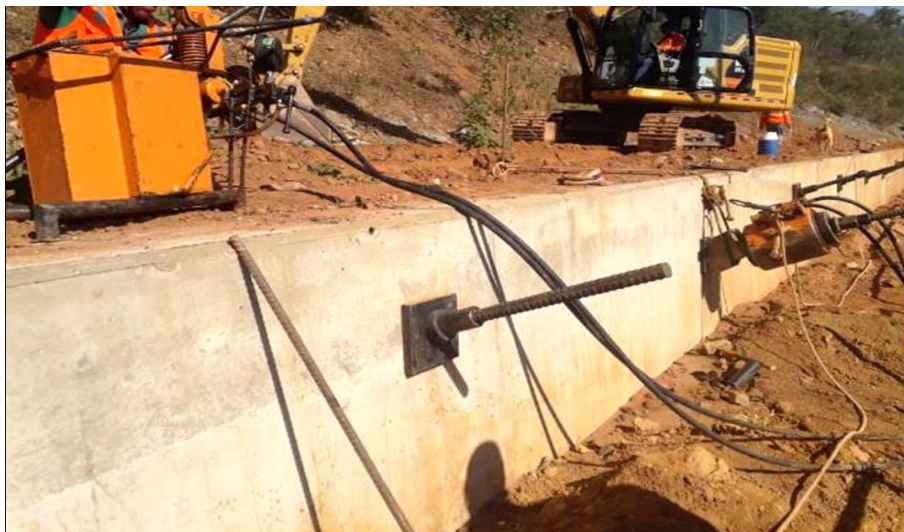
Foto relacionada à: Protensão de tirantes no barramento A – novembro/2019.
