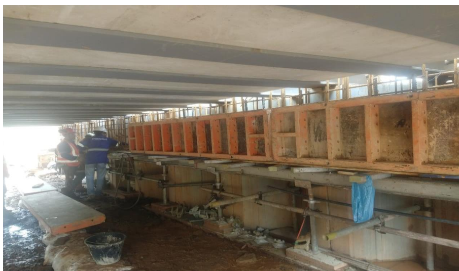
Foto relacionada à: Montagem de forma e escoramento da ponte em Rio Doce/MG - novembro/2019.
