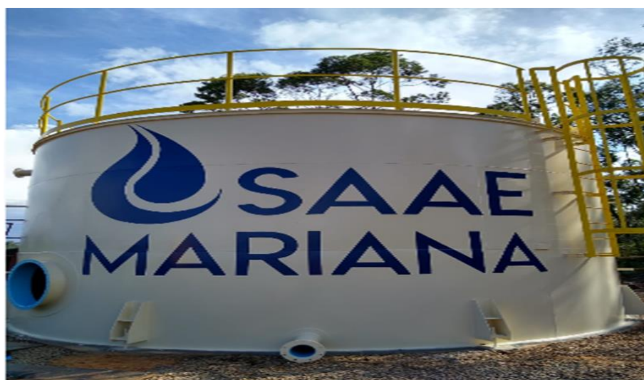
Foto relacionada à: Montagem do reservatório de água potável do loteamento - novembro/2019.
