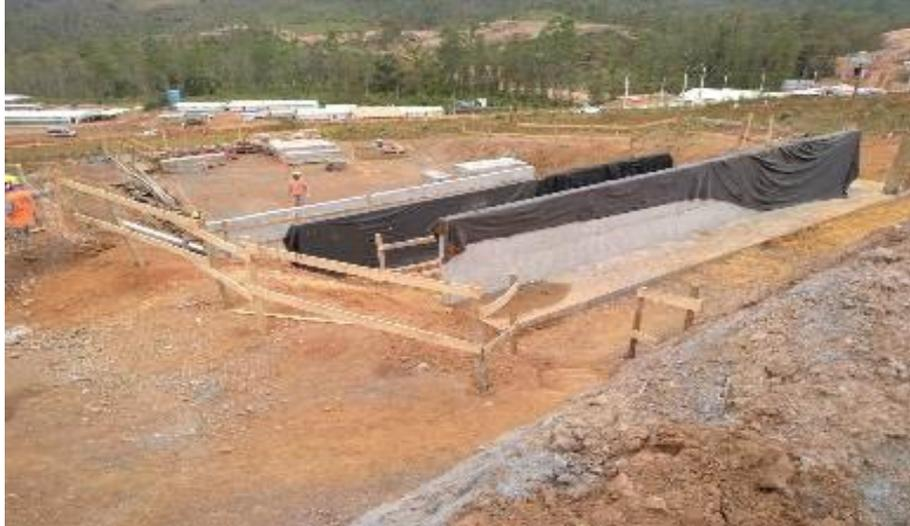
**Foto relacionada à:** Concretagem do muro ID 30 na Quadra C - setembro/2019.
