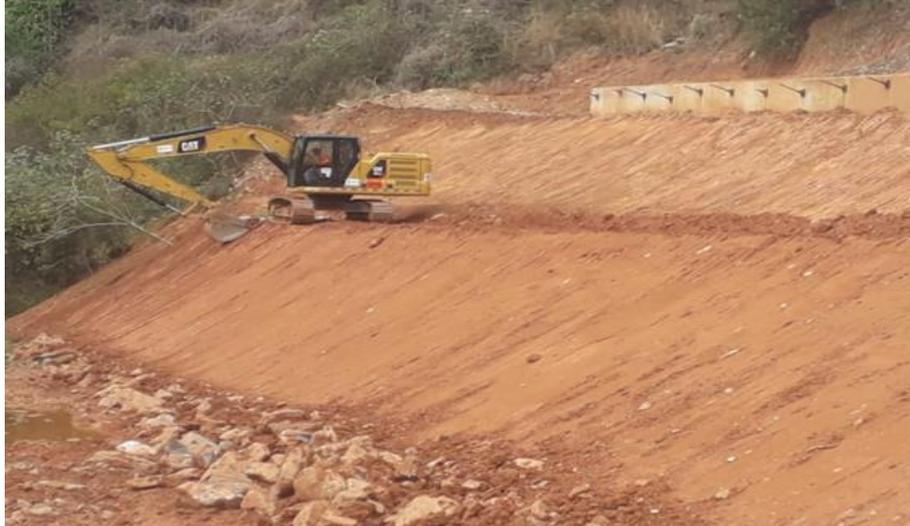
**Foto relacionada à:** Conformação do talude da ombreira direita – Barramento A - agosto/19.
