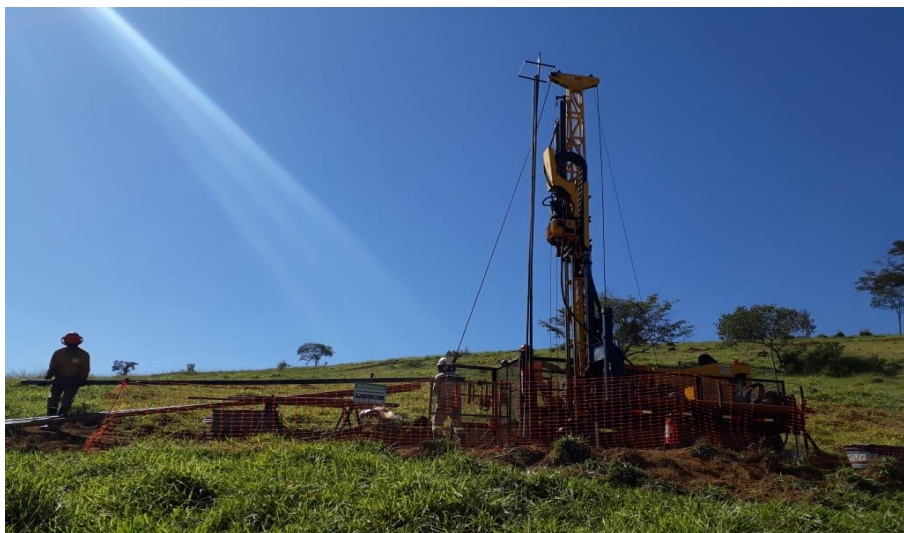
Foto relacionada à: Execução de sondagens – julho/2019.
