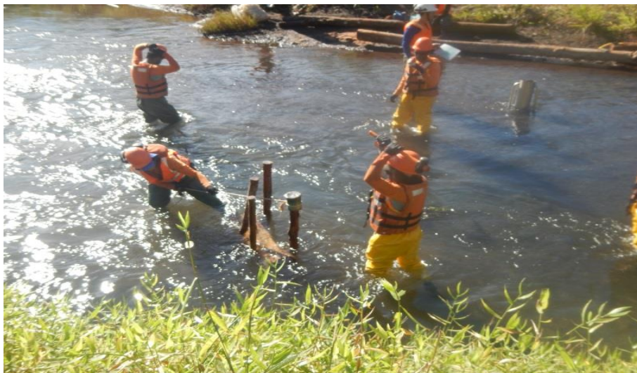
Foto relacionada à: Implantação dos troncos no projeto de Renaturalização. Rio Gualaxo do Norte – julho/2019.
