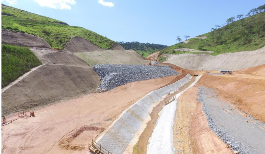
Foto relacionada ao: Canal Extravasor Provisório Setor 11- Julho/19.
