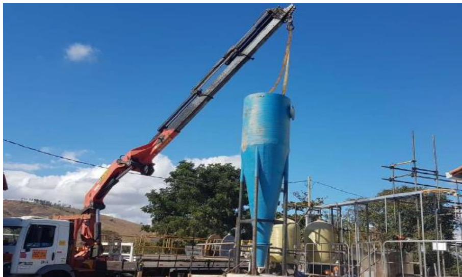
Foto relacionada à: instalação do hidrociclone na ETA de Galileia/MG – Julho/2019.
