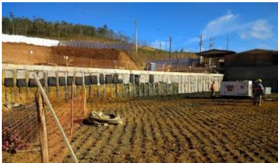
Foto relacionada à: Concretado Projetado Contenção 2 – Posto de Saúde – julho/2019.
