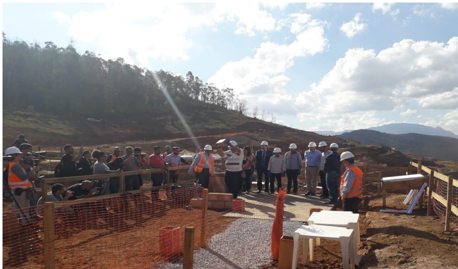
Foto relacionada à: Início das obras civis – ID 57 – julho/2019.
