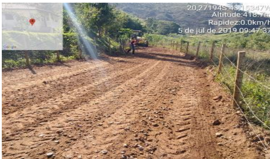
Foto relacionada à: Manutenção de Acessos Não Pavimentados – Trecho Gesteira/Campinas (Julho/2019).
