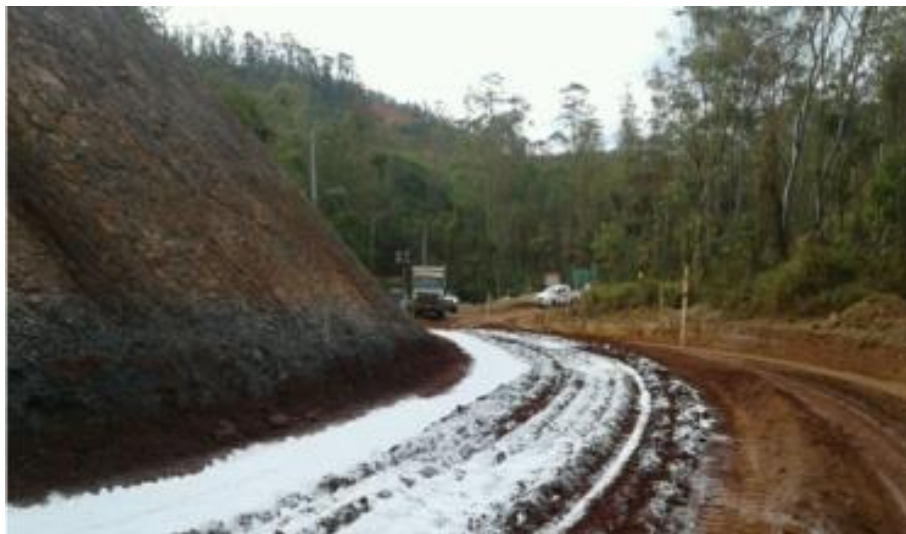
Foto relacionada à: Reforço do subleito – Acesso principal – julho/2019.
