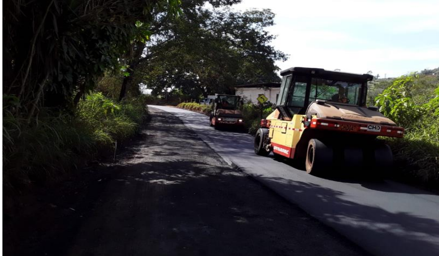
Foto relacionada à: Pavimentação asfáltica acesso principal BR MGC-120 até o Lava Rodas - Julho/19.
