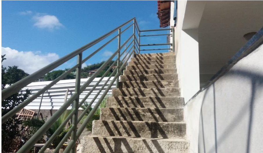
Foto relacionada à: Manutenção de Edificações – H.F.T (Julho/2019).
