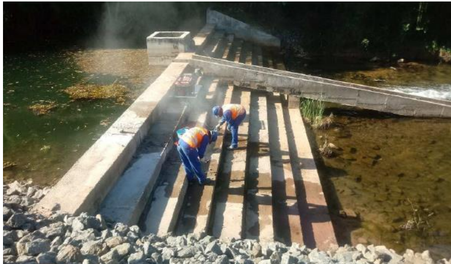
Foto relacionada à: obras de reparo e limpeza do Barramento do rio Pequeno em Linhares/ES – Julho/2019.
