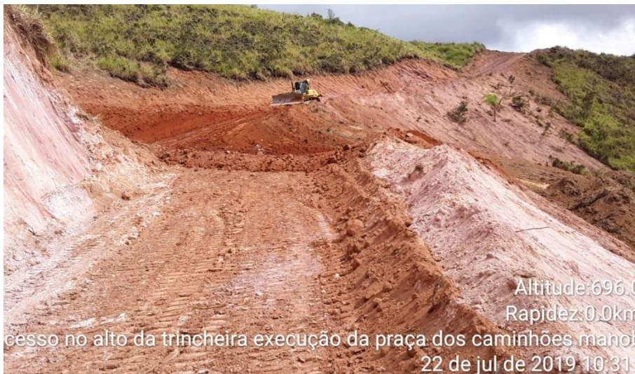
Foto relacionada à: Execução do caminho de serviço – Acesso Principal – julho/2019
