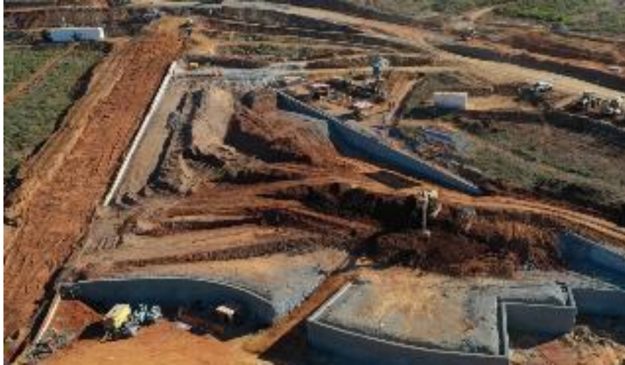
Foto relacionada ao: Arrasamento das estacas da Contenção 1 - Escola - julho/2019.
