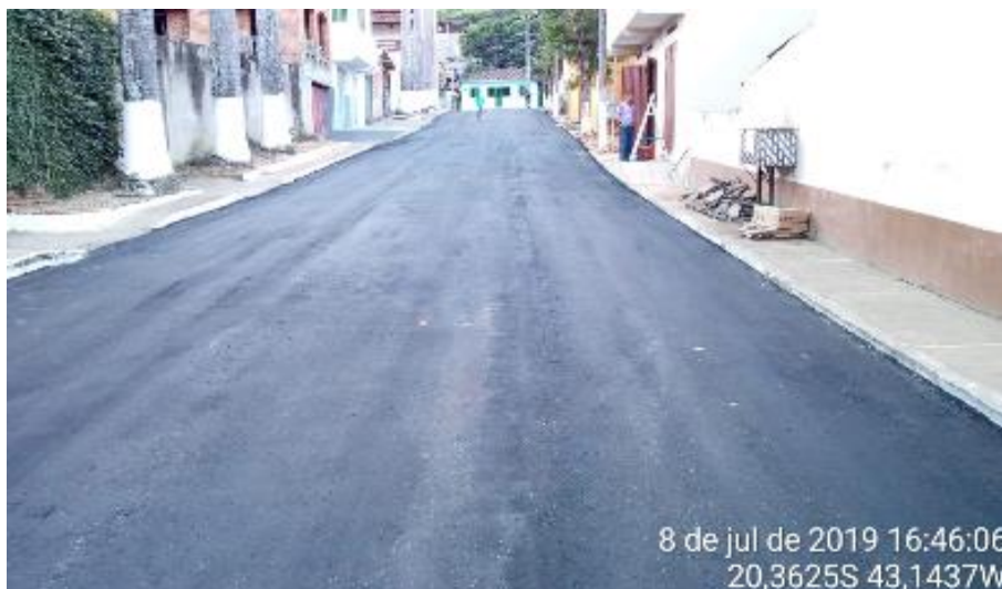
Foto relacionada à: Manutenção de Acessos Pavimentados – Rua Padre Esperdião (Acaiaca) (Julho/2019).
