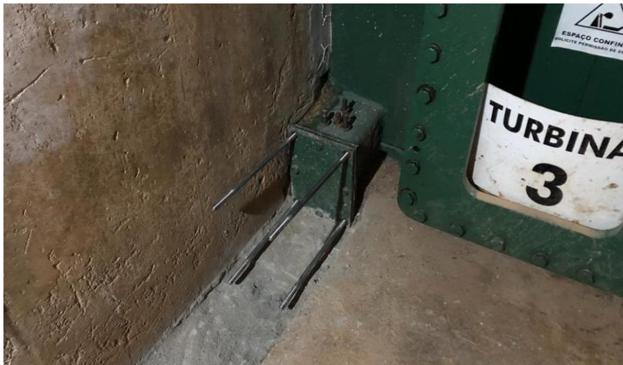
Foto relacionada à: Instalação do dispositivo de drenagem na UG03 - Julho/19.
