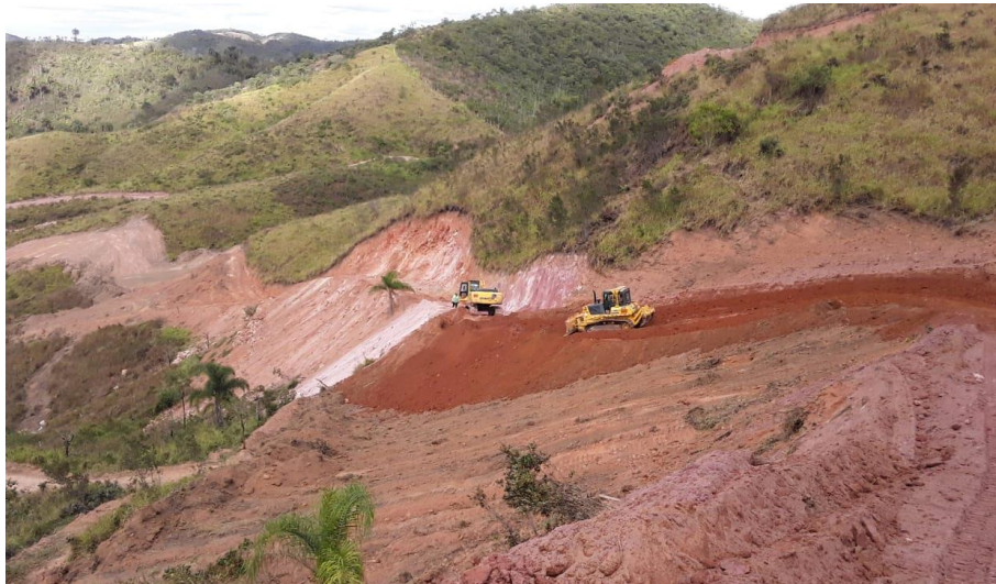
Foto relacionada à: Serviços preliminares – Acesso Principal – julho/2019
