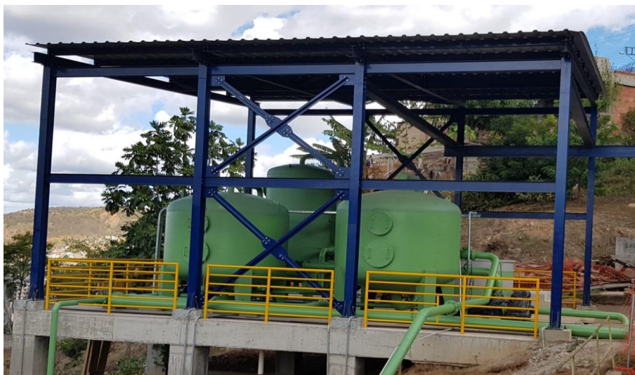
Foto relacionada à: montagem do Sistema Abrandador em Resplendor/MG – Julho/2019.
