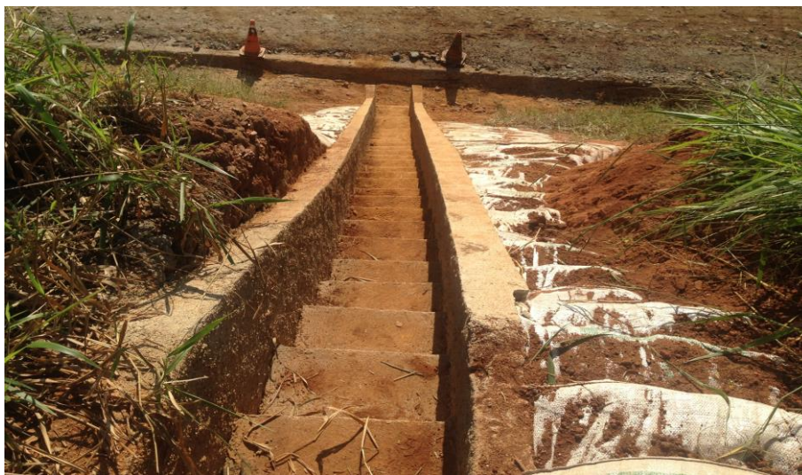
Foto relacionada à: Manutenção sistemas de drenagem Setor 11 - Julho/19.
