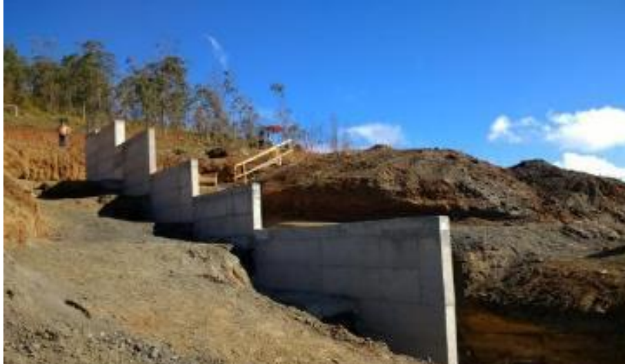
Foto relacionada à: Muro de Contenção do ID 50 - Quadra F – julho/2019.
