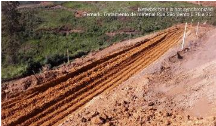
Foto relacionada ao: Tratamento de material na Rua São Bento - junho/2019.
