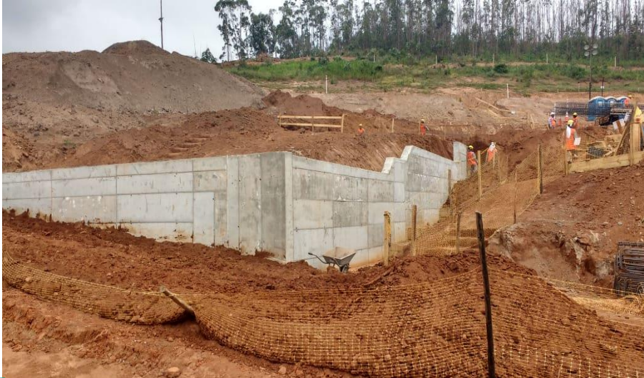
Foto relacionada à: Quadra F – Muro de Arrimo – junho/2019.
