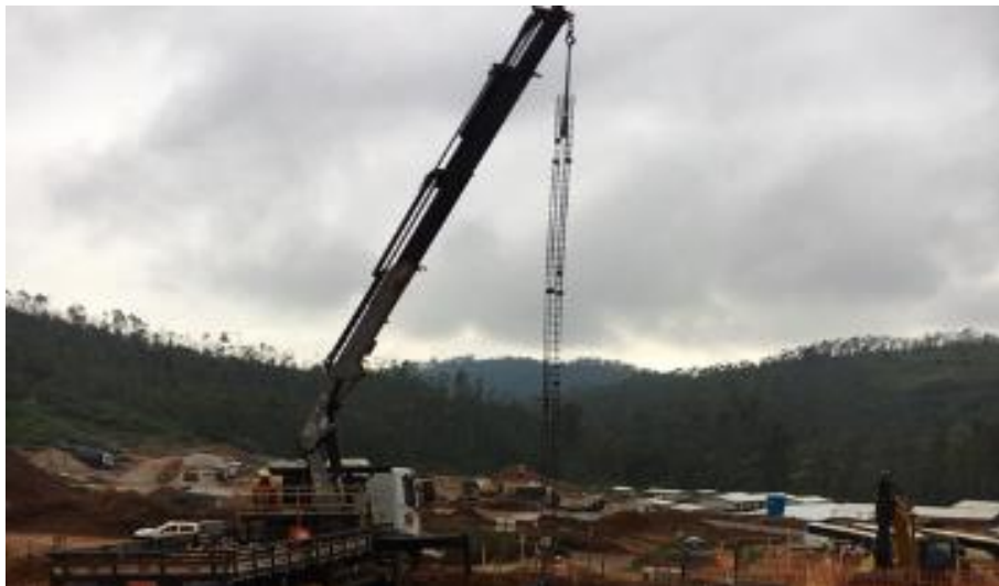
Foto relacionada à: Escola – Instalação da armadura para concretagem – junho/2019.
