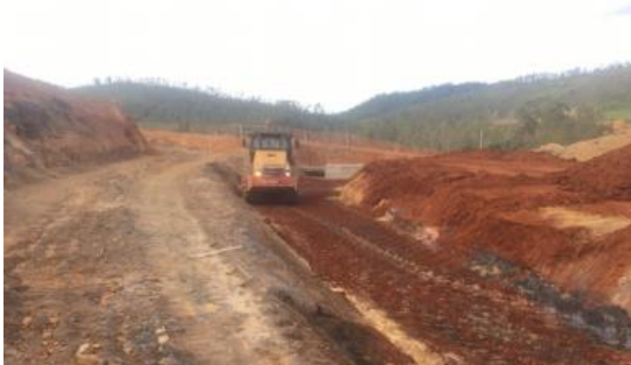
Foto relacionada à: Compactação de Vala – Travessa C. Veloso – junho/2019.
