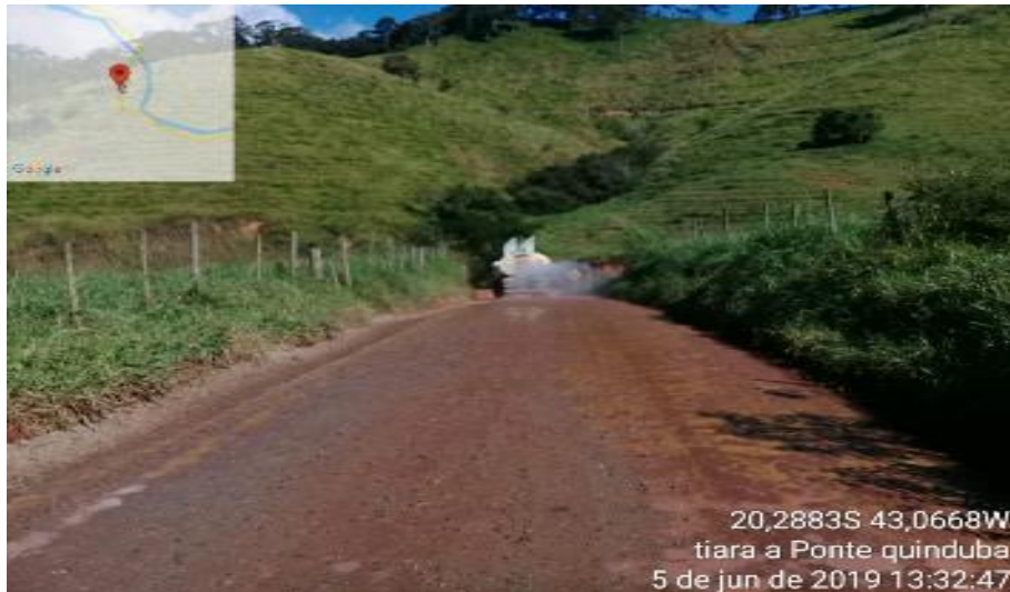
Foto relacionada à: Manutenção de Acessos Não Pavimentados – Trecho Ponte Quindumba/Ponte da Onça (Junho/2019).
