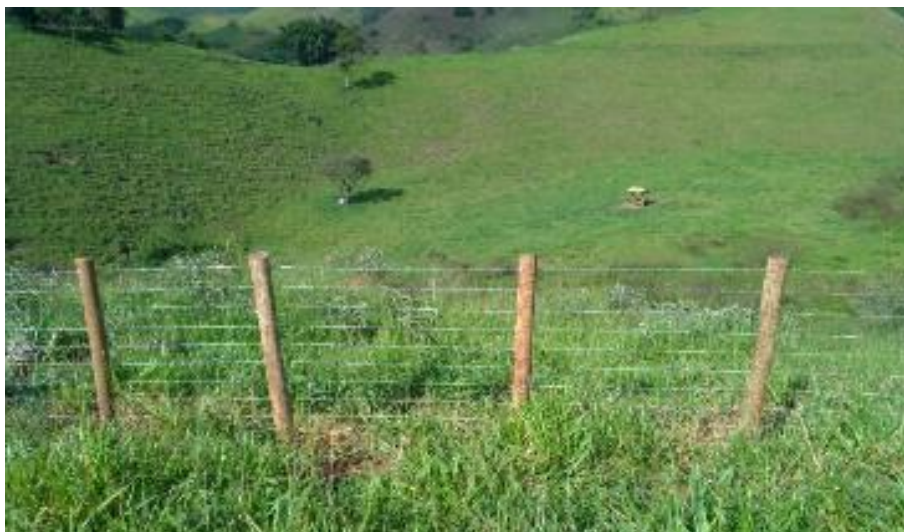
Foto relacionada à: Execução do cercamento da poligonal – junho/2019
