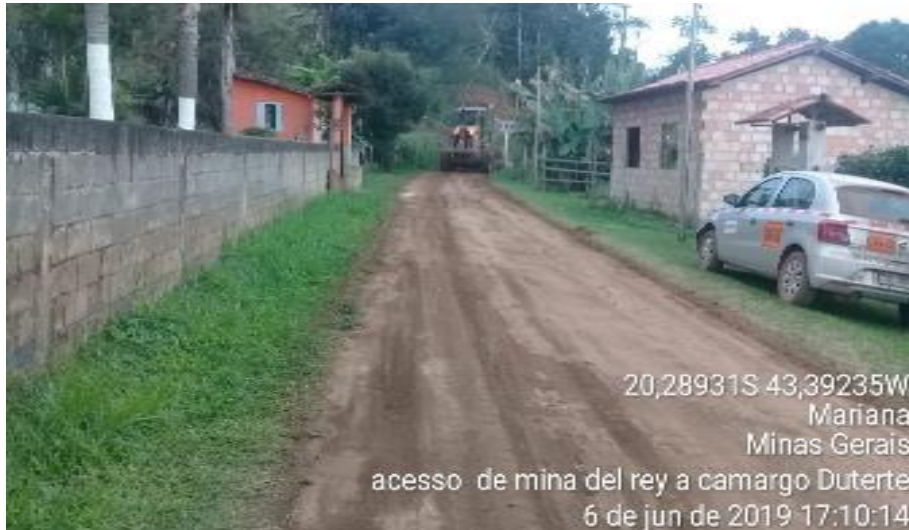
Foto relacionada à: Manutenção de Acessos Não Pavimentados – Trecho Mina del Rei/Camargos (Junho/2019).
