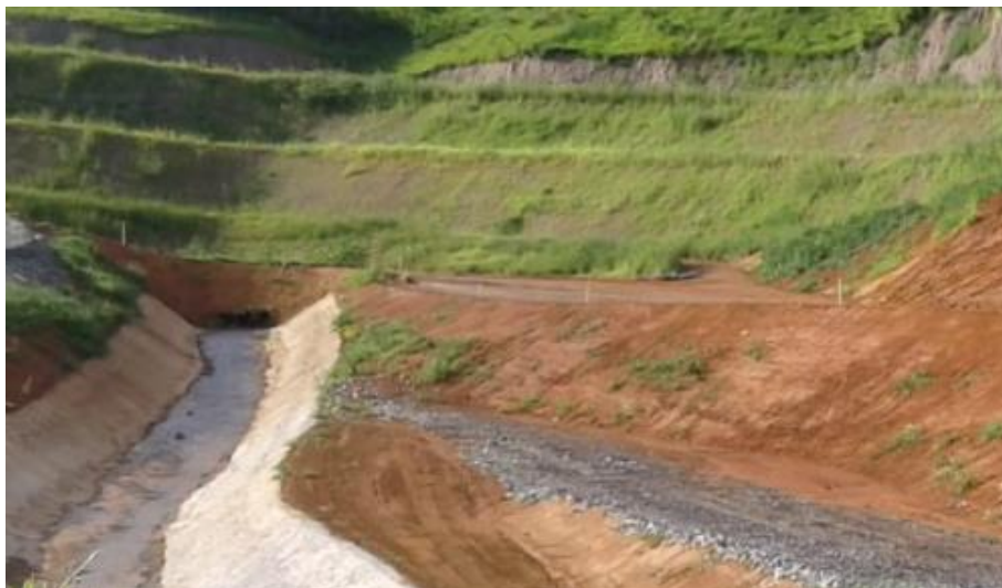
Foto relacionada à: Canal Extravasor Provisório do setor 11 - Junho/19.
