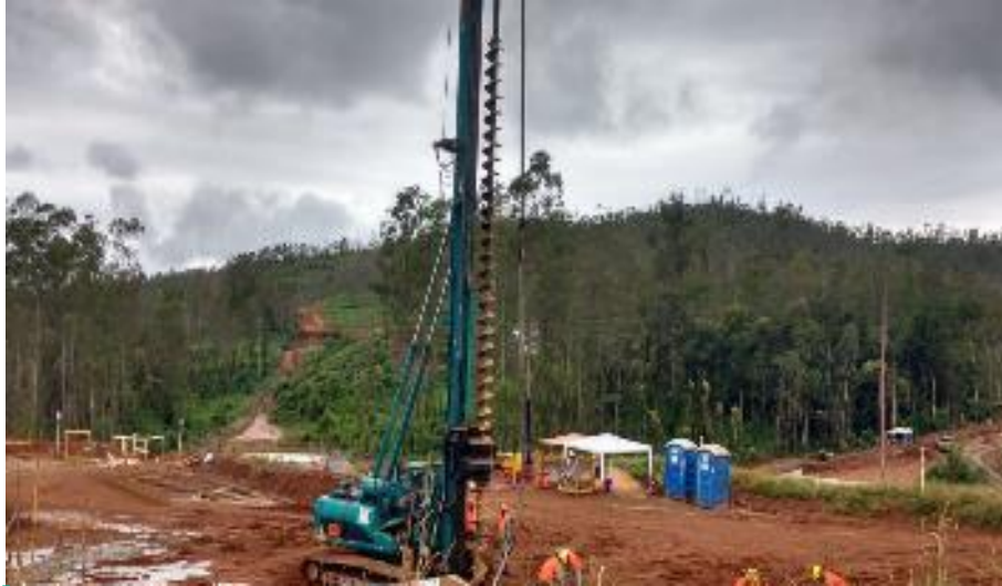
Foto relacionada à: UBS – Execução de estaca Hélice Contínua – junho/2019.
