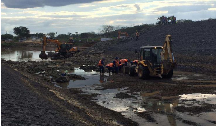
Foto relacionada à: limpeza colchão reno do Barramento do rio em Linhares/ES – Junho/2019.
