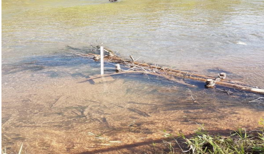
Foto relacionada à: Implantação dos troncos no projeto de Renaturalização. Rio Gualaxo do Norte – junho/2019.
