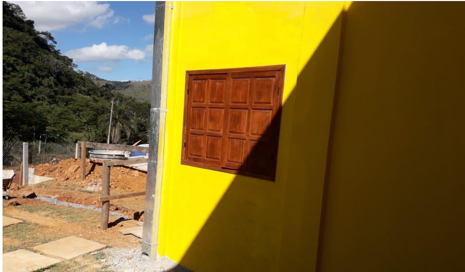
Foto relacionada à: Manutenção de Edificações – A.T.N. (Junho/2019).
