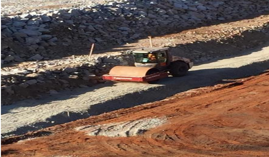
Foto relacionada à: Compactação de material do tipo TU – junho/2019.
