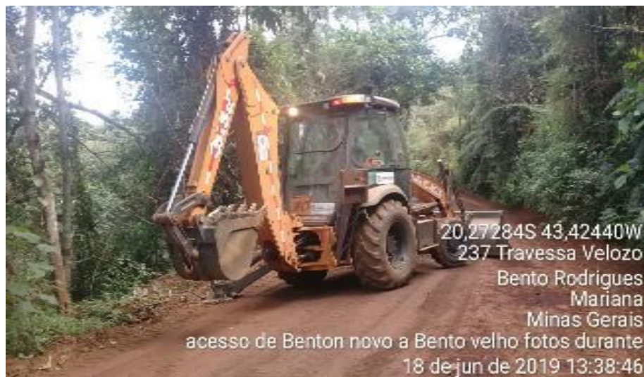
Foto relacionada à: Manutenção de Acessos Não Pavimentados – Trecho Bento Velho/Vila Samarco (Junho/2019).
