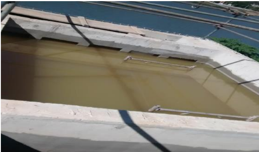
Foto relacionada à: teste de carga d'água do reservatório da ETA de Resplendor/MG – Junho/2019.
