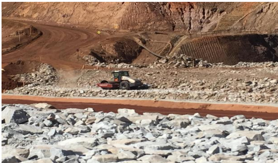
Foto relacionada à: Compactação de material do tipo E1 – junho/2019.
