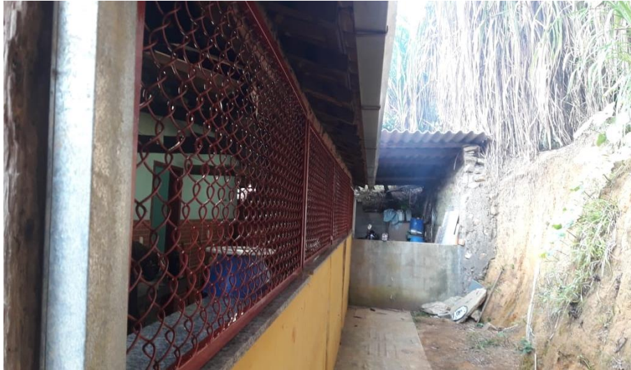
Foto relacionada à: Manutenção de Edificações – M.E. (Junho/2019).
