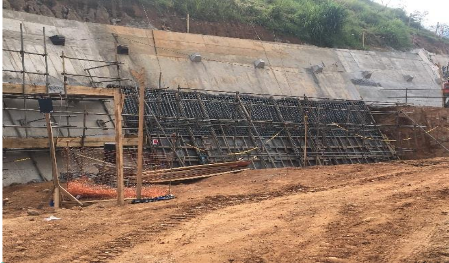
Foto relacionada à: Forma, Armação e Concreto - Ponto 115 - Junho/19
