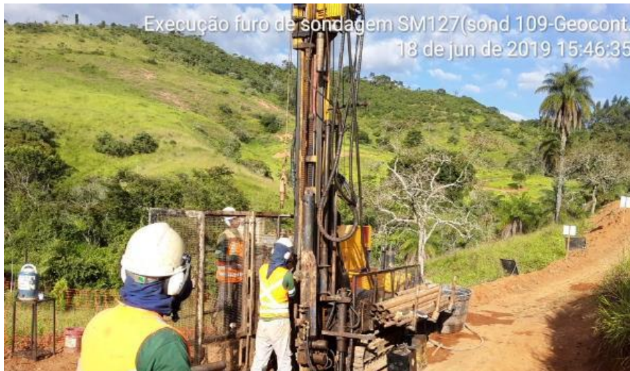
Foto relacionada à: Execução de sondagem – junho/2019.
