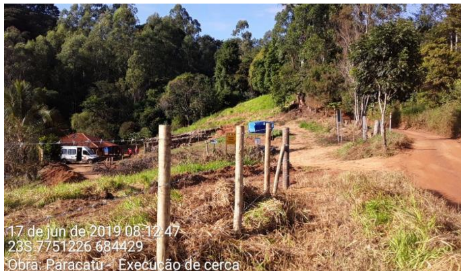
Foto relacionada à: Execução do cercamento – junho/2019
