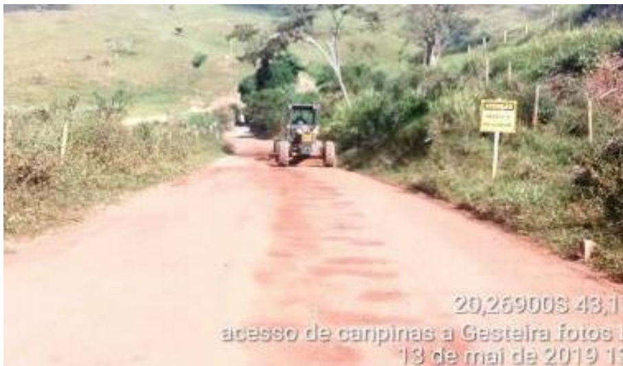
Foto relacionada à: Manutenção de Acessos Não Pavimentados – Trecho Gesteira/Campinas (Maio/2019).
