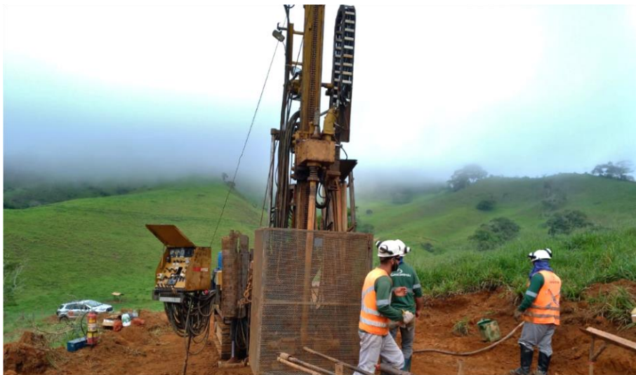
Foto relacionada à: Execução de Sondagem – maio/2019
