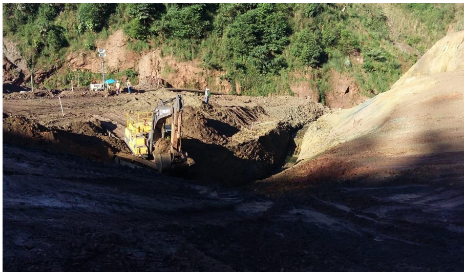
Foto relacionada à: Escavação chaveta – maio/2019.
