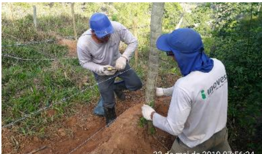
Foto relacionada à: atividade manutenção de cercas, Pancas (ES)
