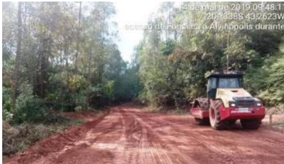
Foto relacionada à: Manutenção de Acessos Não Pavimentados – Trecho Alvinópolis/Fonseca (Maio/2019).
