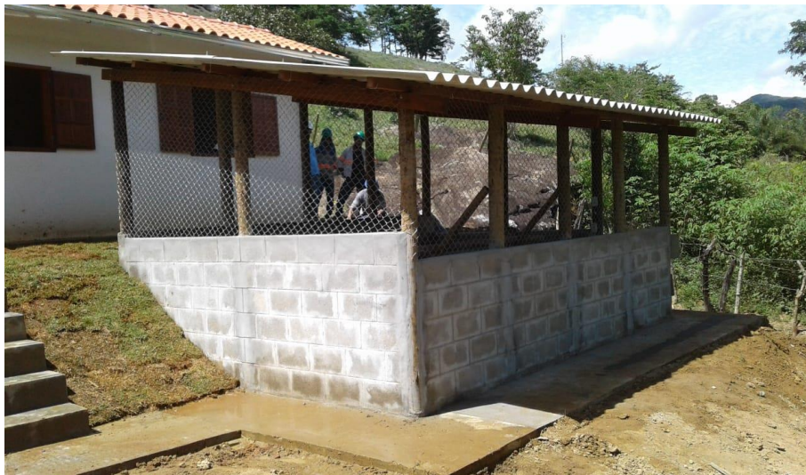
Foto relacionada à: Estrutura de Apoio – G.P. (Maio/2019).
