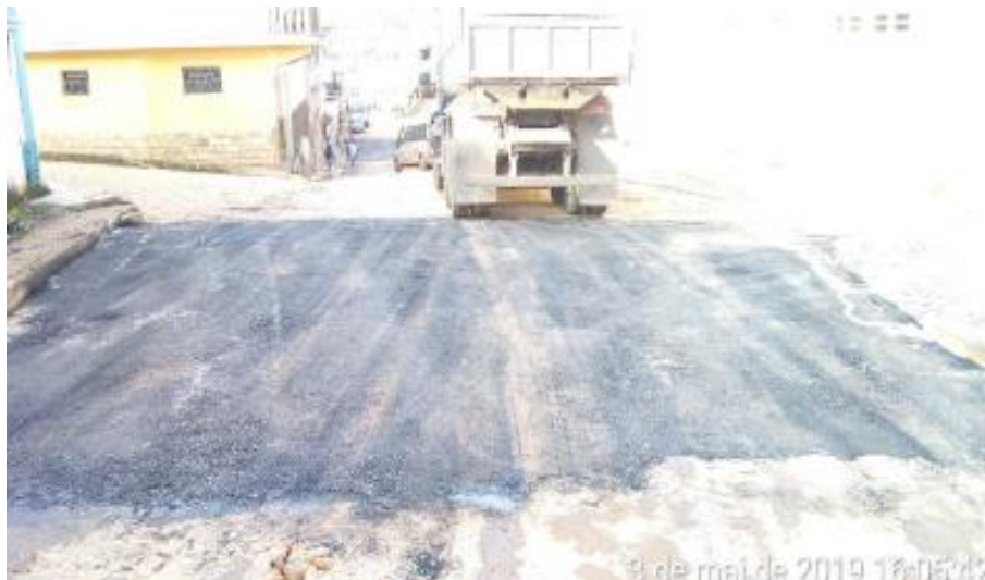
Foto relacionada à: Manutenção de Acessos Pavimentados – Rua Coronel Olímpio Soares Pena (Alvinópolis) (Maio/2019).
