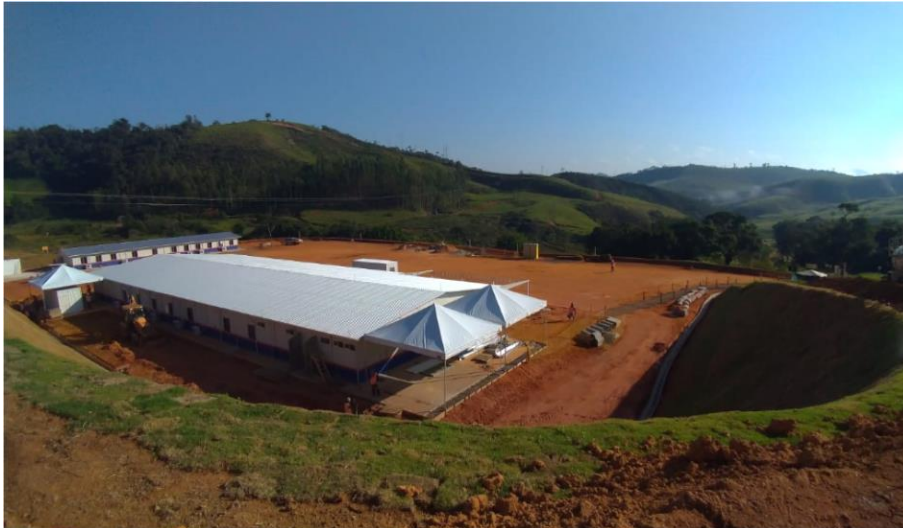
Foto relacionada à: Execução do refeitório e escritório – canteiro de obras – maio/2019.
