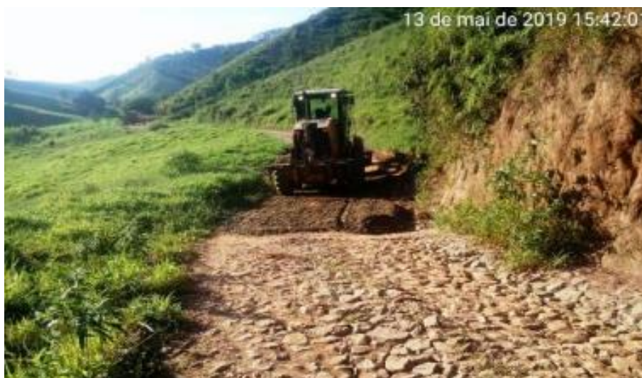
Foto relacionada à: Manutenção de Acessos Não Pavimentados – Trecho Gesteira/Tabuoes (Maio/2019).
