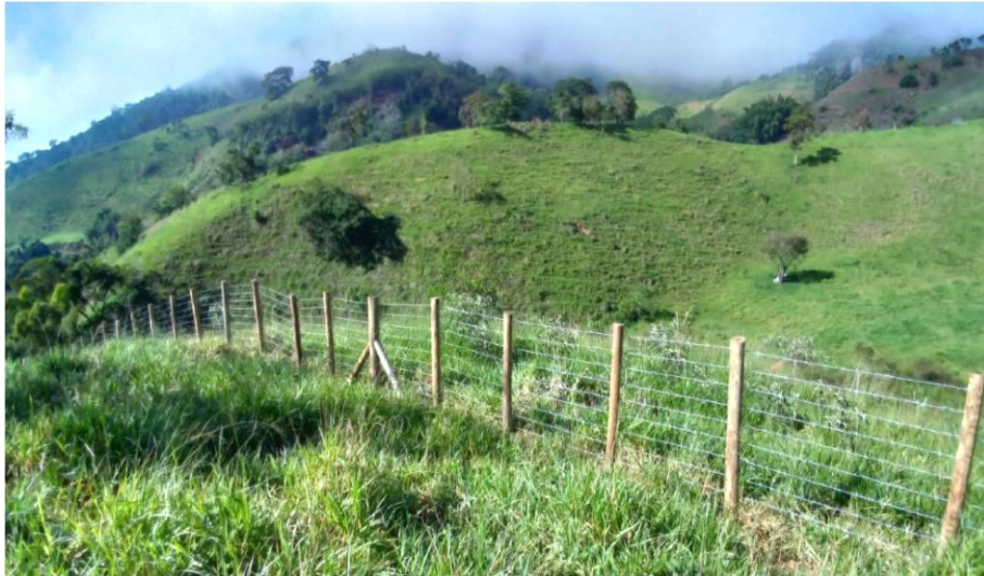
Foto relacionada à: Execução do cercamento da poligonal – maio/2019.
