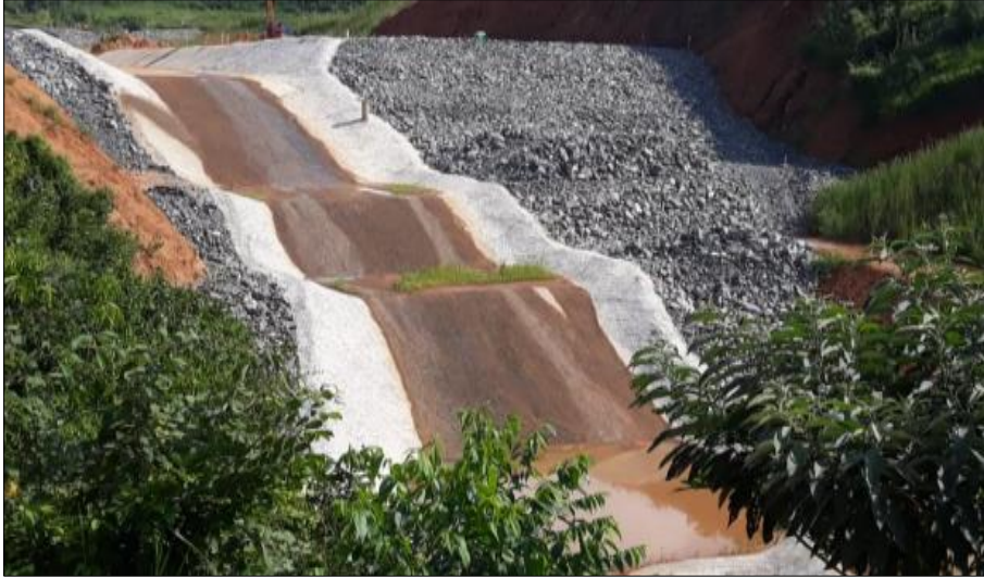
Foto relacionada ao: Canal Extravasor Provisório do setor 11 - Maio/19.
