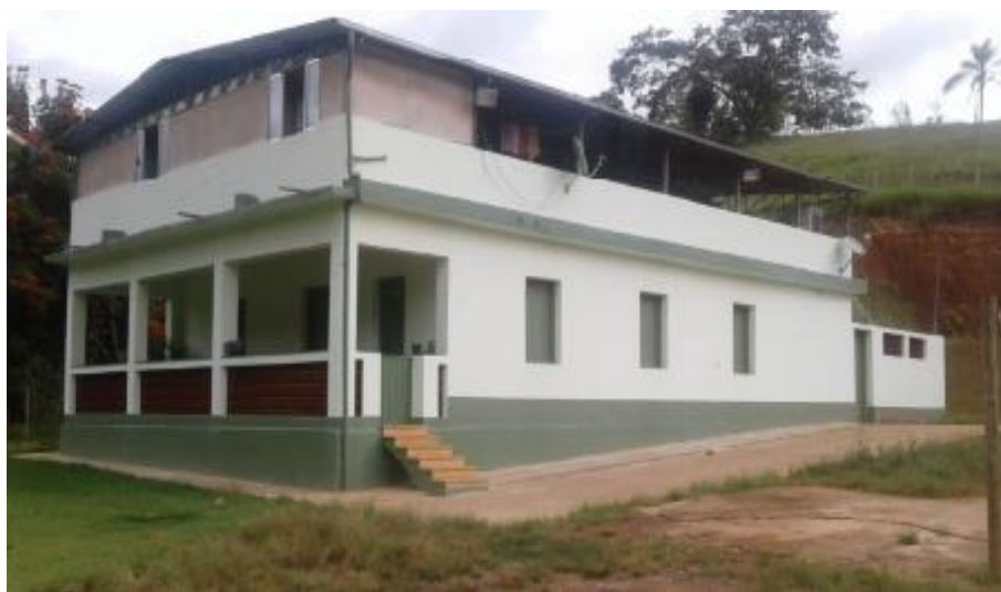
Foto relacionada à: Manutenção de Edificações – Z.M.C. (Maio/2019).
