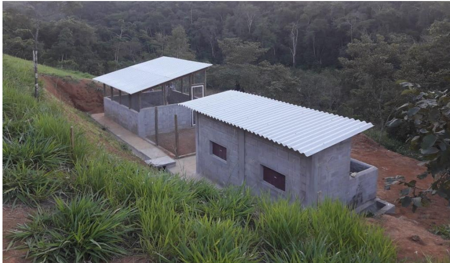
Foto relacionada à: Estruturas de Apoio – W.P. (Maio/2019).
