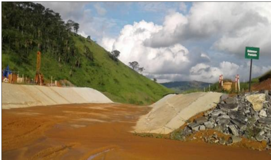
Foto relacionada ao: Canal Extravasador Provisório do setor 11 - Maio/19.
