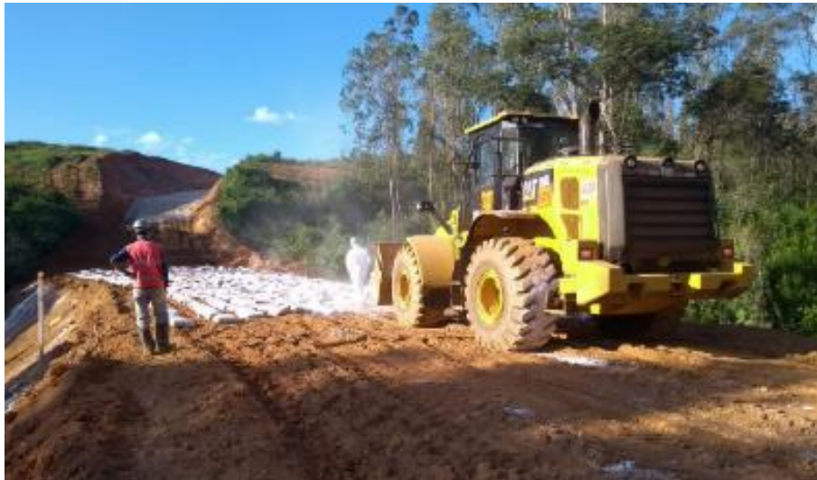
Foto relacionada ao: Desvio Provisório – Tratamento de Aterro (Cal) - maio/2019.
