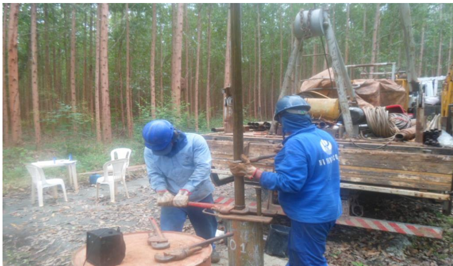
Foto relacionada à: recuperação de um dos poços em Cachoeira Escura, distrito de Belo Oriente/MG – Maio/2019.
