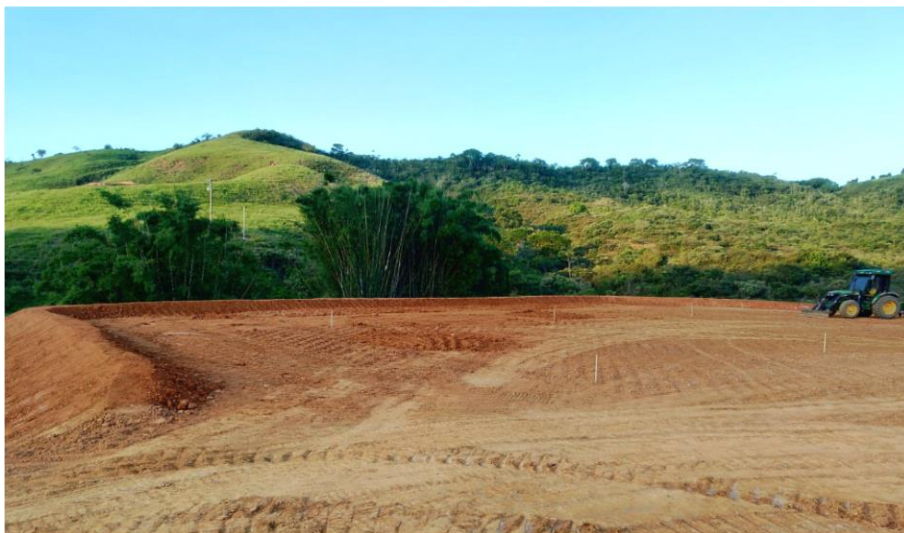
Foto relacionada à: Execução terraplenagem canteiro contratadas – maio/2019
