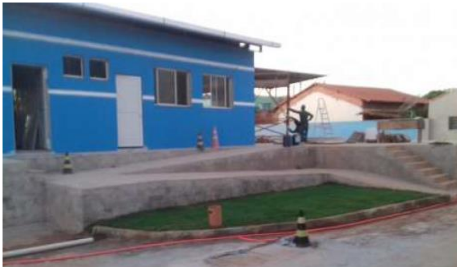
Foto relacionada à: conclusão das obras da Casa de Química da ETA de Galiléia/MG – Maio/2019.
