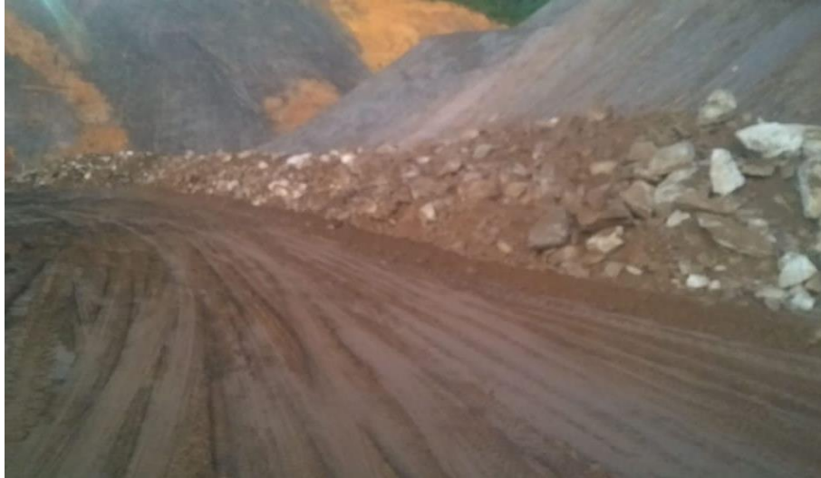
Foto relacionada à: Bota espera de material do tipo E1 – maio/2019.
