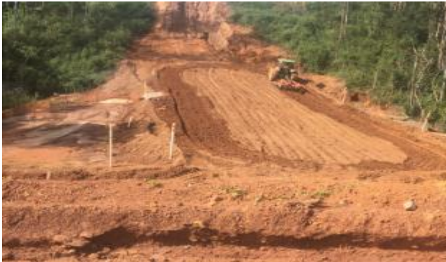
Foto relacionada à: Desvio Provisório - Compactação de Aterro - abril/2019.
