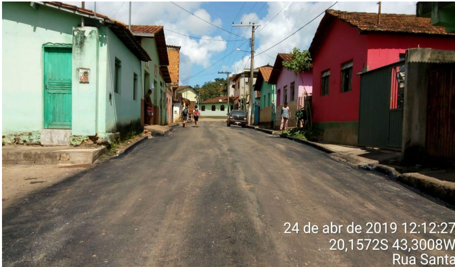
Foto relacionada à: Manutenção de Acessos Pavimentados - Trecho Fonseca/Rua Santa (Abril/2019).
