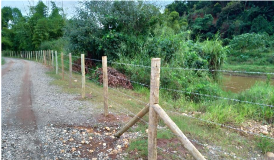
Foto relacionada à: Execução do cercamento da poligonal – abril/2019.
