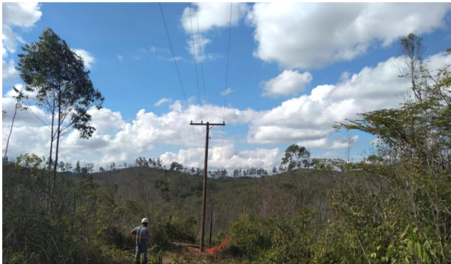
Foto relacionada à: Execução da rede externa de alimentação elétrica – abril/2019
