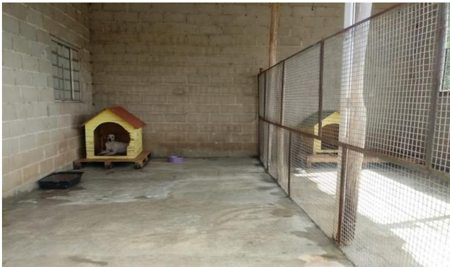
Foto relacionada à: Finalização da reforma do CATA 1 Adequação de piso em recinto – maio/2019.
