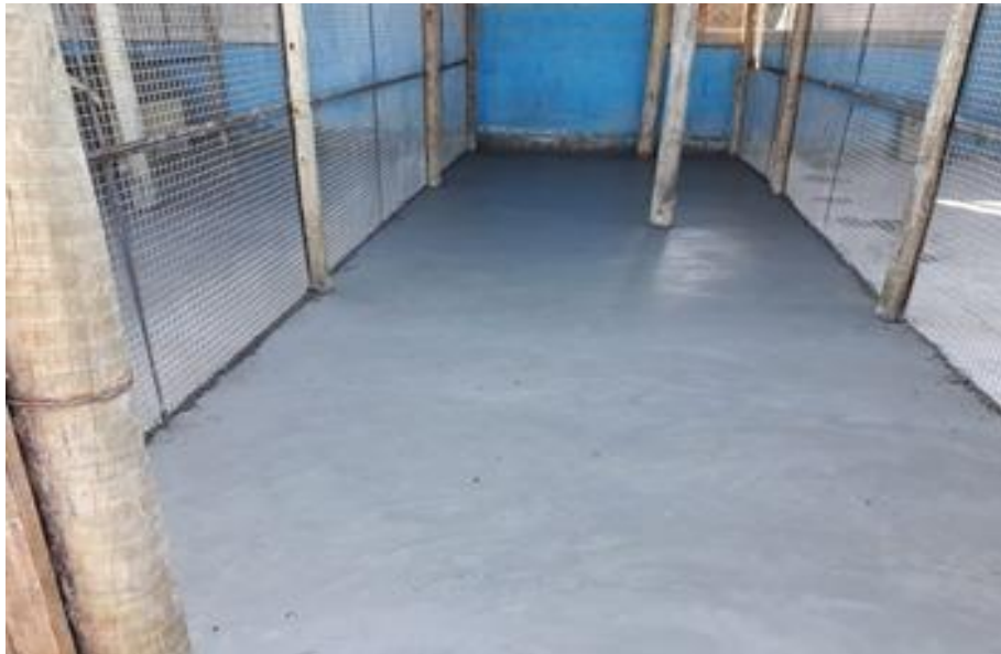
Foto relacionada à: Manutenção de Edificações - Fazenda Asa Branca (Abril/2019).
