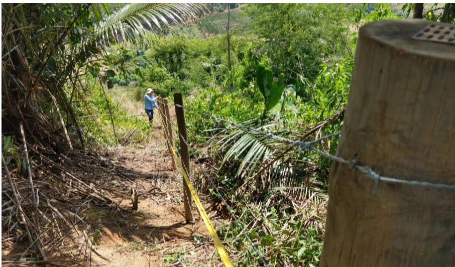
Foto relacionada à: Medição para as-built de cercas Pancas/ ES.
