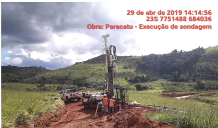
Foto relacionada à: Execução de sondagem – abril/2019
