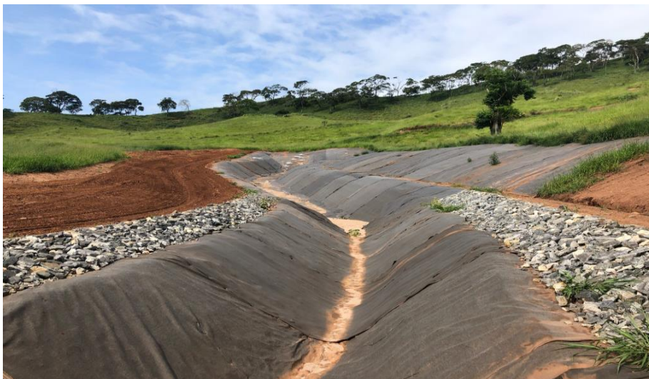
Foto relacionada à: Proteção dos drenos de fundo da Pilha 2 com geobags, - abril/19.
