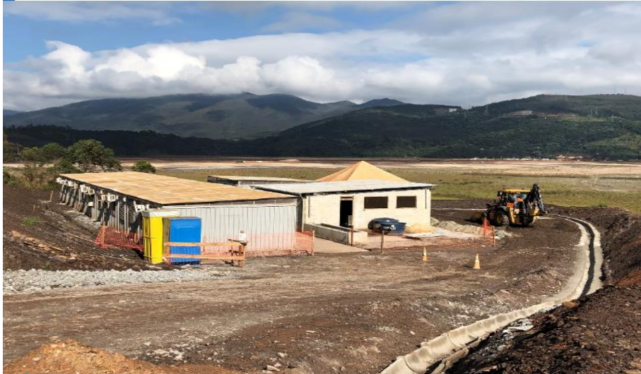
Foto relacionada ao: Vestiário Canteiro Salum Fugro – abril/2019.
