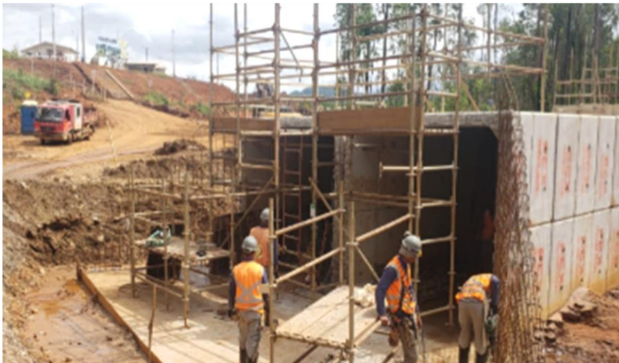
Foto relacionada à: Rua São Bento - Execução de Ala (Bueiro - E-31) – abril/2019
