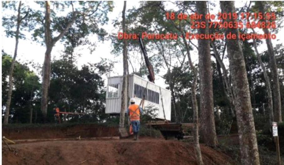
Foto relacionada à: Instalação container portaria Rua Furquim – abril/2019.
