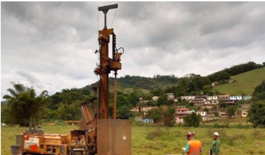
Foto relacionada à: Sondagens do terreno – abril/2019
