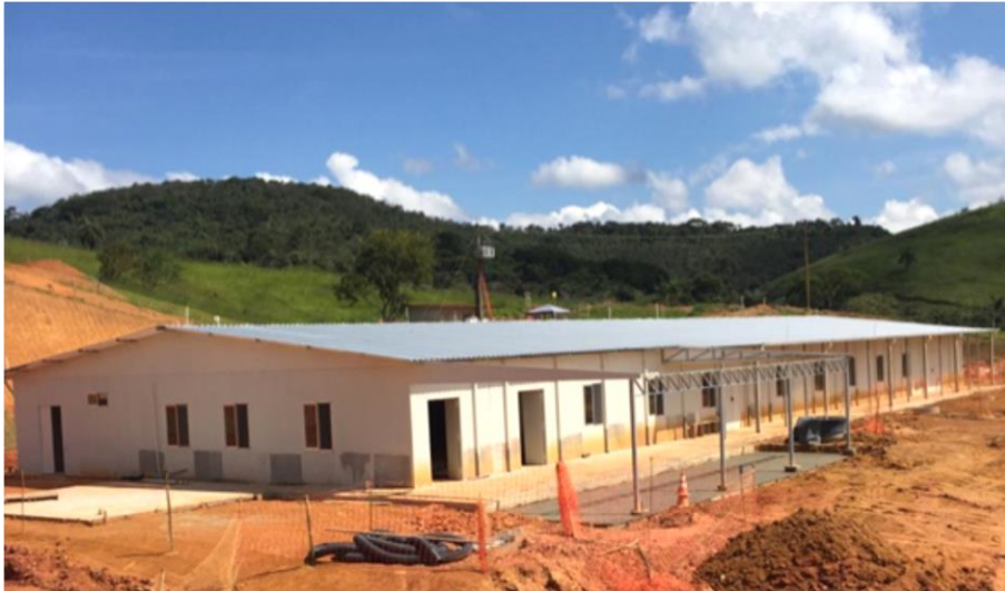
Foto relacionada à: Execução do refeitório – canteiro de obras – abril/2019.
