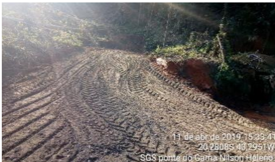
Foto relacionada à: Manutenção de Acessos Não Pavimentados - N.H.P. (Abril/2019).
