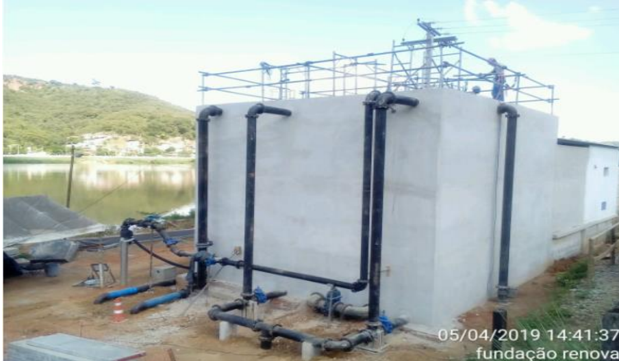
Foto relacionada às: Obras civis no Poço C01 em Resplendor/MG – abril/2019
