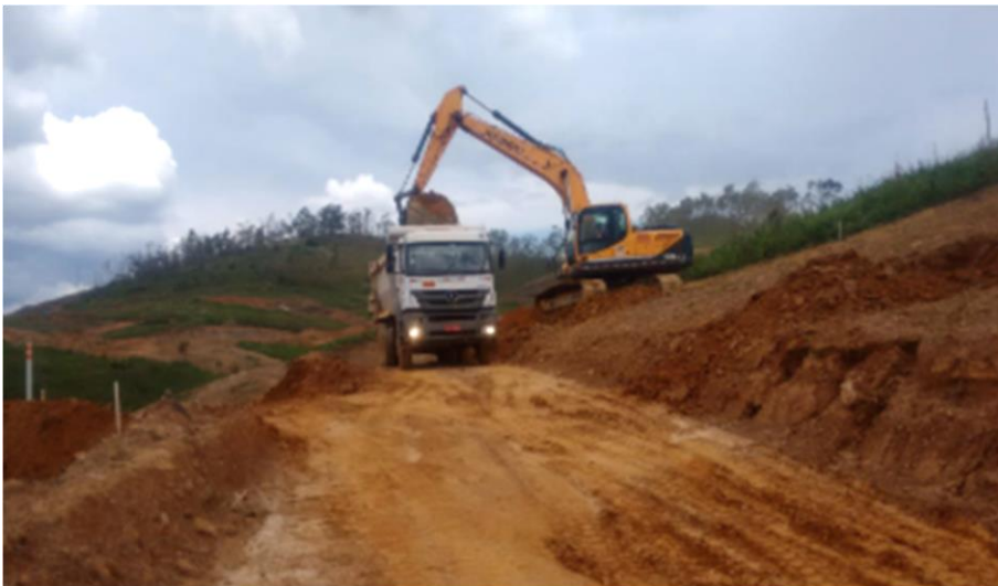
Foto relacionada à: Área 1 – Terraplenagem da Rua Carlos Pinto – abril/2019
