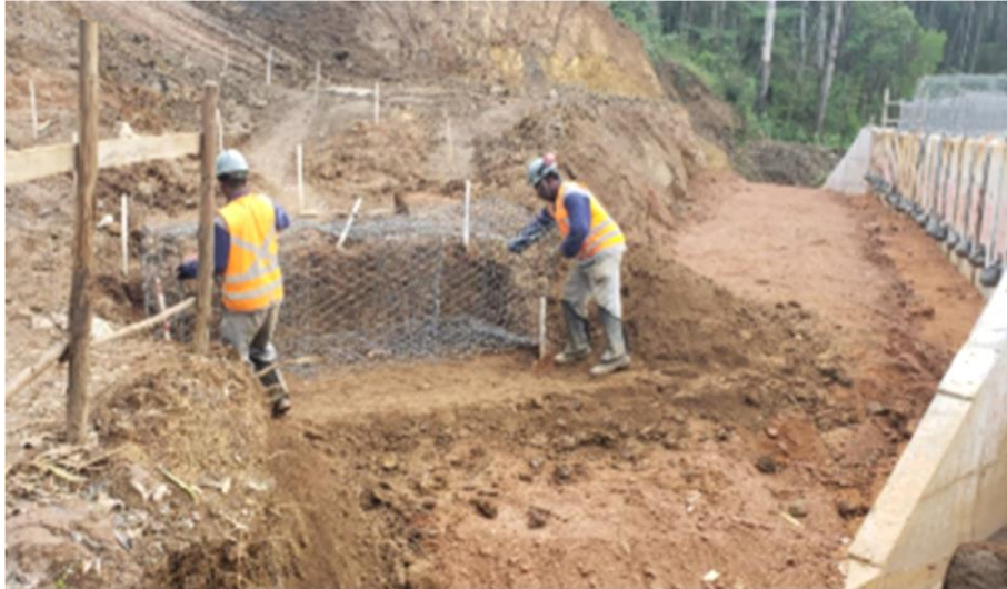
Foto relacionada à: Execução da Contenção 4 – Terramesh – abril/2019.
