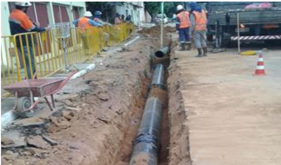
Foto relacionada ao: Lançamento da tubulação (Km 0,00 ao 0,14) do ramal ETA Santa Rita da adutora em Governador Valadares/MG – abril/2019
