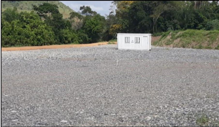
Foto relacionada ao: Novo Canteiro de Obras – AREAL/MG - abril/19.
