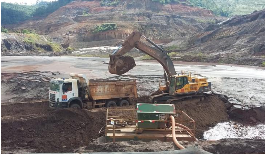
Foto relacionada à: Escavação Sole Mole – abril/2019.
