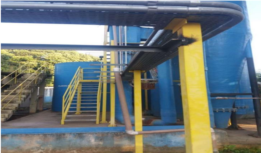
Foto relacionada à: Montagem e soldagem da estrutura de apoio da eletrocalha da ETA de Cachoeira Escura/MG – abril/2019.
