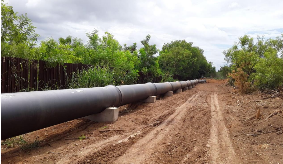
Foto relacionada ao: Lançamento da tubulação da Adutora em Governador Valadares/MG no trecho aéreo km 28,6 a 31,5 – abril/2019.
