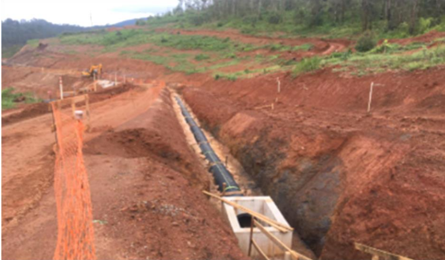
Foto relacionada à: Drenagem Pluvial – Rua Dona Olinda – abril/2019.
