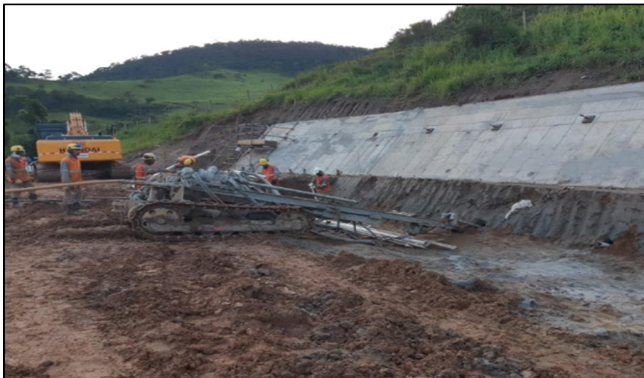
Foto relacionada ao: Ponto 115 – Armação, perfuração, instalação de tirantes e concretagem - abril/19.
