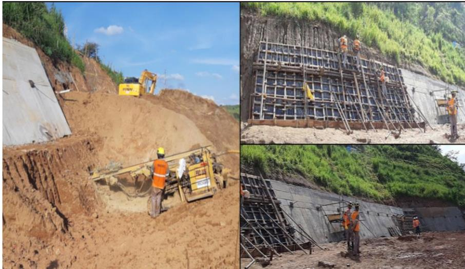
Ponto: 115 – Armação, Perfuração, instalação de tirantes e concretagem – Minas Gerais - Março/2019
