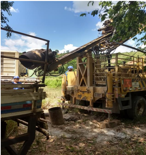
Figura 1- Naknenuk - 2ª tentativa de perfuração de poço
