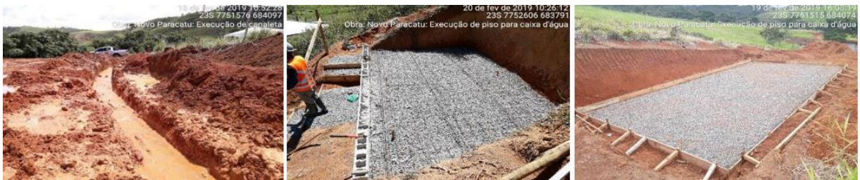
Figura 13 – Execução canaleta platô refeitório
