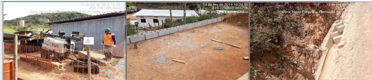
Figura 07 – Mobilização da torre de iluminação
