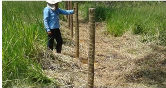
Figura 2: Inspeção de atividade de cercamento, Periquito (MG)
