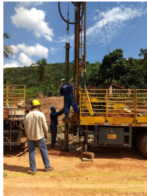
Figura 2 - Atorã - 1ª tentativa de perfuração de poço
