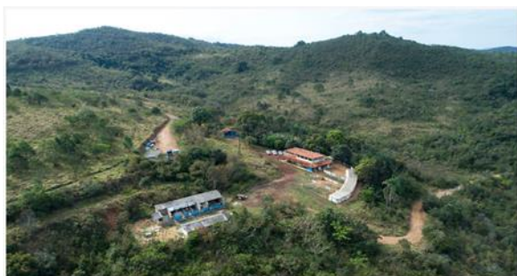
Figura 1: Vista área do CATA 1
