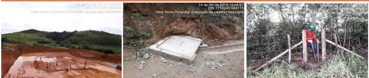
Figura 16 – Execução de forma para piso do refeitório
