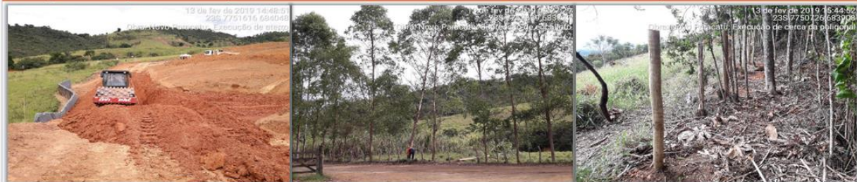
Figura 10 – Execução de aterro
