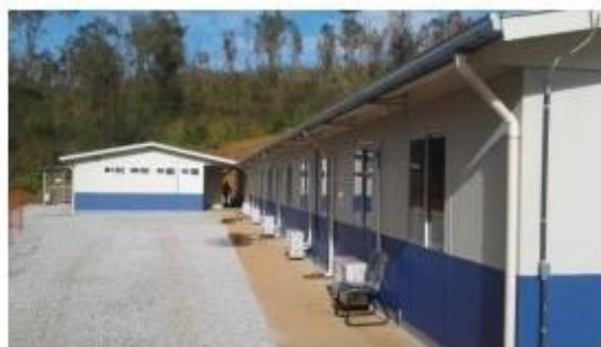
Foto Ambientação do Canteiro de Obras - Reassentamento Bento Rodrigues | julho/2018 (Crédito: Divulgação Fundação Renova)
