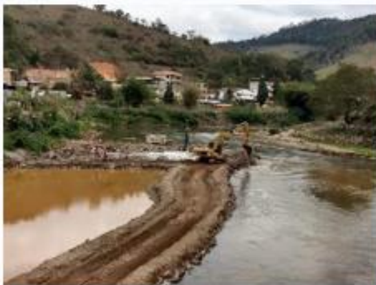
Remoção de constrições no Trecho 10
