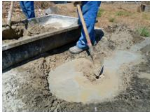
Tamponamento de poço tubular realizado em Santo Antônio do Rio Doce (Mauá), município de Aimorés/MG
