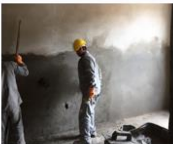
Reconstruções - Casa 2 – José Arlindo - Reboco das alvenarias internas
