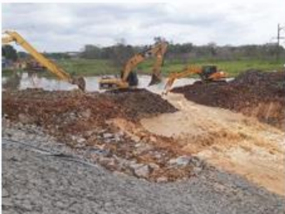
Conclusão do alargamento do canal em Rio Pequeno e início da abertura da enseadeira para permitir o rebaixamento do nível de água da Lagoa Juparanã
