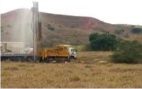
Perfuração de poço tubular na localidade de Senhora da Penha, município de Fernandes Tourinho/MG.
