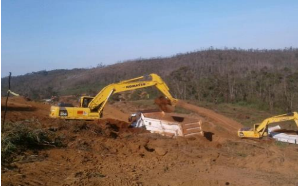
Terraplanagem – setembro/2018 (Crédito: Divulgação Fundação Renova)
