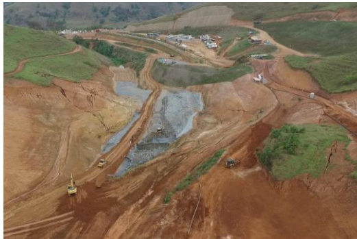
Dique intermediário – vista geral – setembro/2018 (Crédito: Divulgação Fundação Renova)
