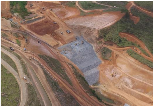
Dique principal – aterros em argila e enrocamento – setembro/2018 (Crédito: Divulgação Fundação Renova)
