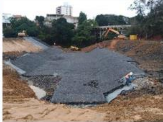
Preparação do canal do Rio Pequeno com colchão reno, em Linhares/ES
