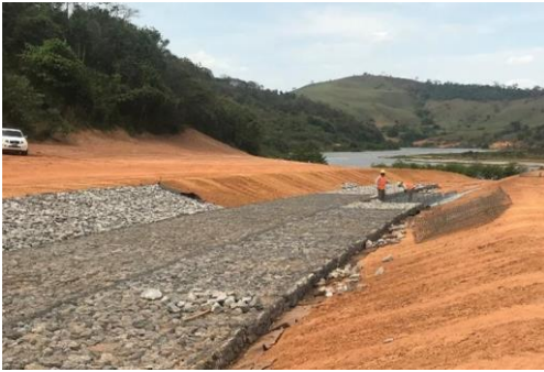
Setor 6 - Colchão Reno – setembro/2018 (Crédito: Divulgação Fundação Renova)
