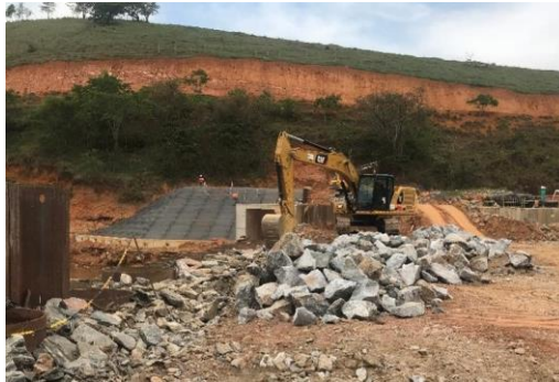
Barramento C – enrocamento à jusante – setembro/2018 (Crédito: Divulgação Fundação Renova)
