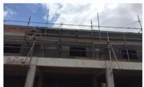
Reconstruções - Casa 4 – Sebastião Celestino - Chapisco das alvenarias externas.
