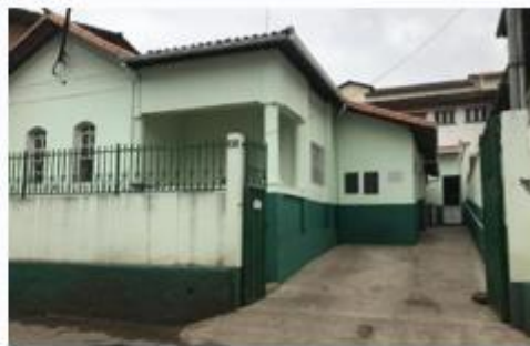
Unidade de Saúde Bento Rodrigues e Paracatu, onde será reformado o telhado. Mariana - 28/09/2018
