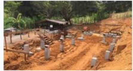
Reconstruções - Casa 7 – Geraldo Pedro Reaterro das sapatas.
