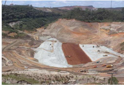
Eixo 1 – ensecadeira e maciço – setembro/2018 (Crédito: Divulgação Fundação Renova)
