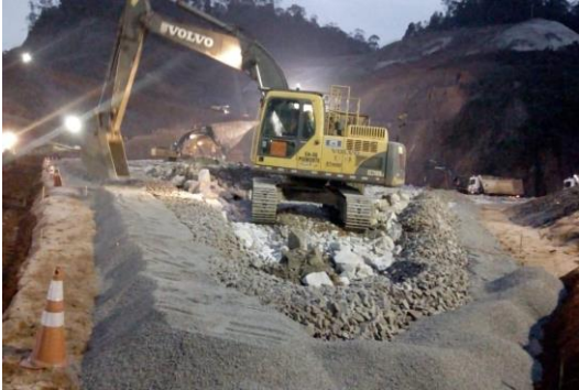
Eixo 1 – construção do filtro inclinado – setembro/2018 (Crédito: Divulgação Fundação Renova)
