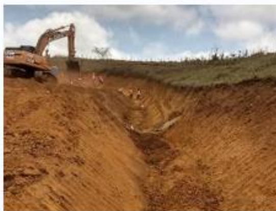
Obras no aterro de rejeitos em Barra Longa/MG
