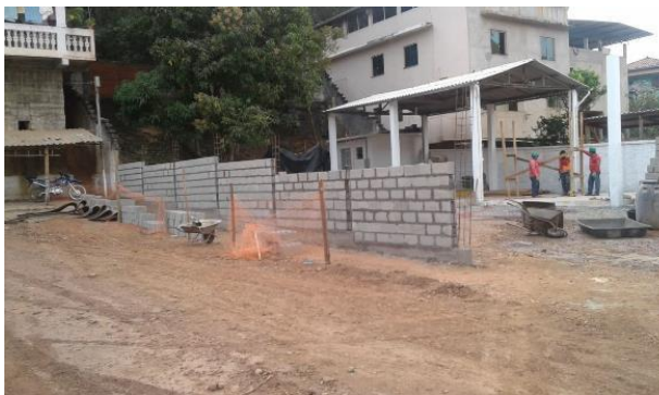
Construção do muro da Fábrica de Manilhas - Barra Longa - setembro/2018 (Crédito: Divulgação Fundação Renova)
