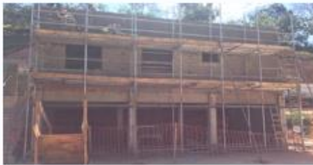
Reconstruções - Casa 6 – Maria da Conceição Reboco e chapisco alvenarias internas e externas
