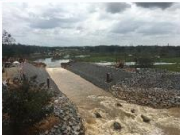
Primeira etapa da abertura da enseadeira concluída
