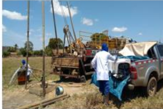
Perfuração de poço tubular na localidade de Senhora da Penha, município de Fernandes Tourinho/MG.
