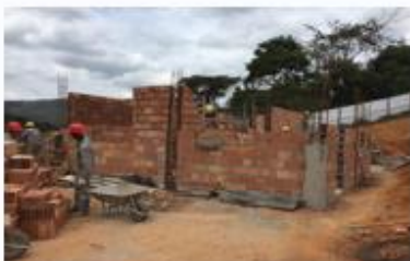
Reconstruções - Casa 5 – Josimar e Manoela - Execução de alvenaria 1º Pavimento
