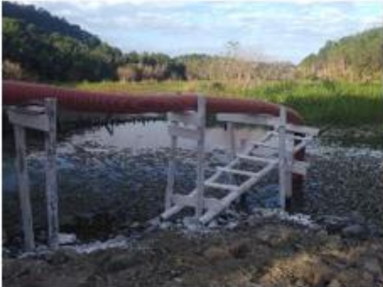
Bomba de drenagem operando na área brejosa em Patrimônio da Lagoa/ES
