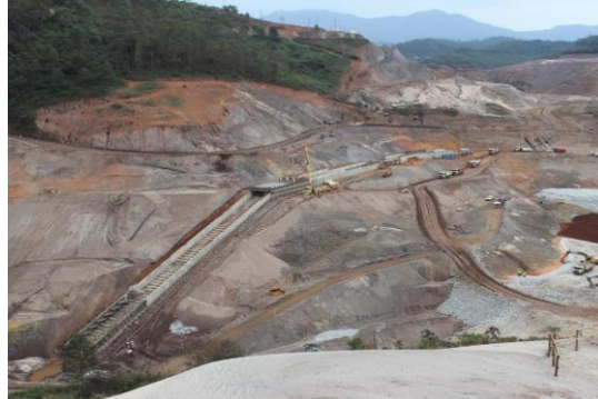
Eixo 1 – vertedouro principal – setembro/2018 (Crédito: Divulgação Fundação Renova)
