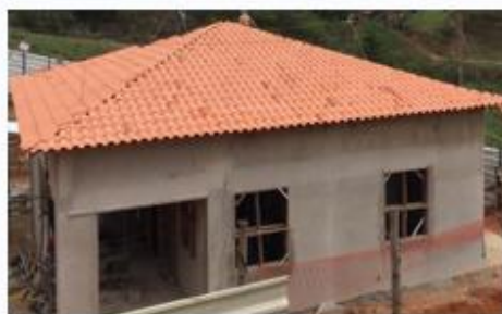
Reconstruções - Casa 3 – Tereza Tette Montagem do telhado
