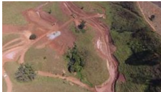
Dique intermediário – execução de contrapilhamento – agosto/2018 (Crédito: Divulgação Fundação Renova)
