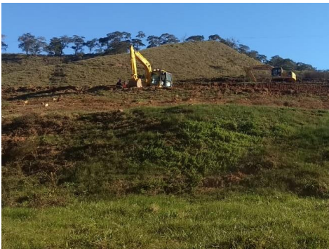
Obras no aterro de rejeitos em Barra Longa/MG– agosto/2018 (Crédito: Divulgação Fundação Renova)
