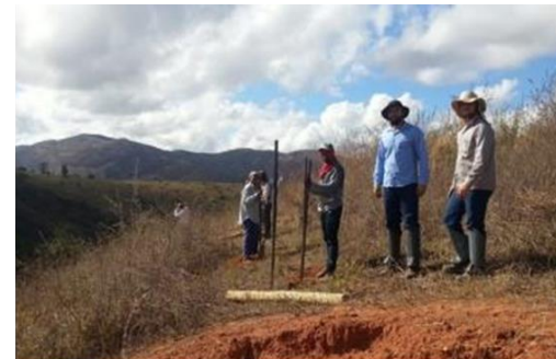
São Vitor/MG Acompanhamento de execução de cercamentos
