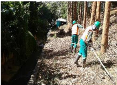
Início da supressão vegetal para realização da obra da adutora de Governador Valadares
