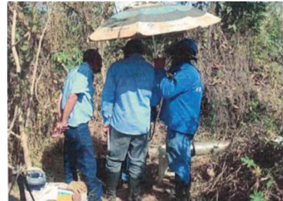
Limpeza do poço em Itueta - Sede
