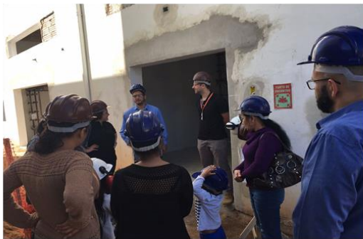
Visita às obras da Escola Paracatu de Baixo
