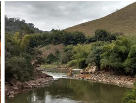
Obra de remoção de constrições no rio carmo - Barra Longa
