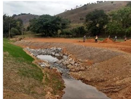
Execução de obras de recuperação do Sítio Caatinga
