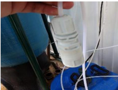
Instalação da válvula dosadora - Barra Longa - Gesteira
