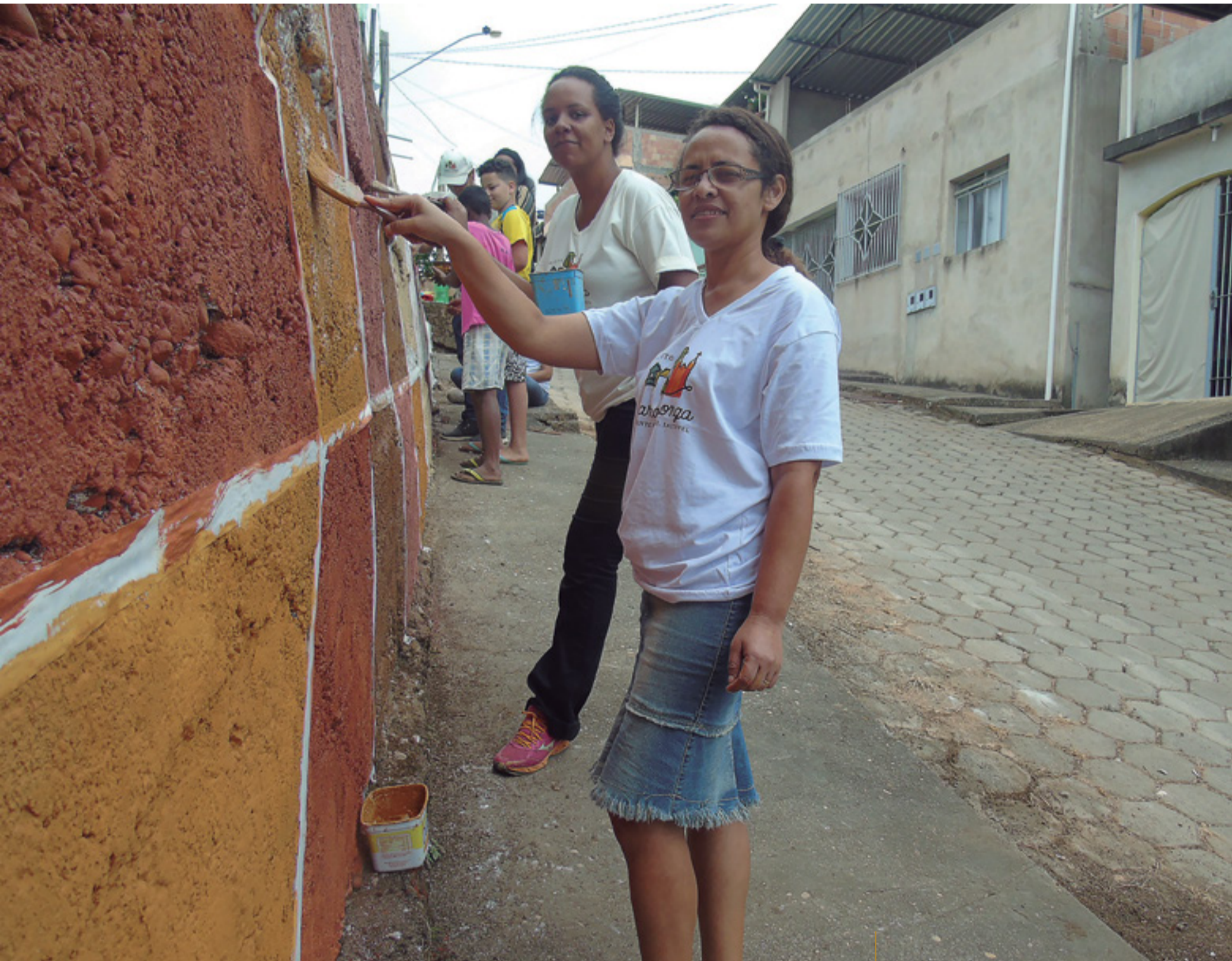
Muros pintados com tinta de terra
